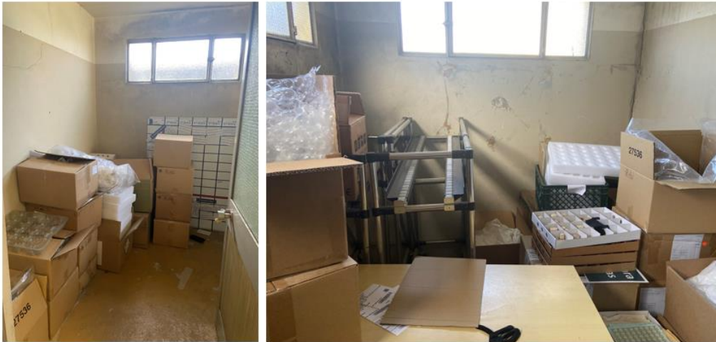
Figura 21 - Situação inicial da sala de aprovisionamento dos produtos de alto valor acrescentado
