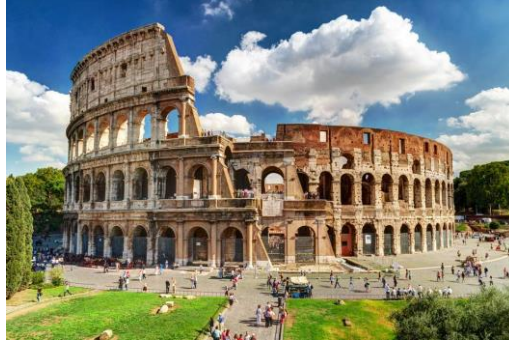
Figura 2-7 - Coliseu de Roma - exemplo de construção em arcos
