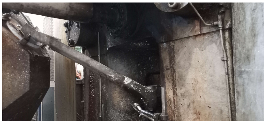
Figura 21 - Alimentação de alumínio por caleira
