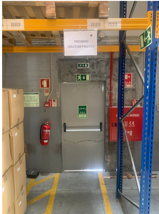
Figura 45 – Zona de saída sinalizada
