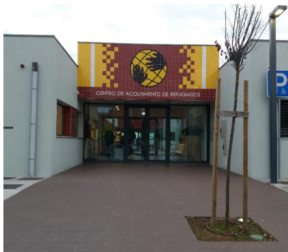
Entrada do CAR 2 em São João da Talha
