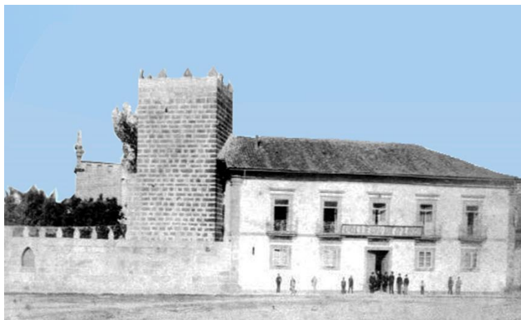
Figura 2 - Instalações da Casa da Torre
