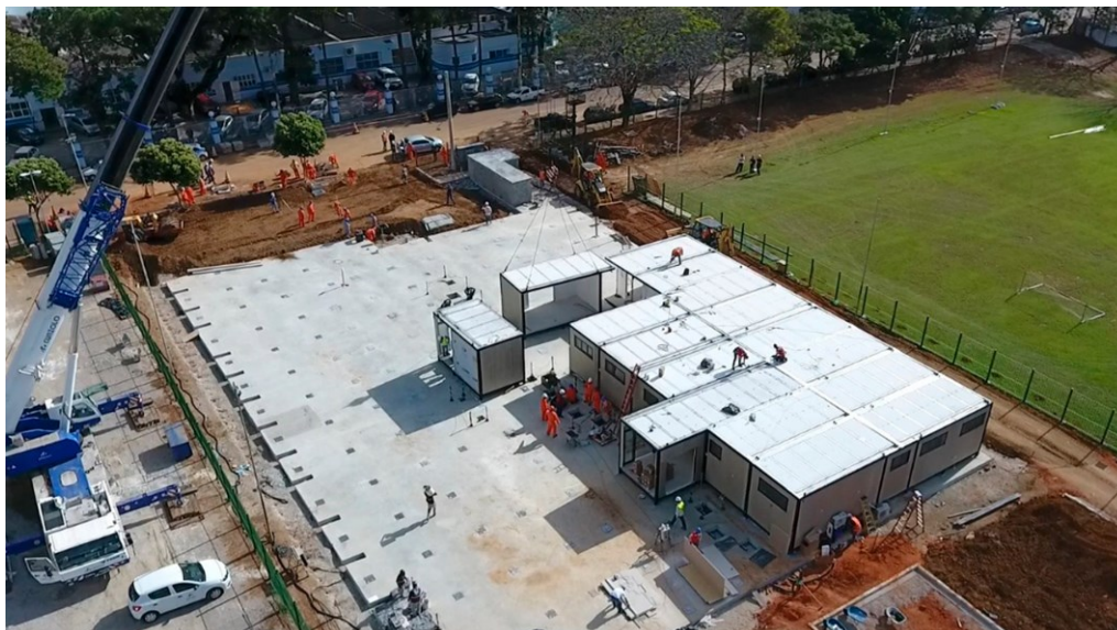
Figura 26 - Acoplagem do Módulo in-situ [18].
