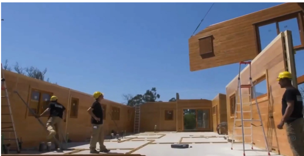
Figura 11 - Acoplagem dos vários painéis em obra [9].
