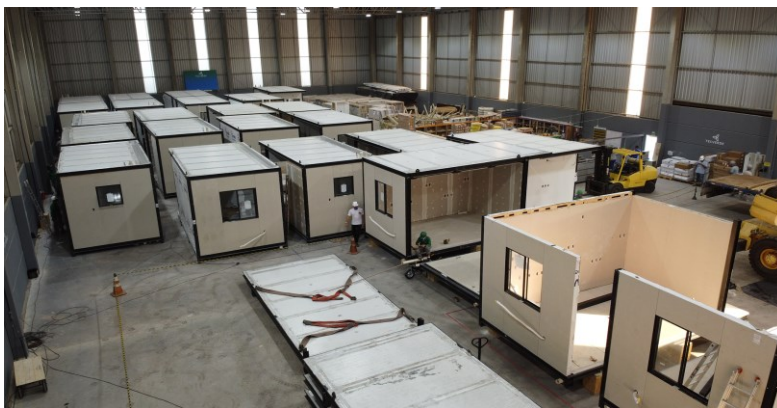
Figura 24 - Montagem do Módulo [18].
