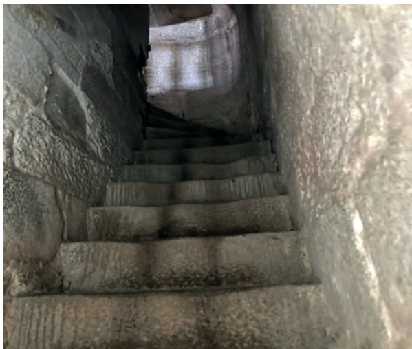
Imagem 1. Escada de acesso ao coro.
