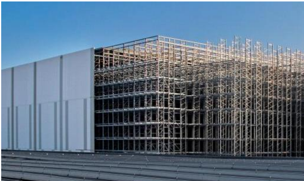
Figura 4 - Estrutura de armazenamento industrial (Stow-Group, 2021)
