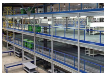
Figura 1.1 - Estruturas em mezanino (Stow-Group, 2022)
