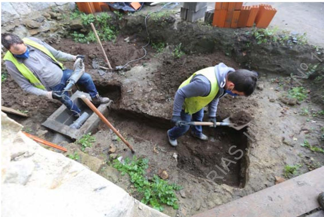
**Foto 38 (IMG\_2512)** – Acompanhamento dos trabalhos de implantação das caixas e tubos de saneamento.
