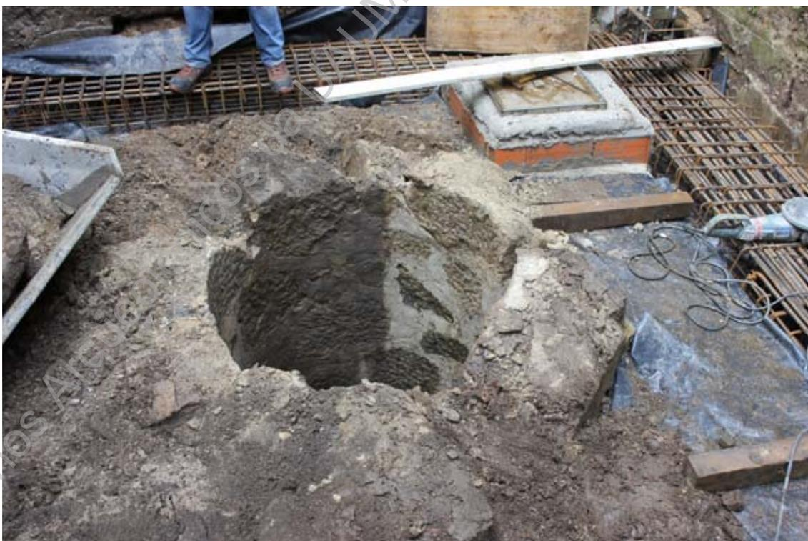
**Foto 59 (IMG\_9362)** – Acompanhamento da desmontagem da boca do poço UE010.
