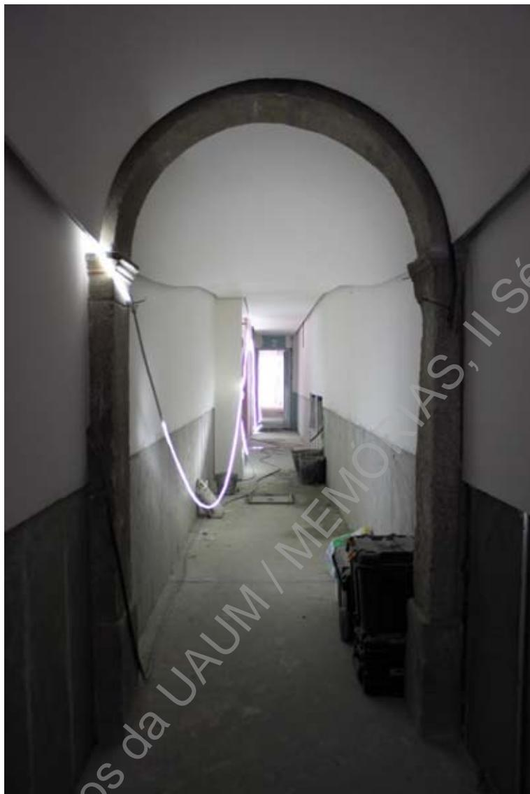
**Foto 81 (IMG\_8136)** – Aspeto final da integração de elementos de arco (UE016) no interior do atual edifício
