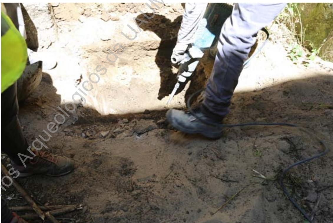
**Foto 9 (IMG\_9065)** – Levantamento do pavimento em cimento (UE023) para a realização da sondagem geofísica 3.
