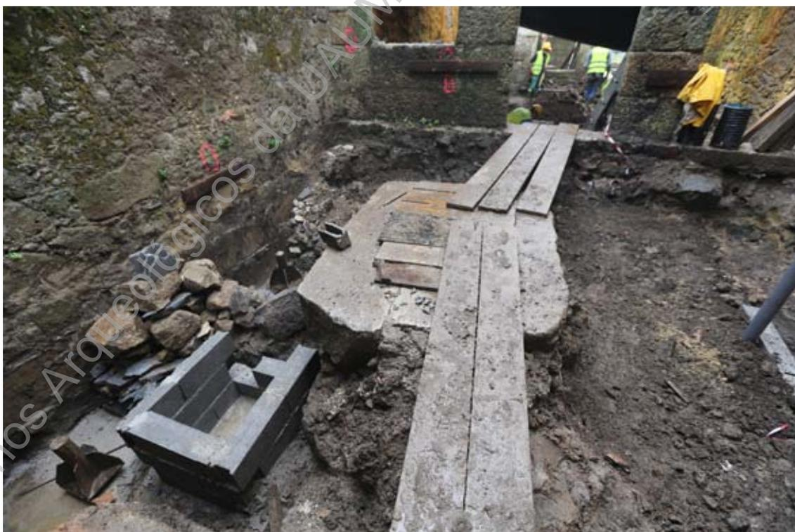
**Foto 37 (IMG\_1825)** – Acompanhamento dos trabalhos de implantação das caixas e tubos de saneamento.
