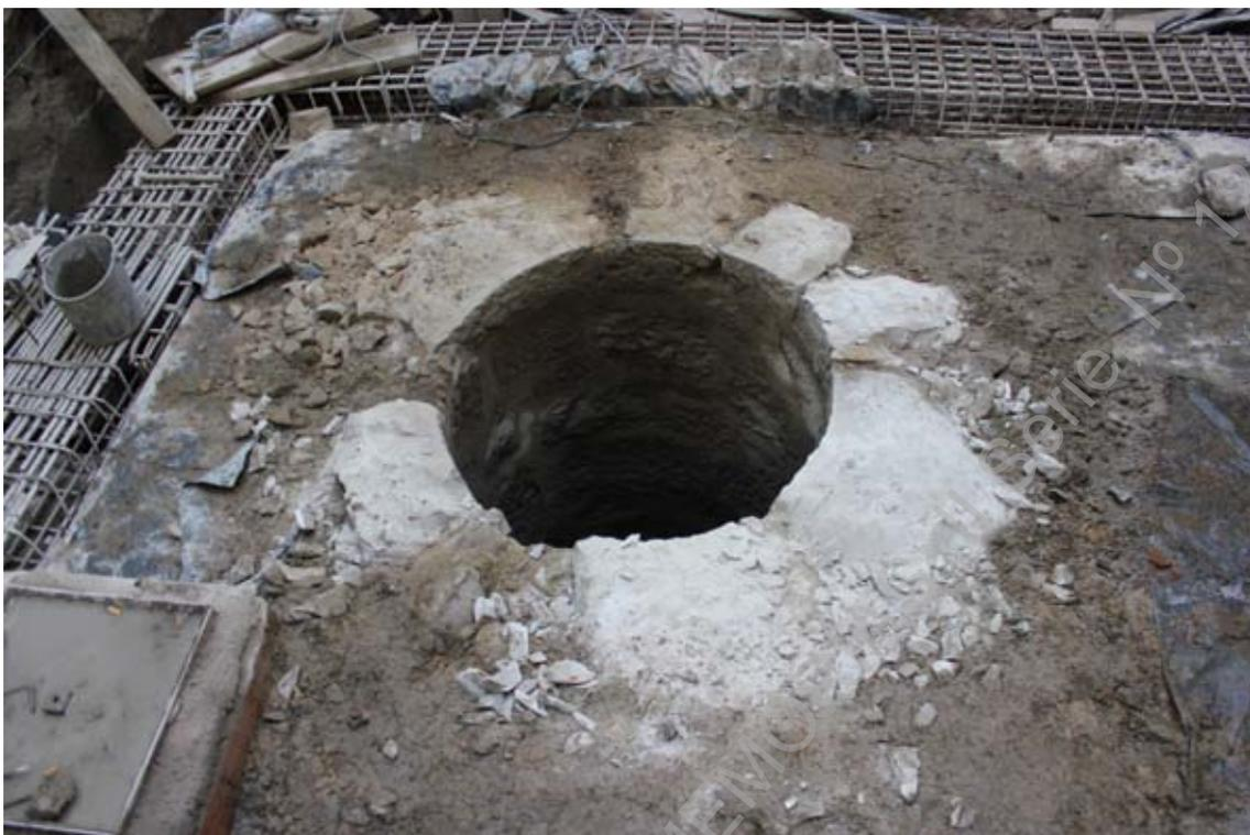
**Foto 60 (IMG\_9414)** – Registo do aspeto final dos trabalhos de remoção da boca e regularização da parede do poço UE010.
