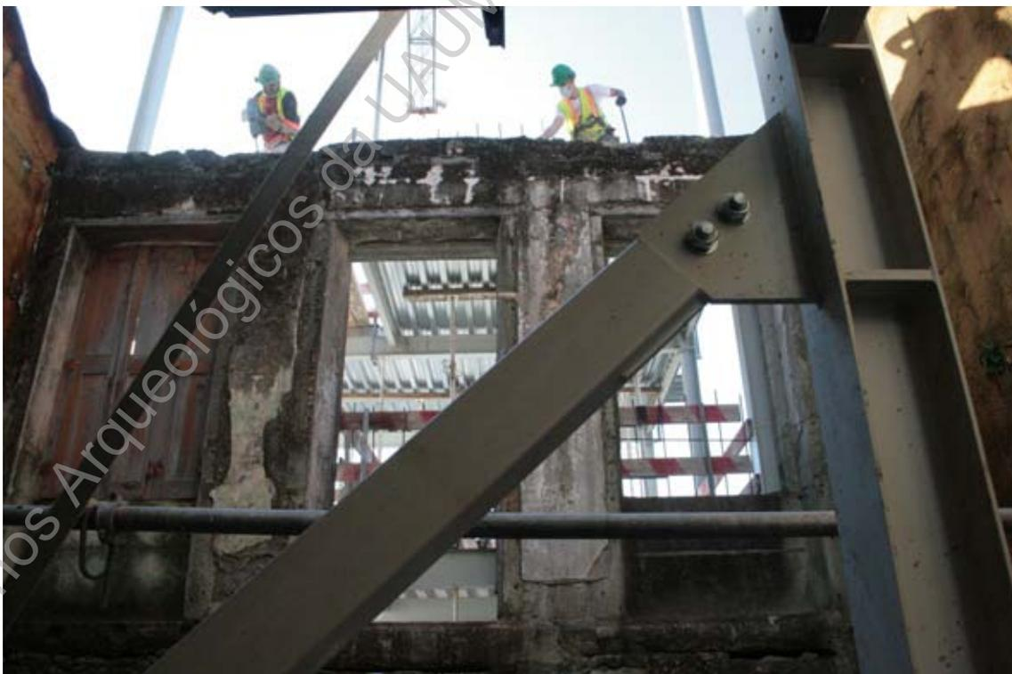
**Foto 73 (IMG\_0968)** – Acompanhamento do desmantelamento do muro UE025.
