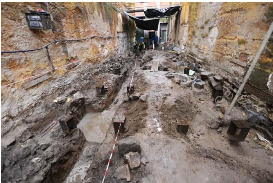
**Foto 34 (IMG\_1641)** – Acompanhamento dos trabalhos de implantação das caixas e tubos de saneamento.
