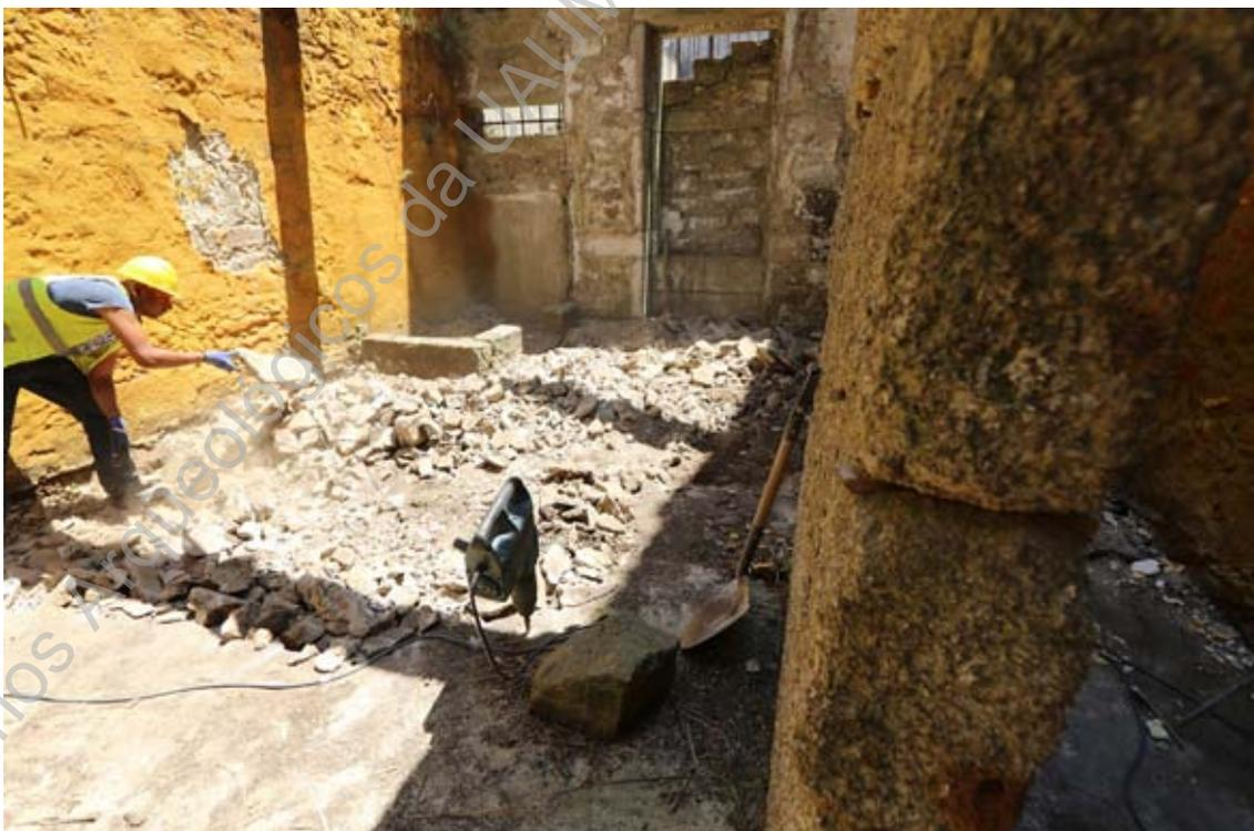
**Foto 13 (Z45A6569)** – Levantamento do pavimento em cimento (UE023) do lote.
