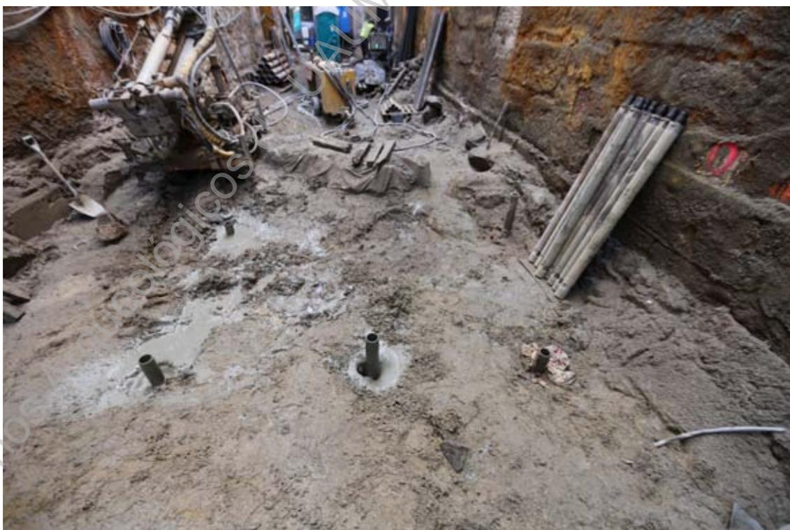
**Foto 31 (IMG\_1321)** – Acompanhamento dos trabalhos de implantação das estacas de fundação.
