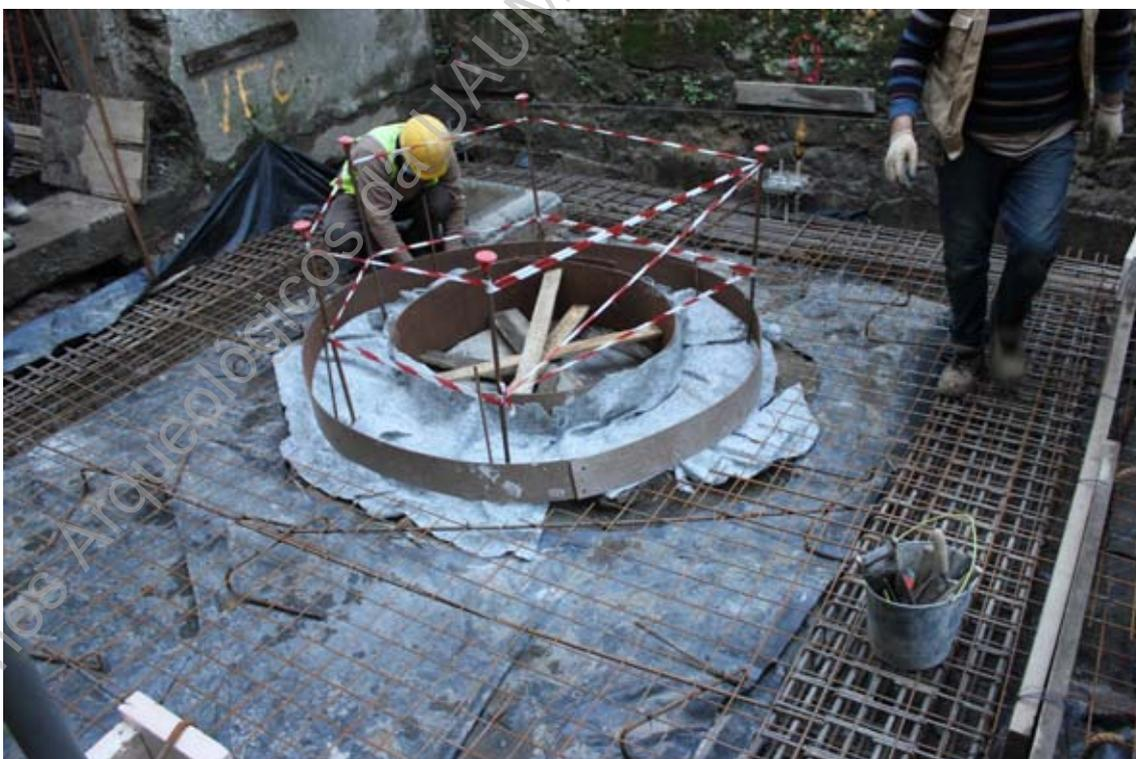
**Foto 61 (IMG\_9468)** – Proteção do poço UE010 e implantação das estruturas em ferro para a betonagem do lote.
