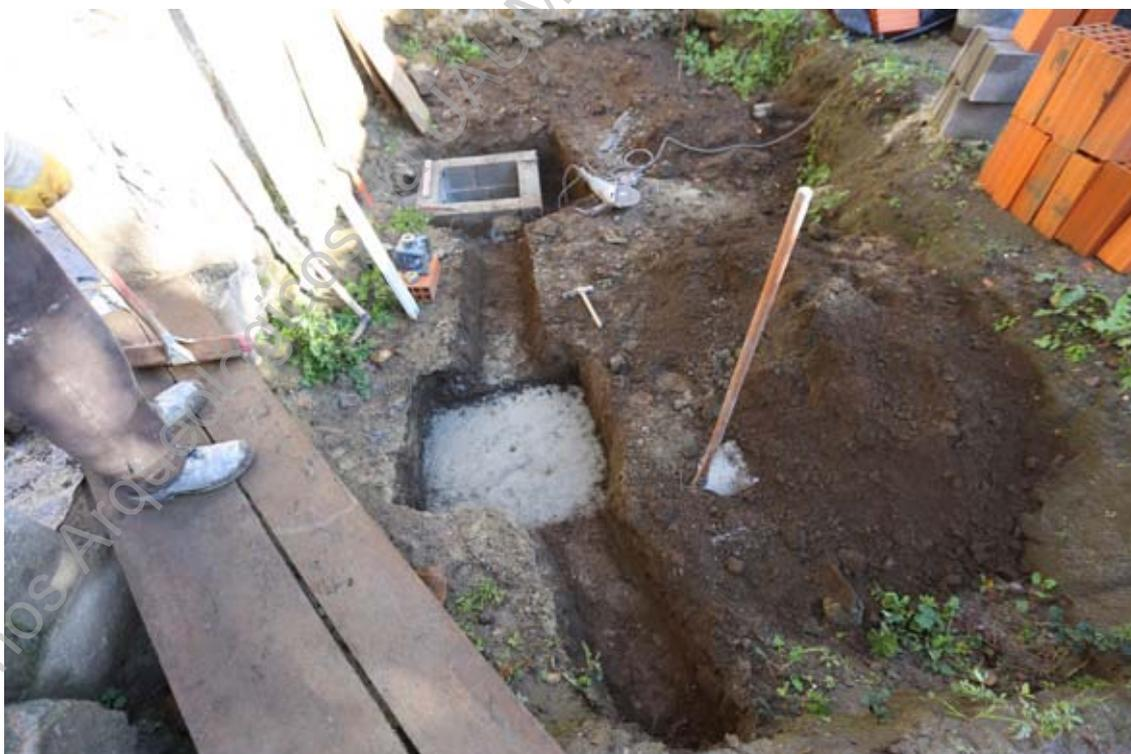
**Foto 39 (IMG\_2520)** – Acompanhamento dos trabalhos de implantação das caixas e tubos de saneamento.
