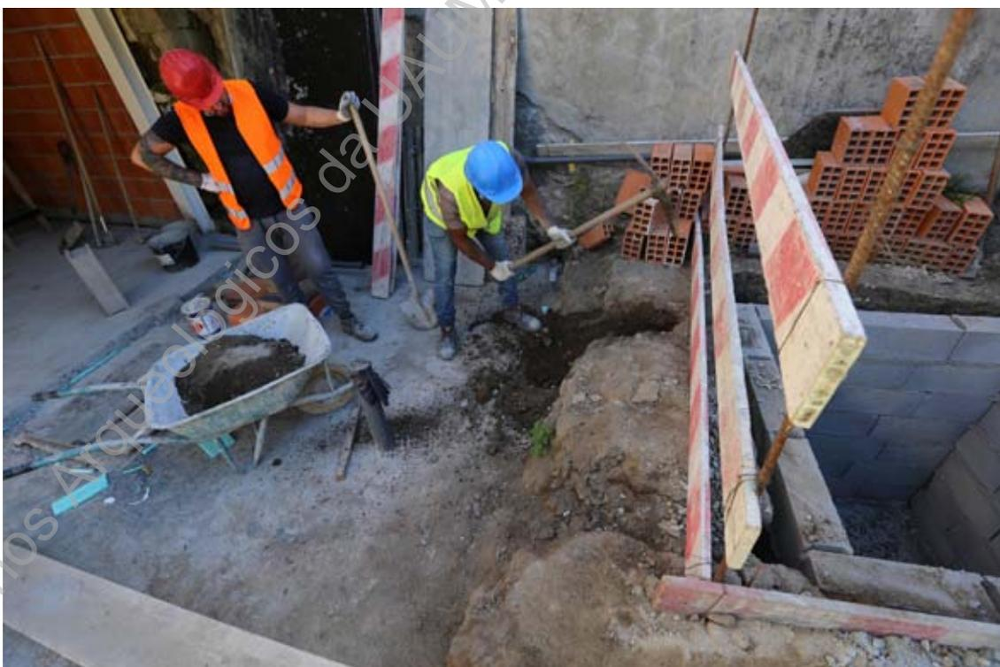
**Foto 77 (IMG\_3209)** – Acompanhamento da abertura da vala para a implantação de tubo de saneamento.
