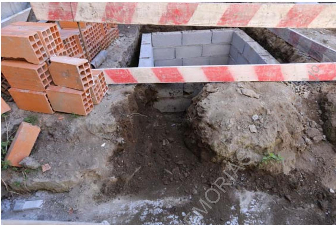
**Foto 78 (IMG\_3225)** – Aspecto final da vala para a implantação de tubo e caixa de saneamento na sondagem 2.
