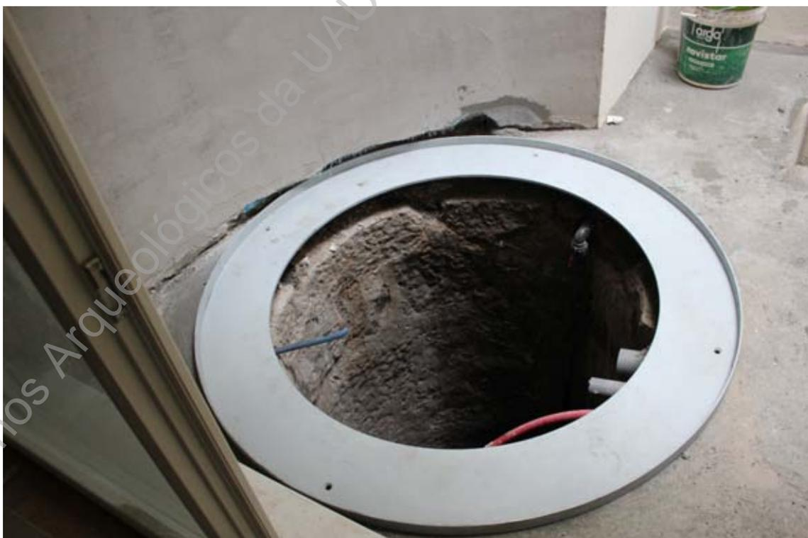
**Foto 83 (IMG\_8188)** – Colocação de estrutura de apoio para vidro.
