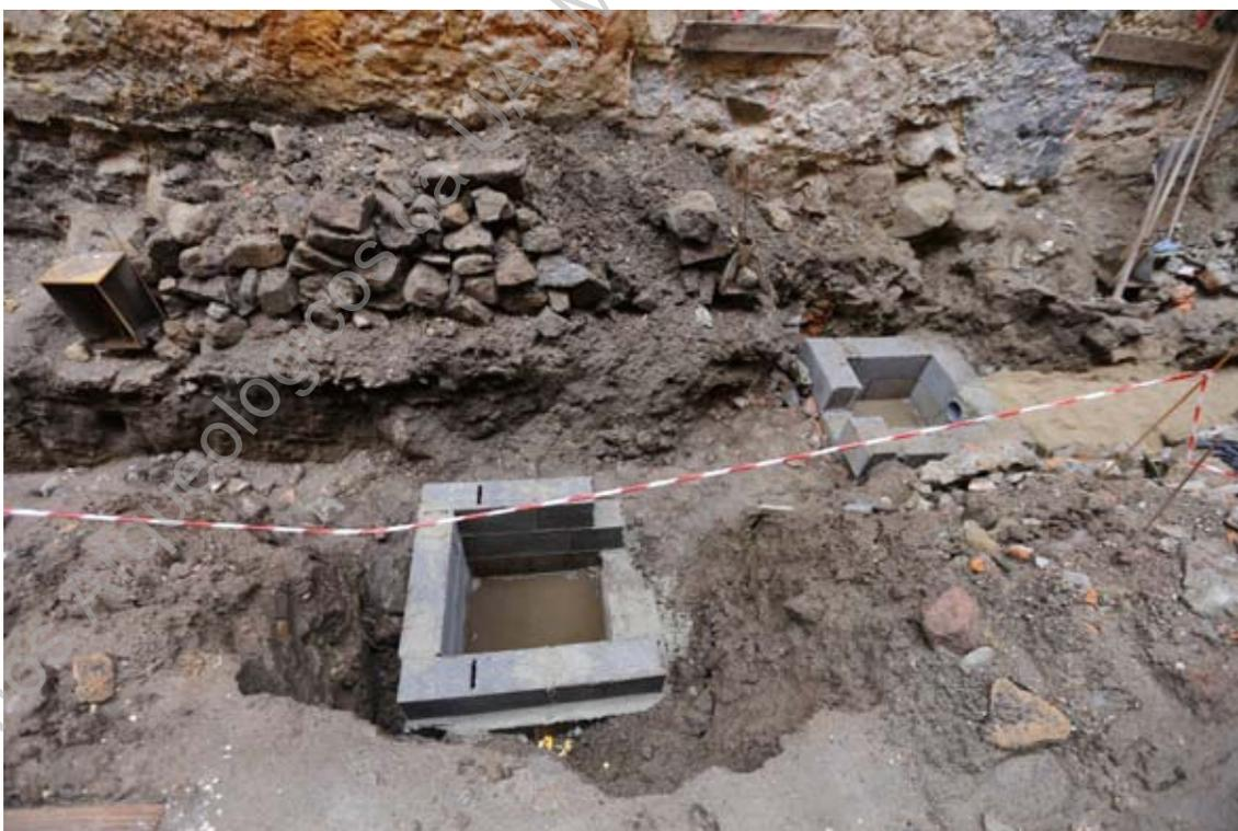
**Foto 35 (IMG\_1693)** – Acompanhamento dos trabalhos de implantação das caixas e tubos de saneamento.
