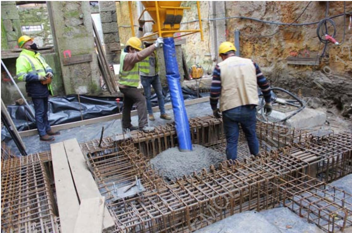
Foto 62 (IMG\_9477) – Acompanhamento da betonagem do lote.
