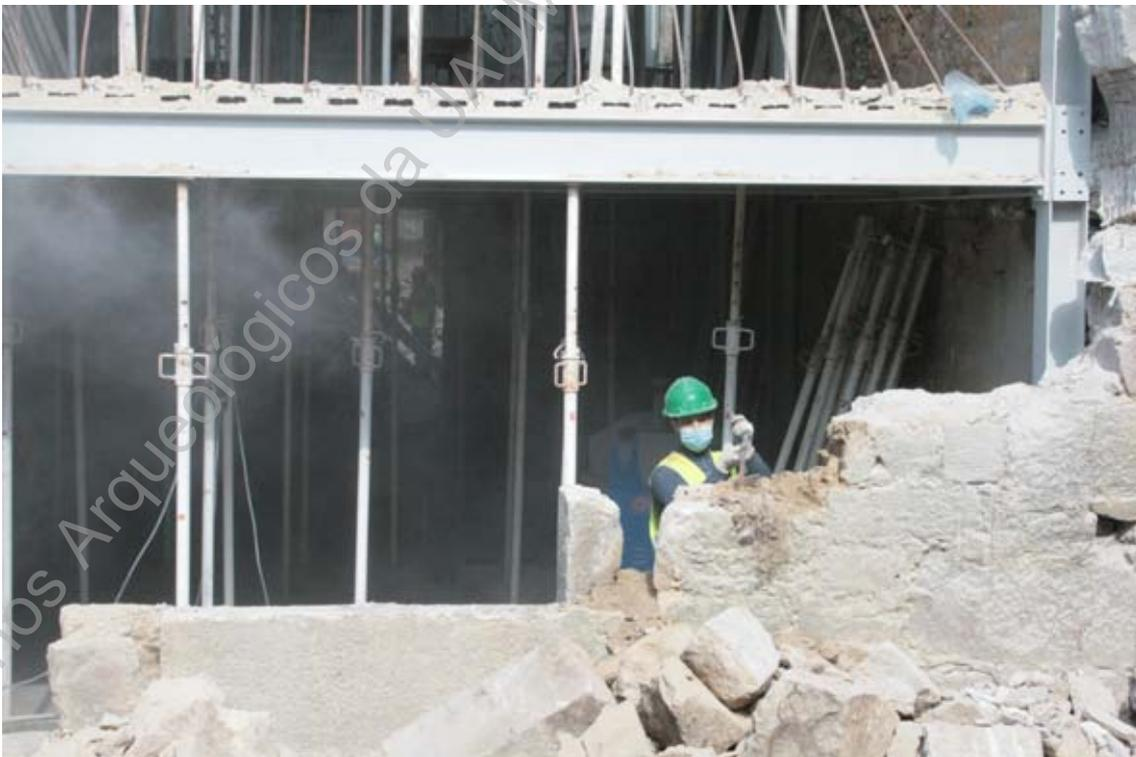
**Foto 71 (IMG\_0619)** – Acompanhamento do desmantelamento do muro UE024.
