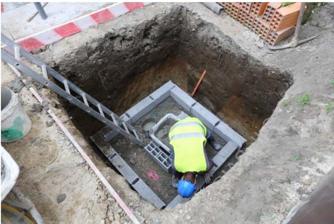
**Foto 76 (IMG\_3183)** – Acompanhamento da implantação da caixa de saneamento na sondagem 2.
