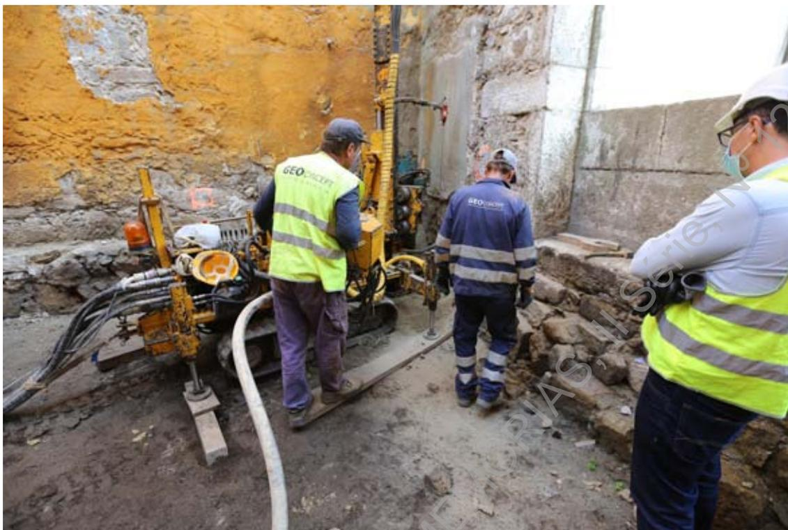
**Foto 28 (IMG\_1205)** – Acompanhamento dos trabalhos de implantação das estacas de fundação.
