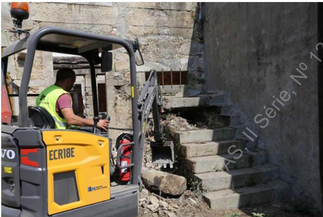
**Foto 16 (IMG\_0154)** – Acompanhamento dos trabalhos de demolição das escadas no logradouro do lote.
