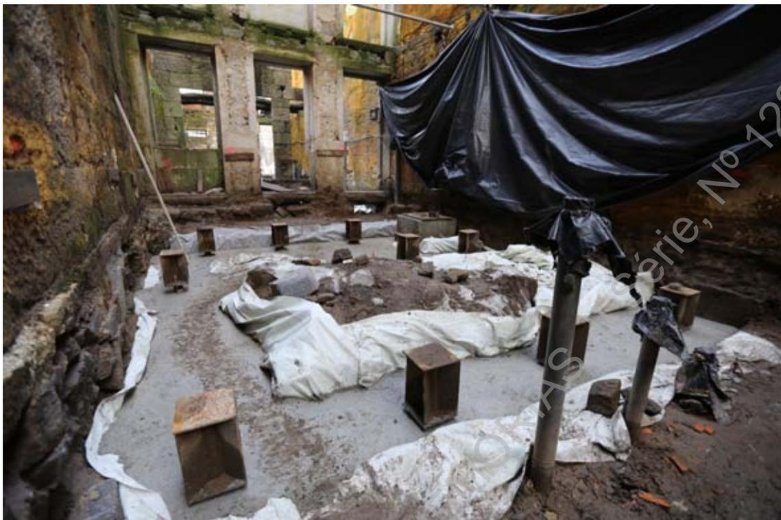
**Foto 54 (IMG\_2246)** – Acompanhamento da betonagem das estacas de fundação.
