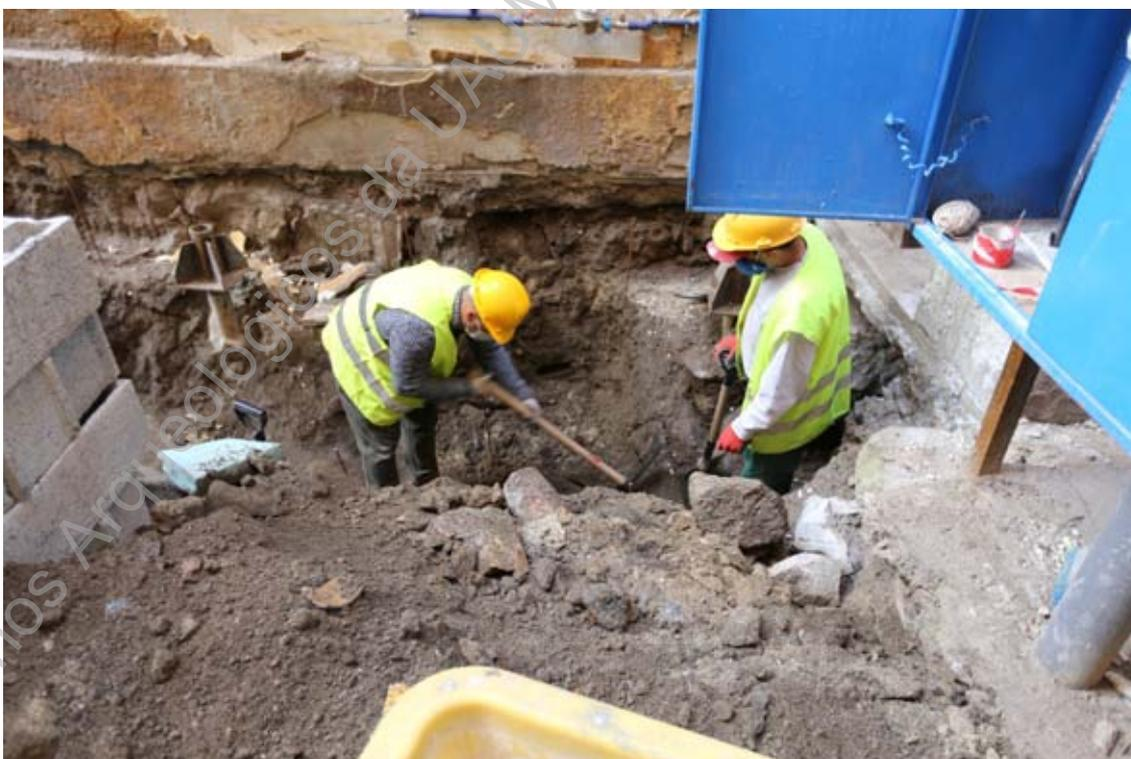
**Foto 33 (IMG\_1567)** – Acompanhamento dos trabalhos de implantação das caixas e tubos de saneamento.
