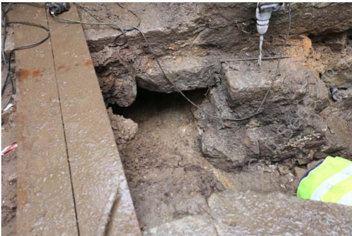
**Foto 36 (IMG\_1740)** – Acompanhamento dos trabalhos de desaterro para a implantação de tubos de saneamento.
