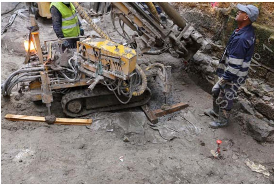
**Foto 30 (IMG\_1298)** – Acompanhamento dos trabalhos de implantação das estacas de fundação.
