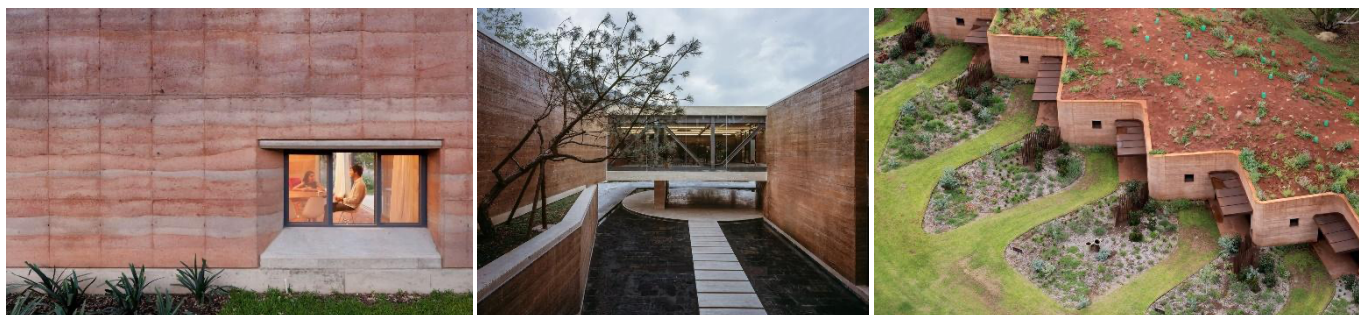
Figura 8- Construções em Taipa. 1- Casa Ajiji, Estado de Jalisco, México, 2010. 2- Museu de Arte, SanBaoPeng, China, 2017. 3- Muralha da Austrália, North Wester, Austrália, 2015 Fonte: ArchDaily
