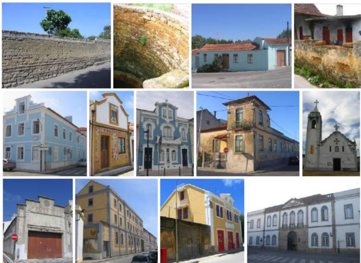
Figura 5- Demonstração de várias construções em adobe no distrito de Aveiro (adaptado de (Varum et al., 2011).
