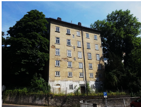
Figura 3- Edifício construído em taipa mais alto da Europa, em Weilburg, Alemanha (fonte: Destino local Maior edifício de terra na Alemanha em Weilburg - DOATRIP.de , 2012)
