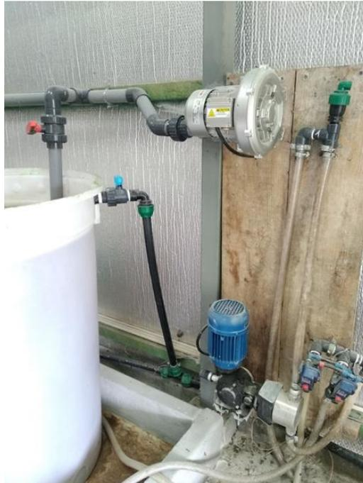
Figura 29 - Bomba de Fertirrigação da marca GAMAR (inferior) e ventilador-insuflador (superior).
