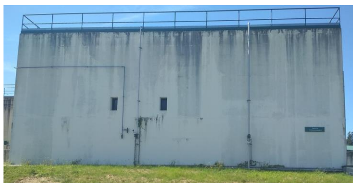
Figura 5. Torre de contacto com ozono.
