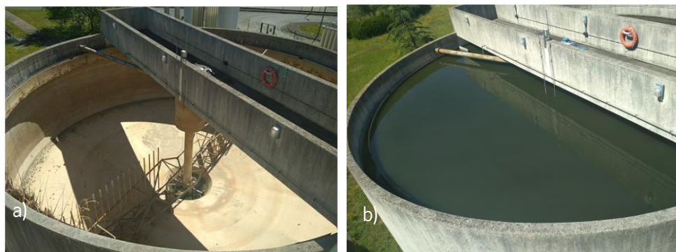
Figura 13. Espessador: a) vazio/parado; b) em funcionamento.
