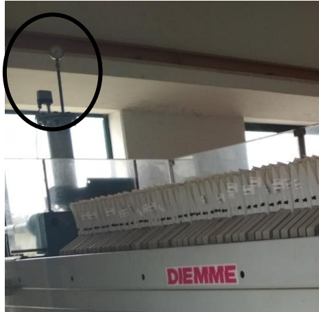
Figura XVI. Manómetro da pressão da bomba de lamas.
