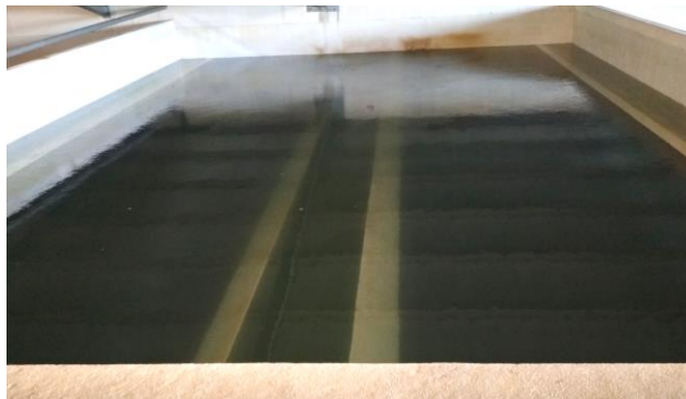
Figura 10. Filtro rápido de areia.
