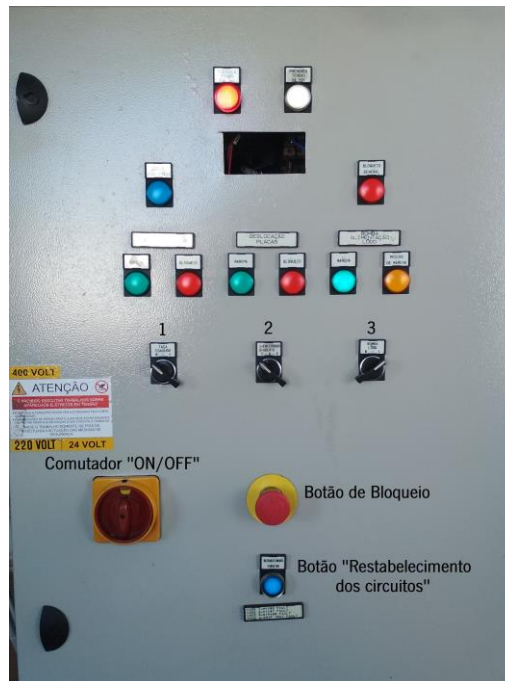
Figura XI. Quadro do filtro prensa.
