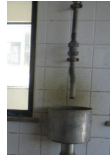
Figura III. Torneira de amostragem do sobrenadante da centrífuga.
