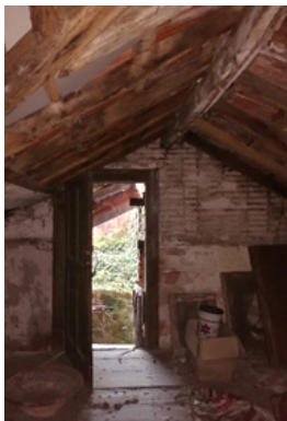
FIG 31 | Vista do sótão para o exterior
