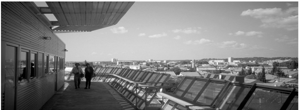
FIG.107. Galeria de acesso.
