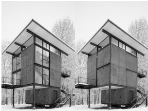
FIG.39. Delta Shelter , Olson Kundig. Uso de portadas móveis, criando uma fachada flexível,
