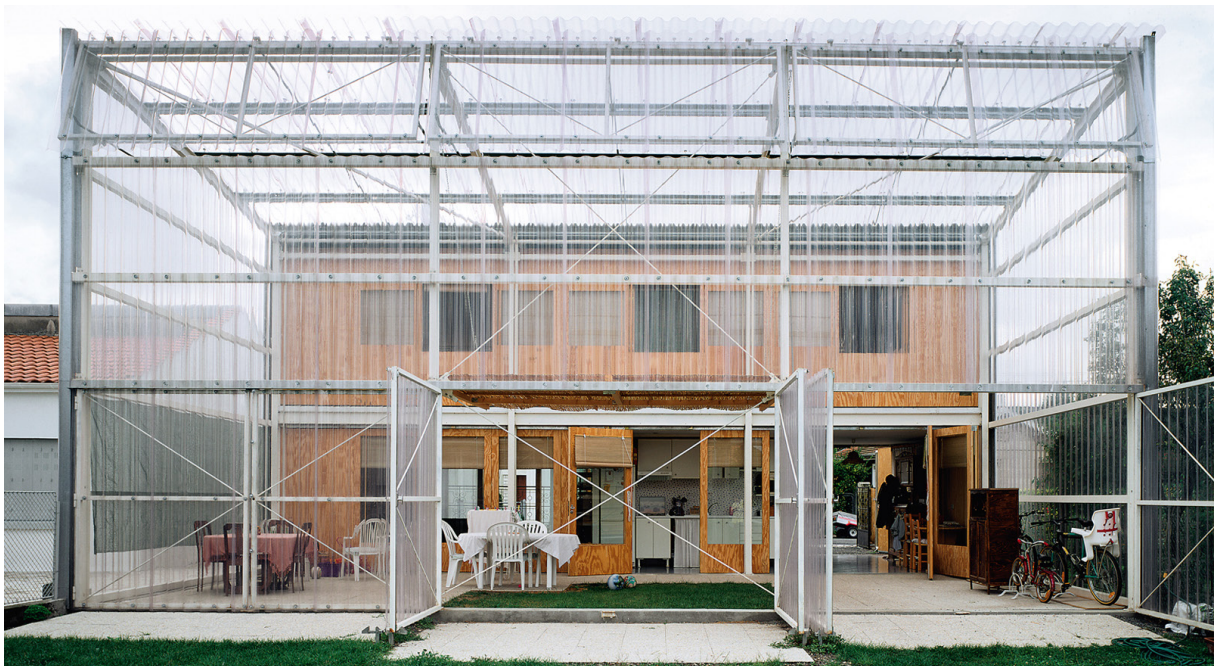
FIG.75. Casa Latapie, Lacaton & Vassal. Flexibilidade das fachadas,
