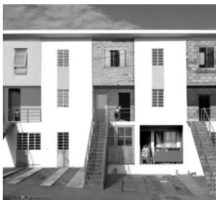
FIG.40. Las Anacuas Housing , Alejandro Aravena, ELEMENTAL. Habitações projetadas para receberem adições espaciais posteriores.
