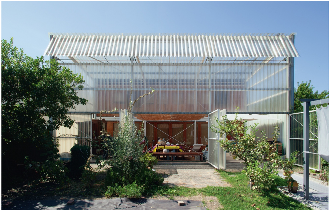
Figura 81 - Vista exterior, Maison Latapie .
