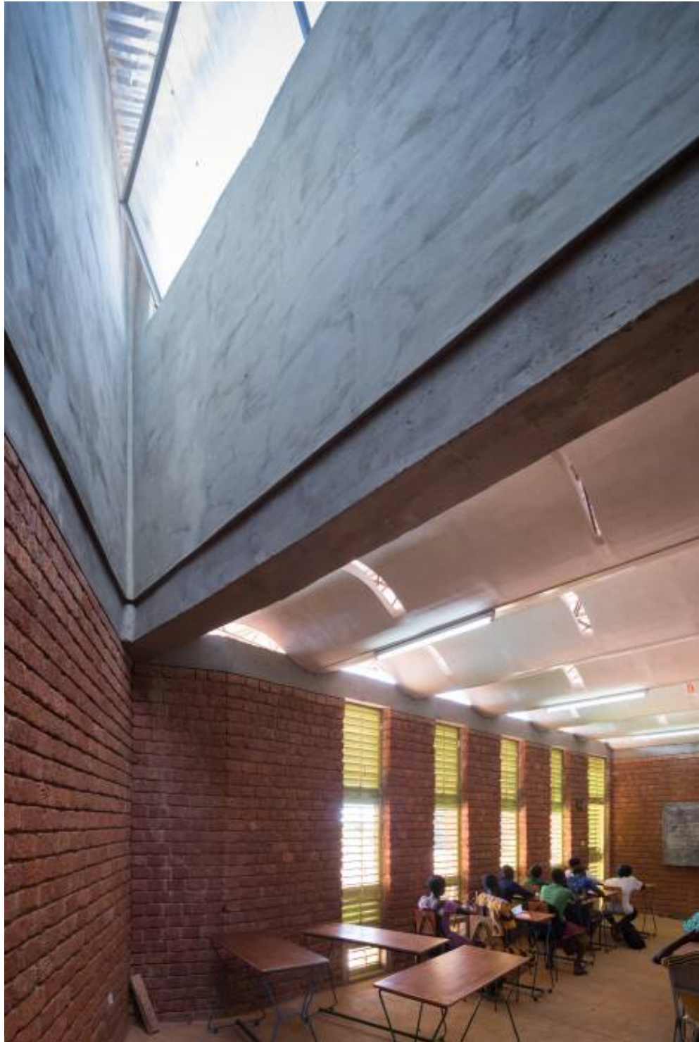
Figura 77 - Interior da Escola Secundária Lycée Schorge , com chaminé de ventilação.
