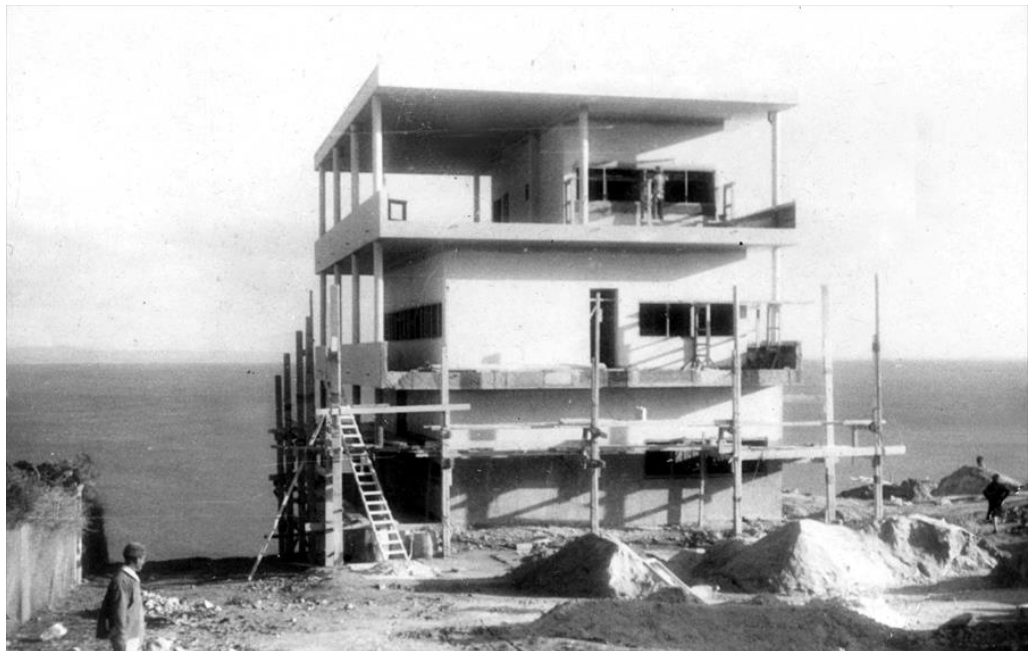
Figura 39 - Villa Baizeau em construção.
