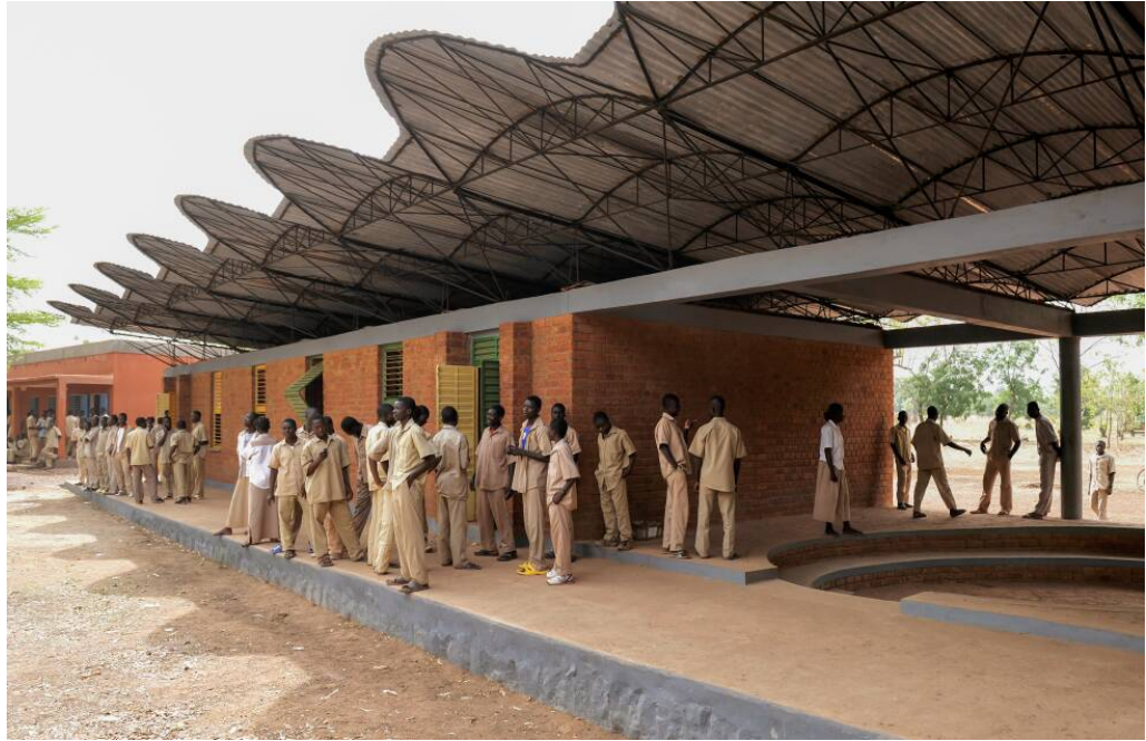
Figura 73 - Escola Secundária de Dano
