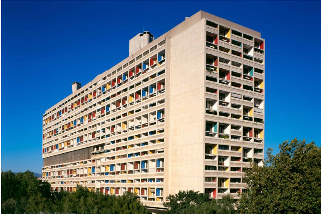
Figura 45 - Unité de Habitation .
