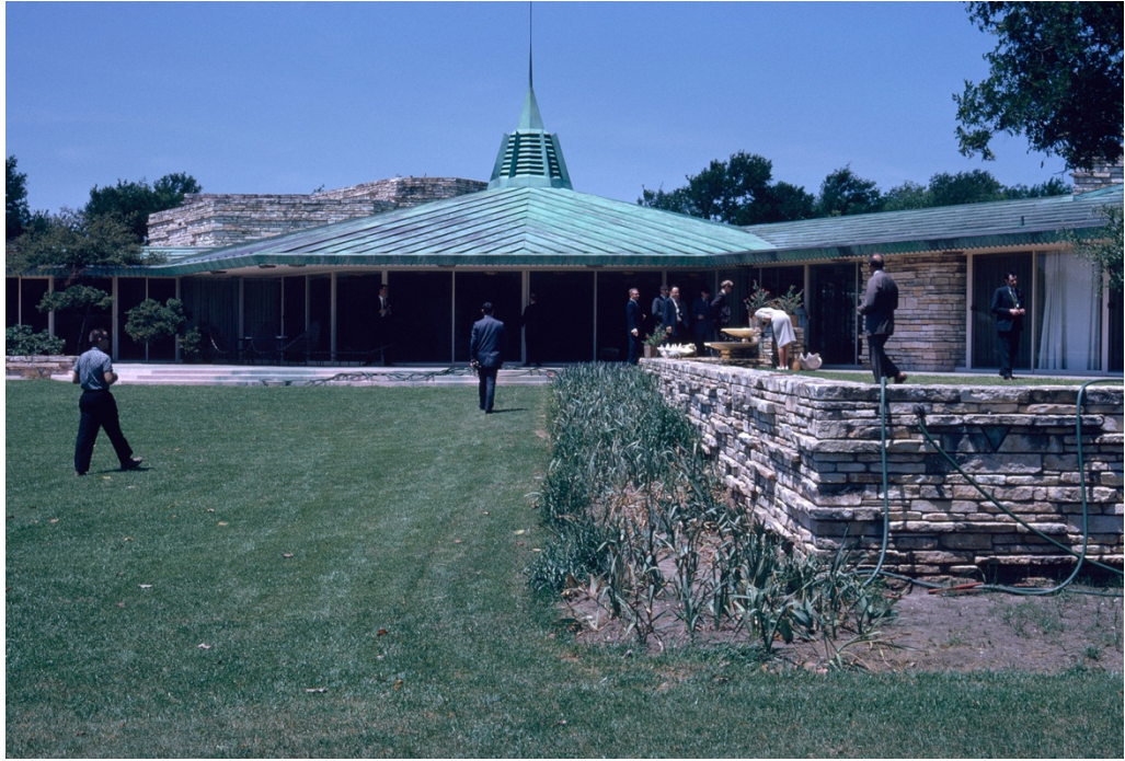
Figura 21 - Vista exterior, Gillin House .
