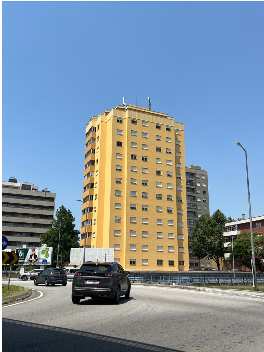
Figura 93 - Prédio habitacional em Braga, com grande incidência solar.
