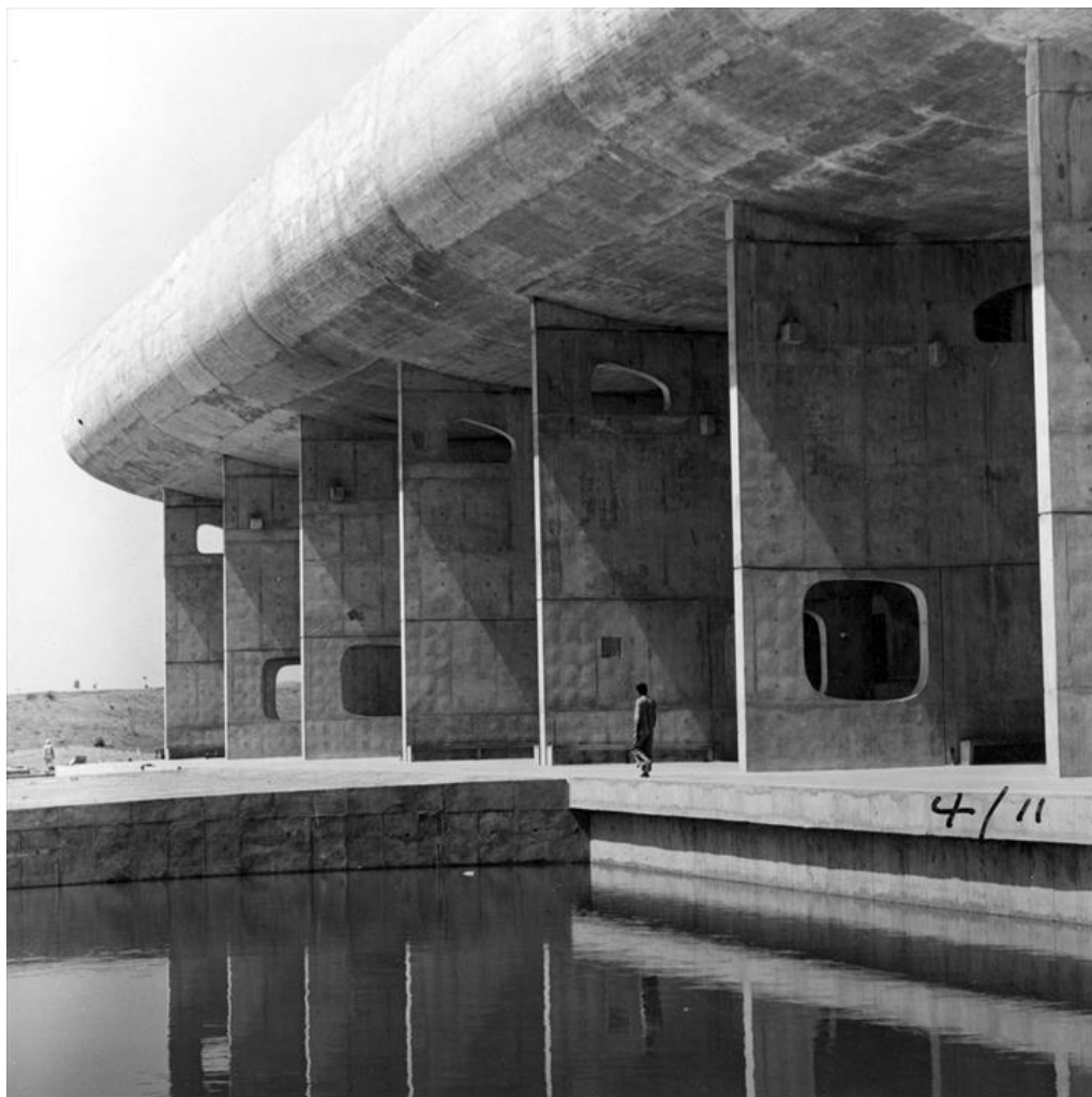
Figura 50 - Fachada Sul, Palais de l'Assemblée .
