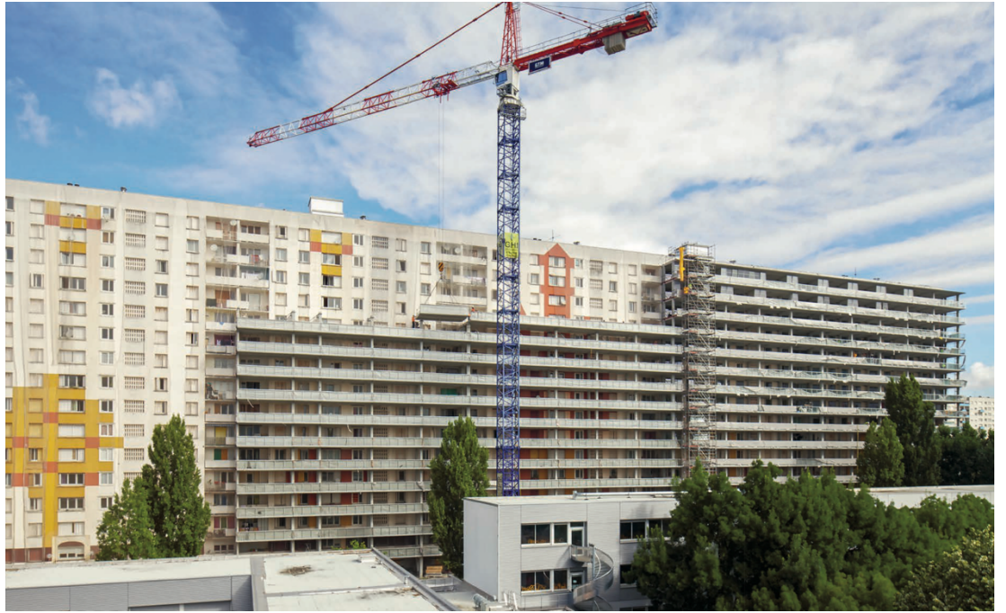
Figura 85 - Fase de construção, Transformation de 530 logements.
