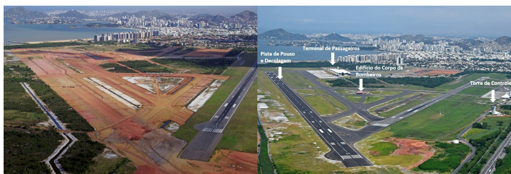
Figura 1 Aeroporto de Vitória, Espírito Santo, Brasil, antes e depois da con- clusão das obras.
