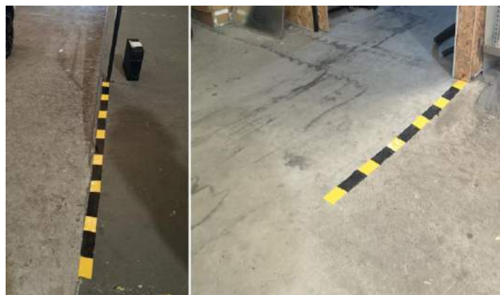
Figura 90 - Marcação de desníveis
