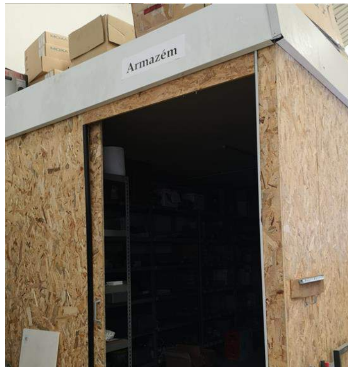
Figura 107 - Identificação do armazém
