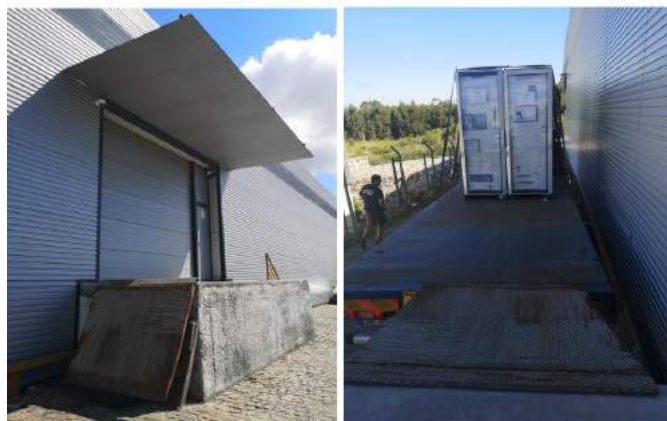
Figura 20 - Cais de Carga e Descarga
