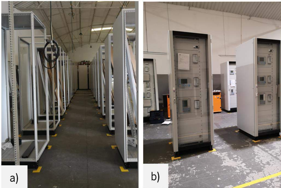
Figura 86 - a) Marcação para produto na Zona de Serralharia; b) Marcação para produto no Setor de Eletrificação
