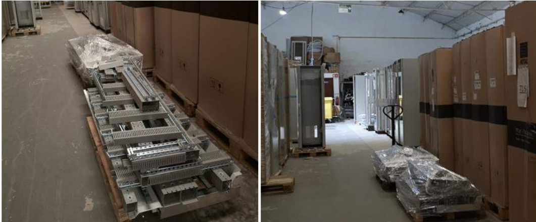
Figura 44 - Obstrução de corredores de passagem
