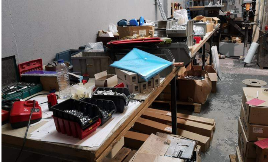
Figura 63 - Desmantelamento do setor da serralharia
