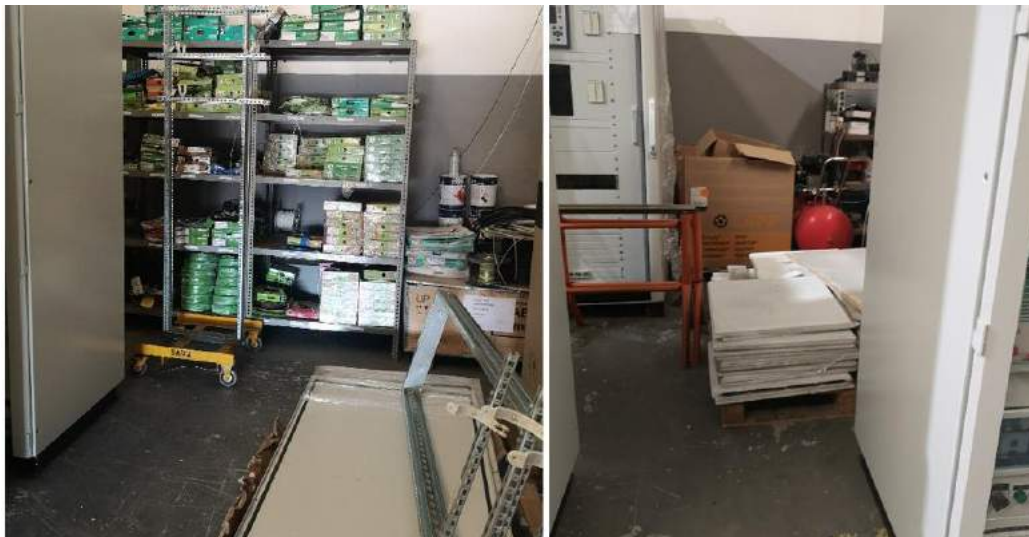
Figura 45 - Obstrução da passagem para a zona de corte de fio
