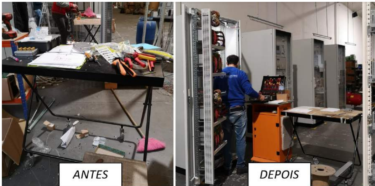
Figura 104 - Setor de Eletrificação antes e depois dos 5S
