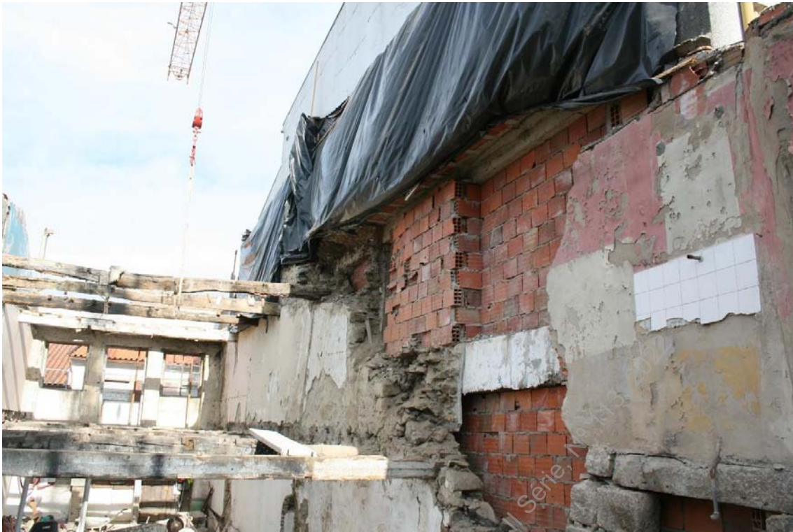
Foto 18 - (IMG_6096) – Aspetto de fase intermédia de demolição (SE/NO).
