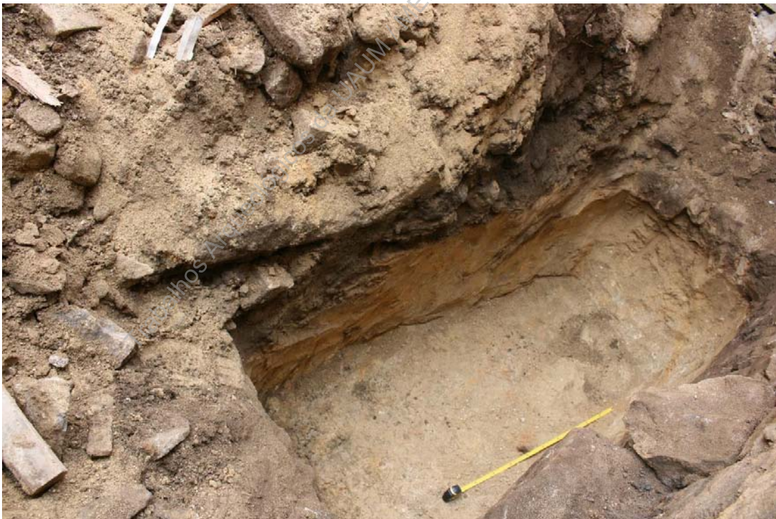
Foto 30 - (IMG_5212) – Aspeto vala para implantação de sapata na zona sul, aproximadamente ao centro do edifício.
