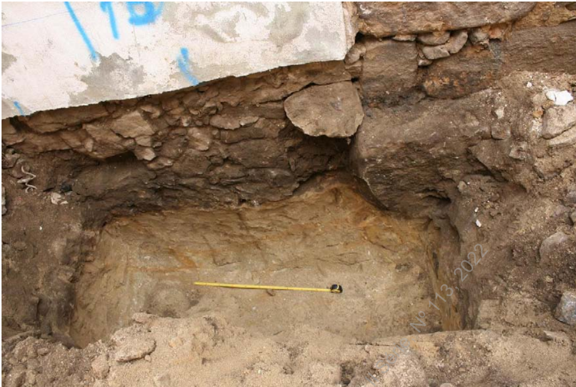
Foto 29 - (IMG_5210) – Aspeto de vala para implantação de sapata zona sul, aproximadamente ao centro do edifício.
