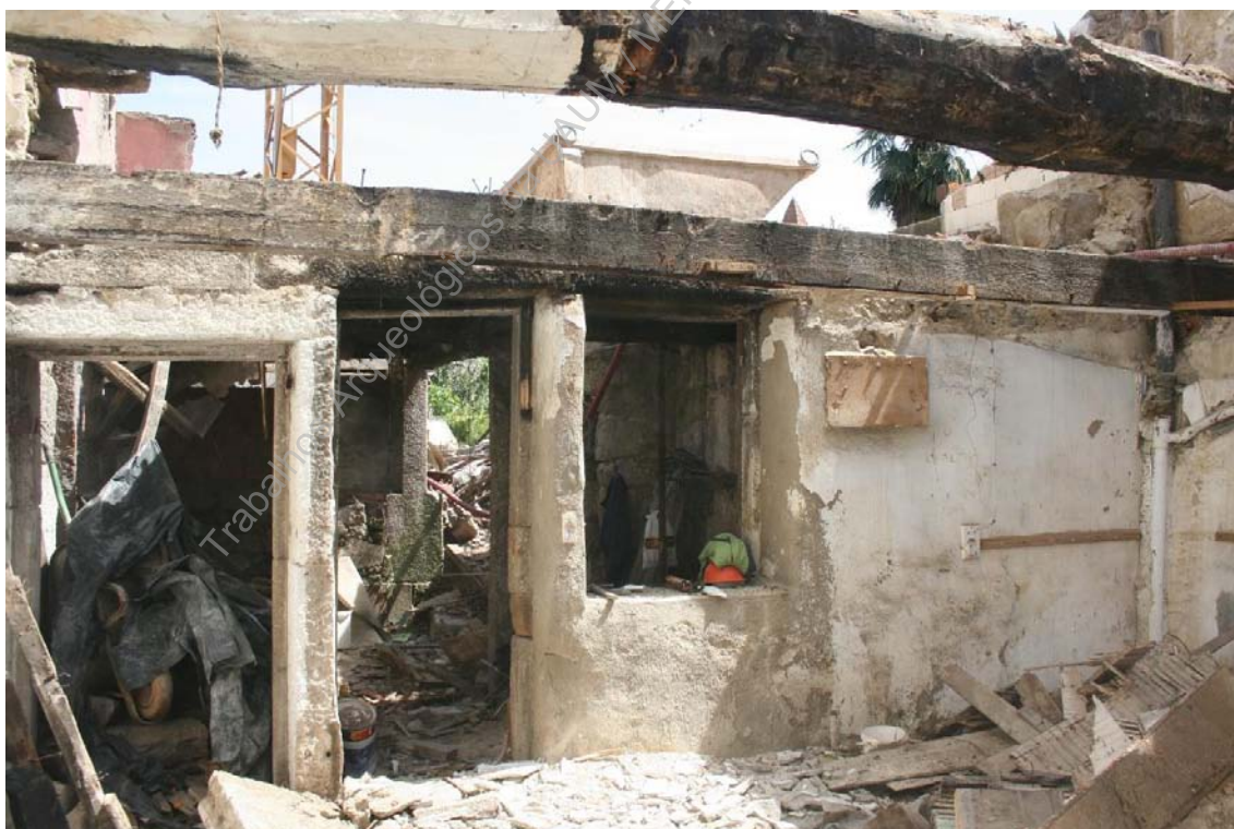
Foto 15 - (IMG_5941) – Aspeto de demolição de piso inferior (NO/SE).
