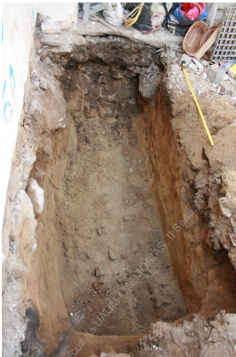
Foto 20 - (IMG_6143) – Aspeto final de vala para implantação de sapata junto a fachada, zona sul.
