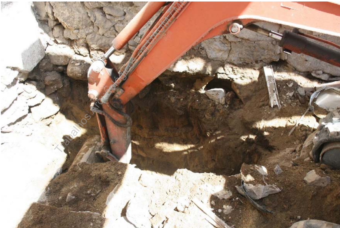
Foto 22 - (IMG_6169) – Aspeto de abertura de vala para implantação de sapata junto a fachada, zona norte.
