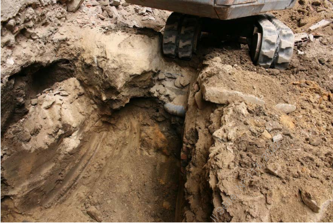
Foto 36 - (IMG_5466) – Aspeto de escavação vala para sapata na zona das escadas para o primeiro piso, sendo evidente caixa de derivação de saneamento.
