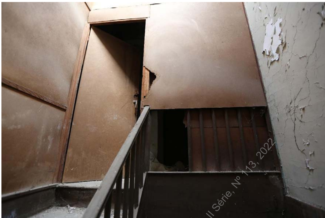
Foto 8 - (Z45A4770) – Aspetto de escadaria de acesso a segundo piso.
