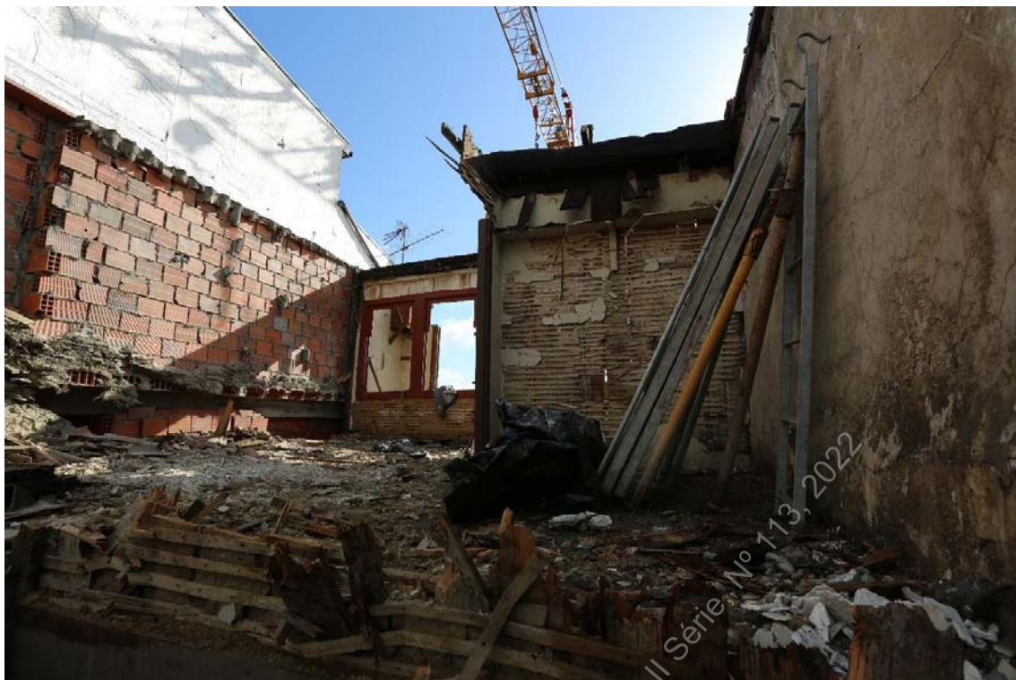
Foto 12 - (Z45A5296) – Aspeto de demolição de piso superior (SO/NE).
