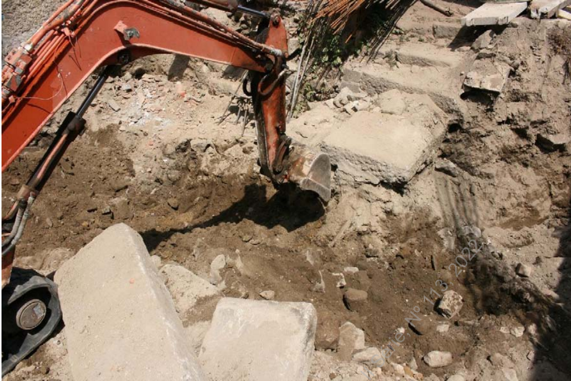
Foto 52 - (IMG_5696) – Aspeto de escavação de zona este.
