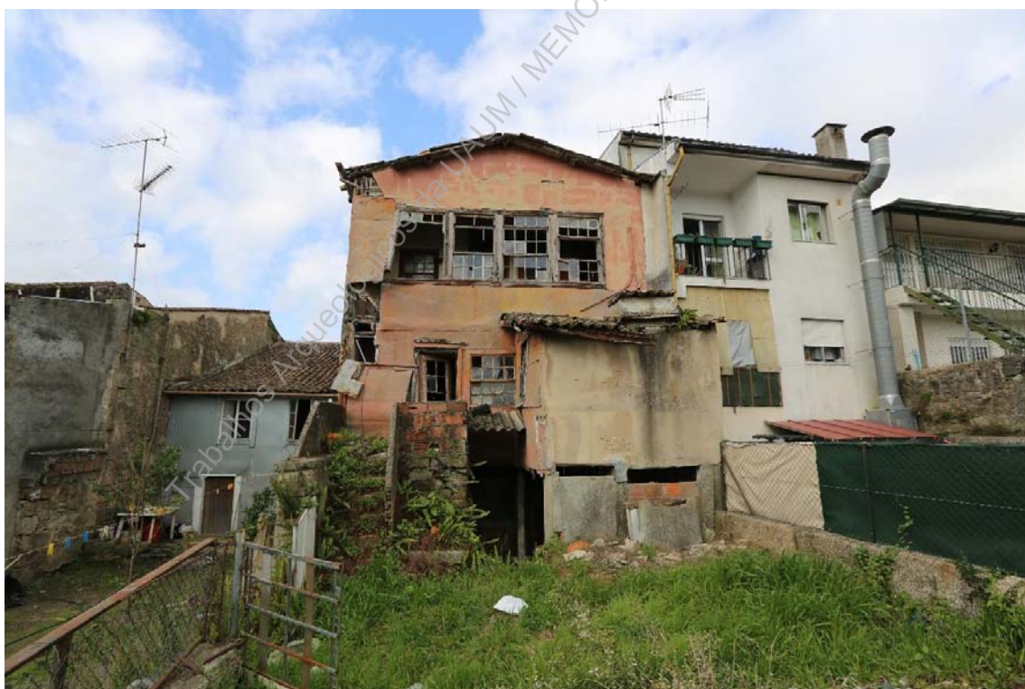
Foto 11 - (Z45A4732) – Aspeto de traseiras de edifício.
