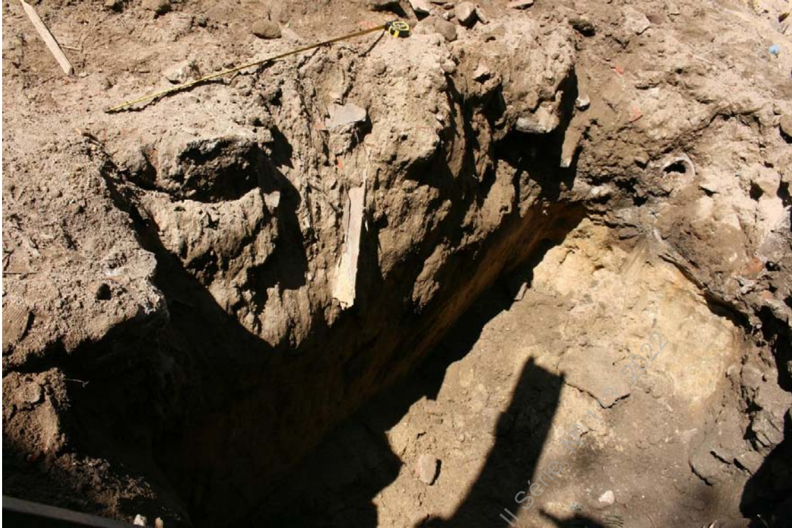
Foto 48 - (IMG_5550) – Aspeto vala para abertura de sapata zona nordeste, sendo visível tubo de águas pluviais/saneamento.
