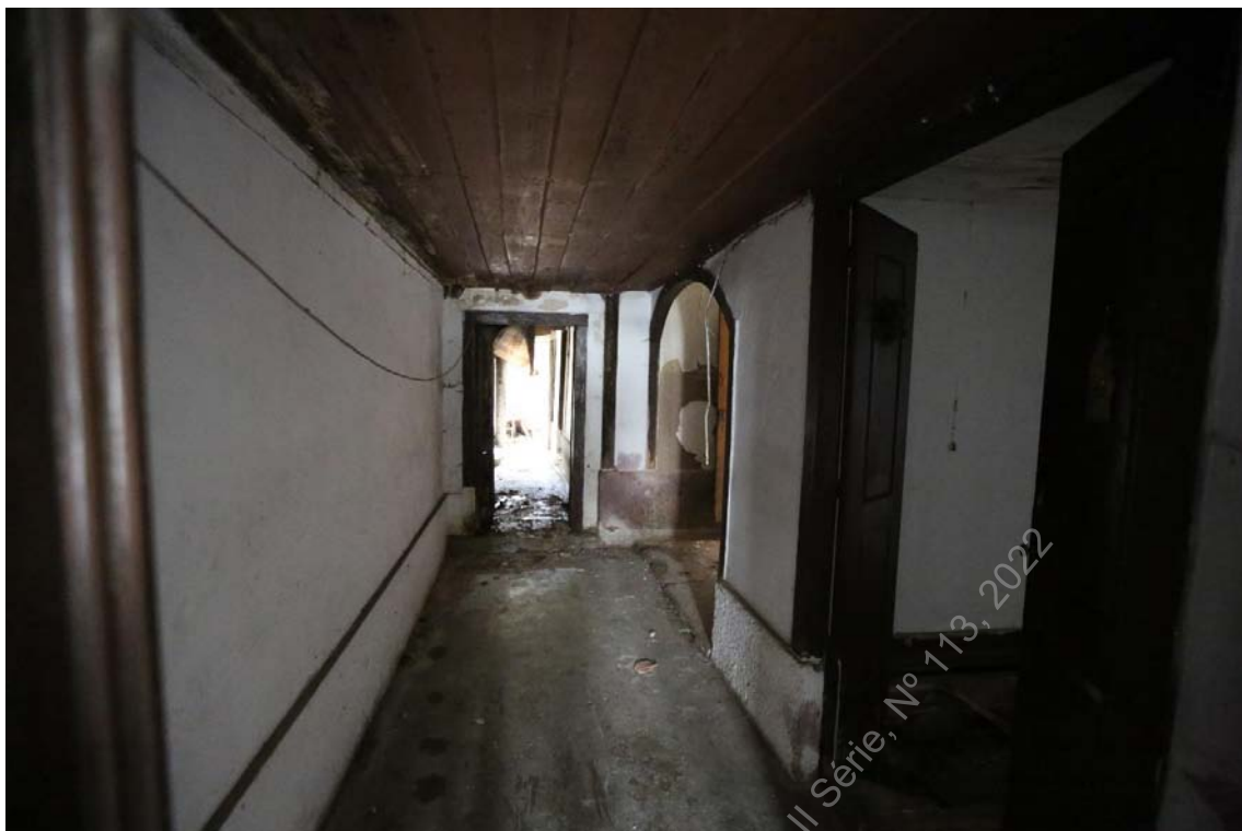
Foto 4 - (Z45A4721) – Aspeto de corredor do R/C.
