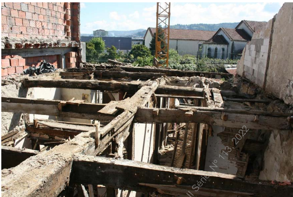
Foto 14 - (IMG_5886) – Aspeto de demolição de piso intermédio (SO/NE).
