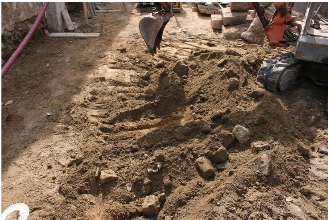
Foto 50 - (IMG_5717) – Aspeto de escavação zona central de edifício.
