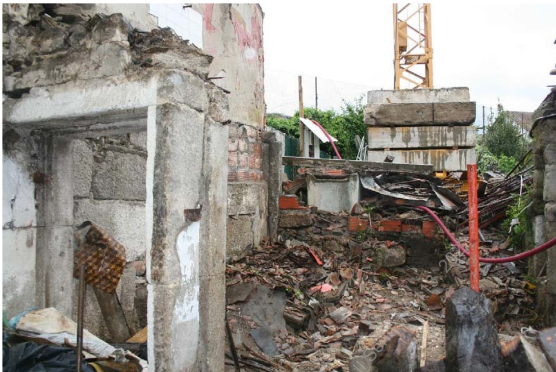
Foto 16 - (IMG_6011) – Aspeto de demolição de piso inferior (SO/NE).
