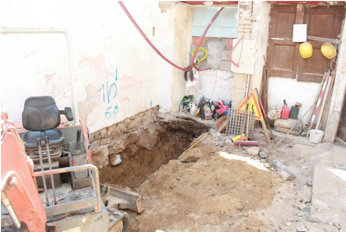
Foto 21 - (IMG_6147) – Aspeto de localização de vala para implantação de sapata junto a fachada, zona sul.
