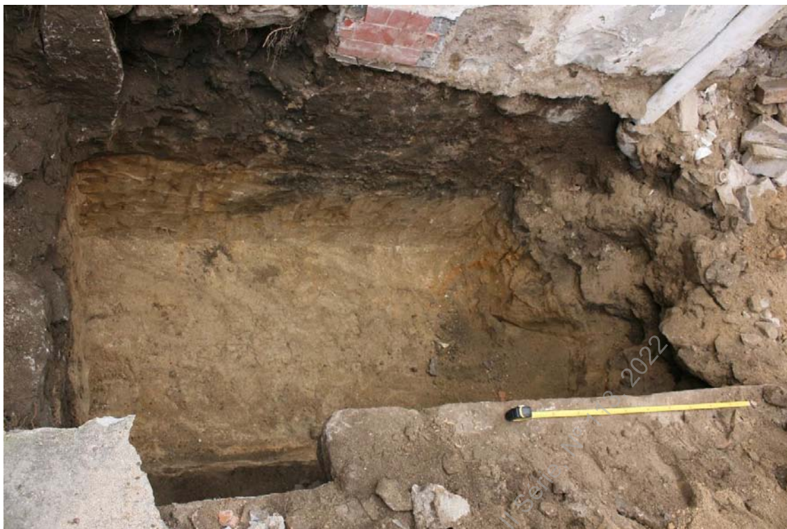
Foto 42 - (IMG_5446) – Aspeto de abertura de vala na zona das antigas casas de banho.
