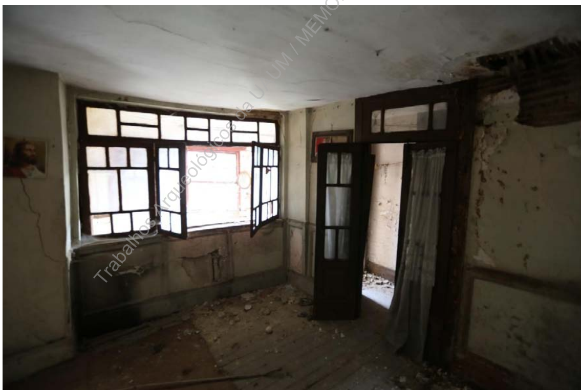
Foto 9 - (Z45A4758) – Aspetto de compartimento nas traseiras do segundo piso.
