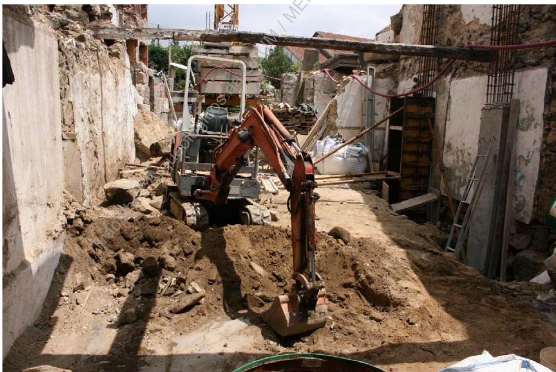
Foto 39 - (IMG_5270) – Aspeto de escavação zona central de edifício.
