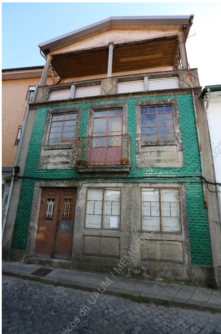
Foto 1 - (Z45A4714) – Aspeto da fachada.
