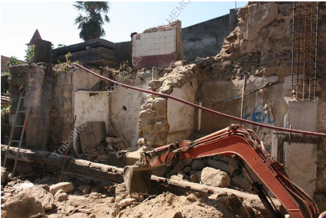
Foto 19 - (IMG_5394) – Aspetto de fase intermédia de demolição de zonas de casas de banho (NO/SE).
