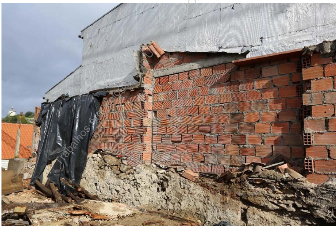
Foto 13 - (Z45A5292) – Aspeto de demolição de piso superior (SE/NO).
