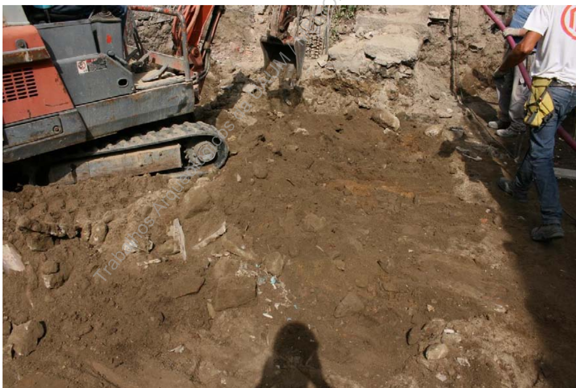
Foto 51 - (IMG_5718) – Escavação de zona nordeste.
