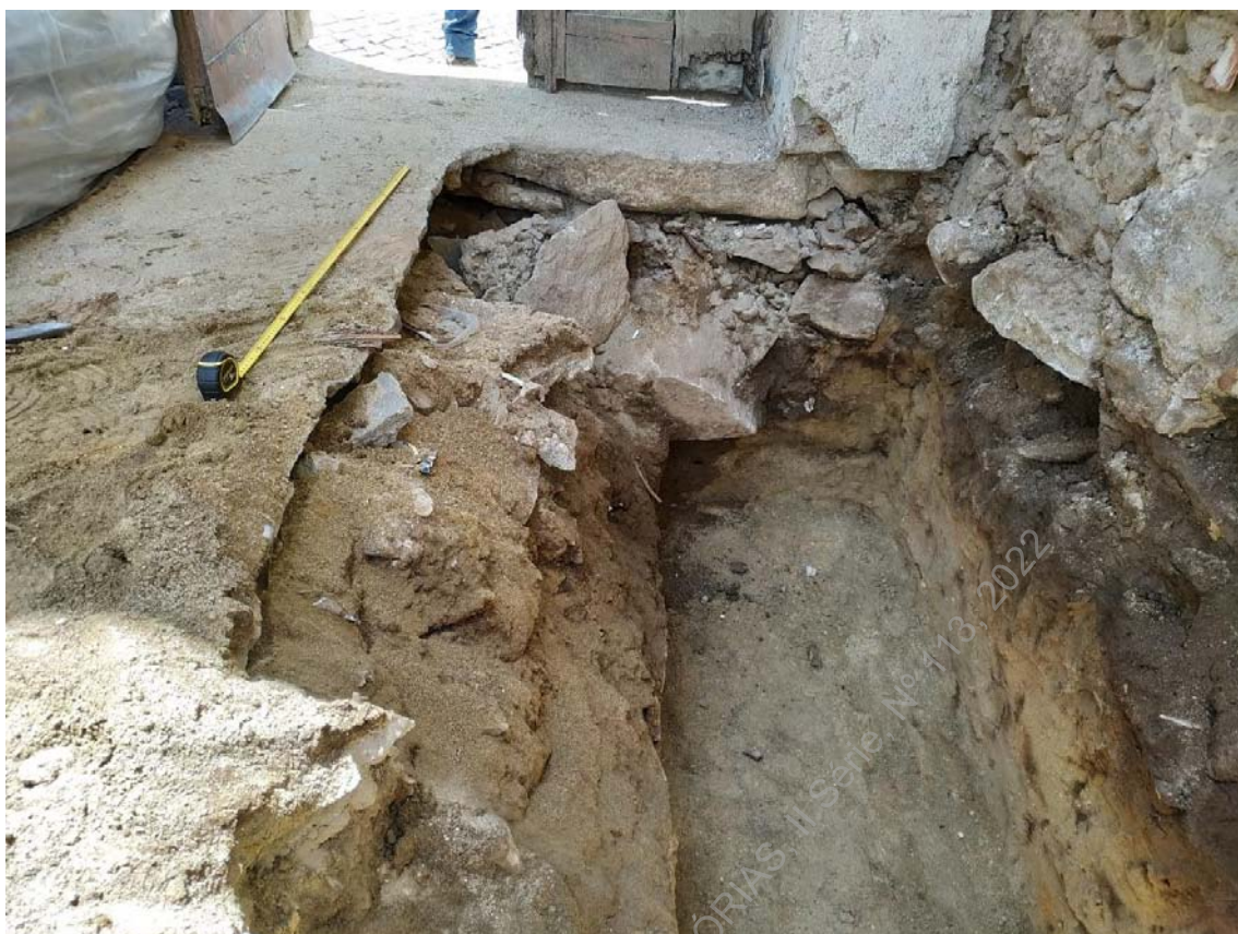
Foto 23 - (IMG_20190613_142040) – Aspecto de abertura de vala para implantação de sapata junto a fachada, zona norte.
