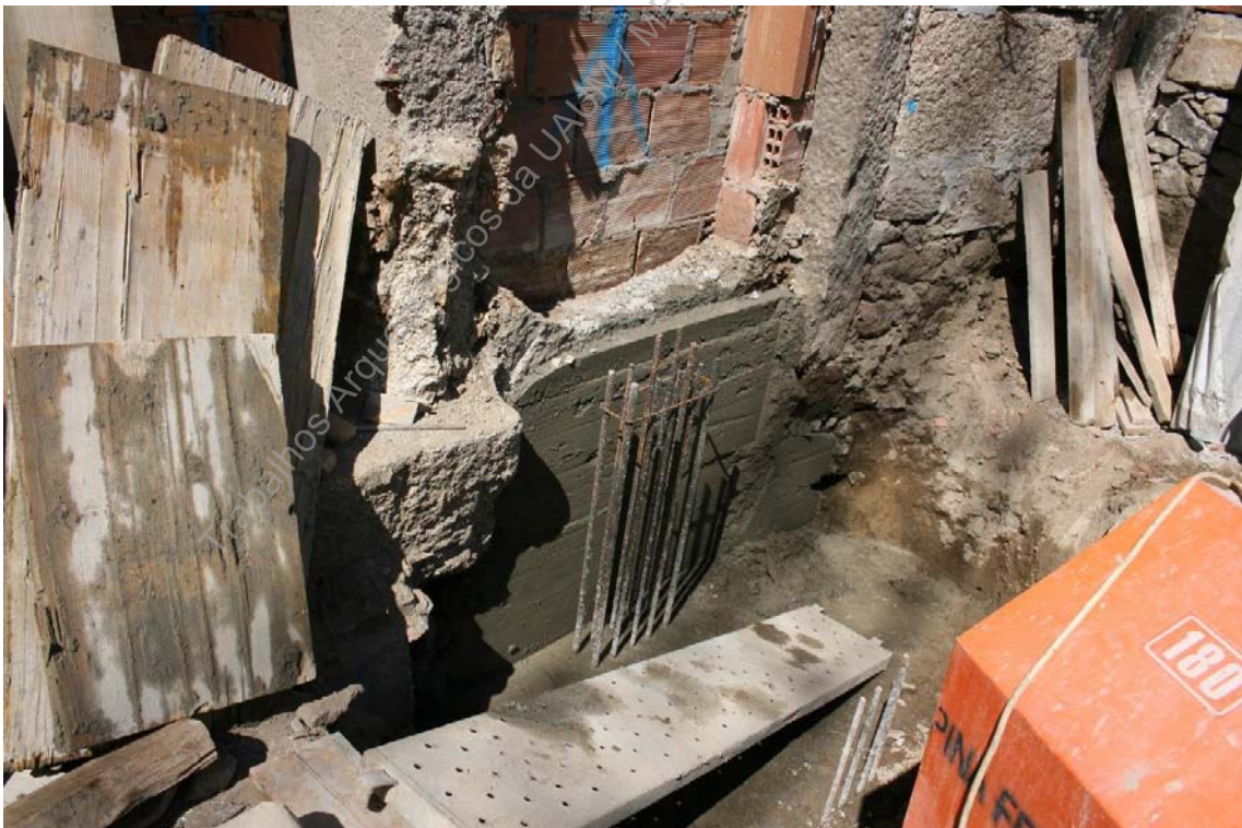
Foto 49 - (IMG_5574) – Aspeto sapata betonada zona nordeste
