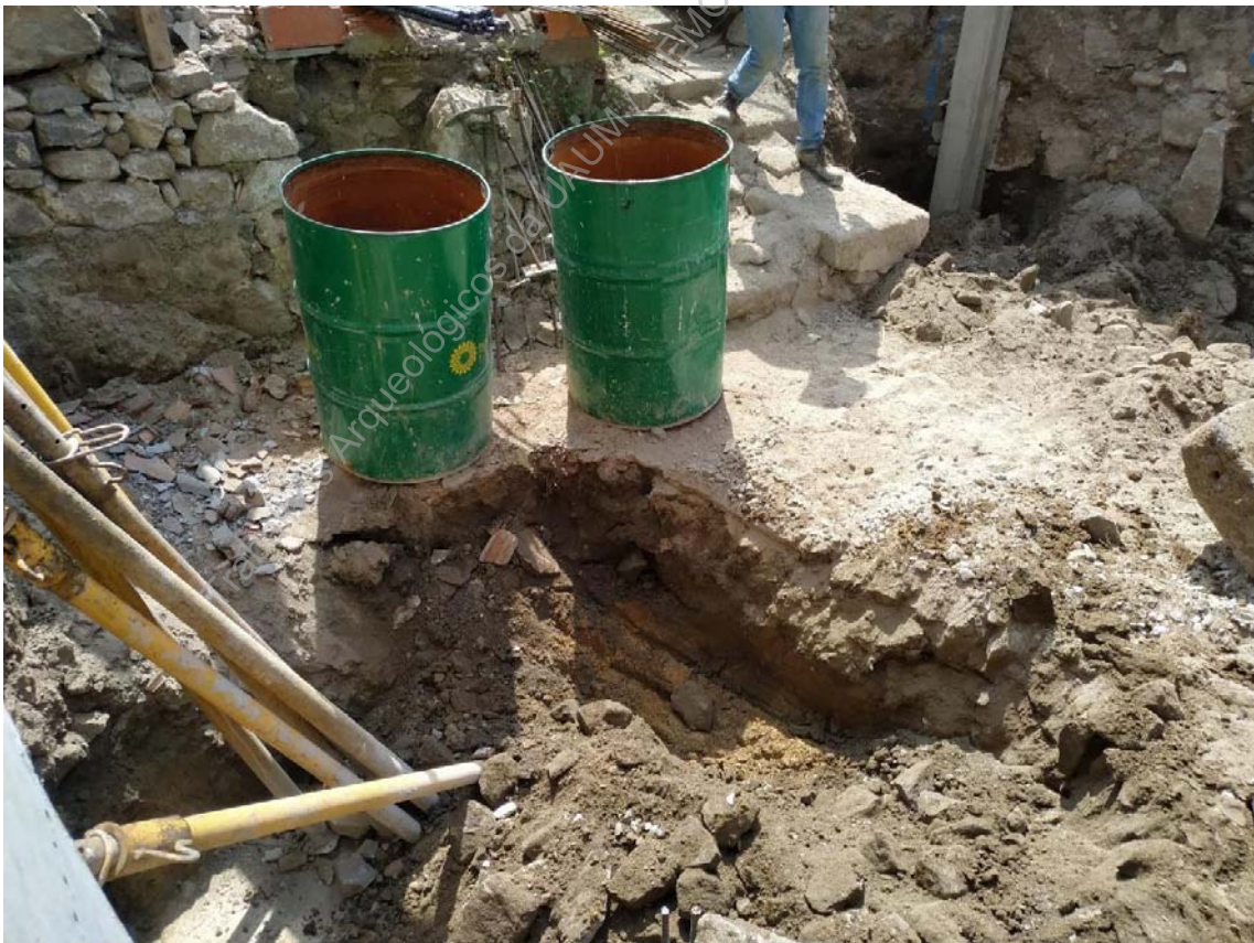
Foto 53 - (IMG_20190723_115107) – Aspeto de escavação de zona nordeste.
