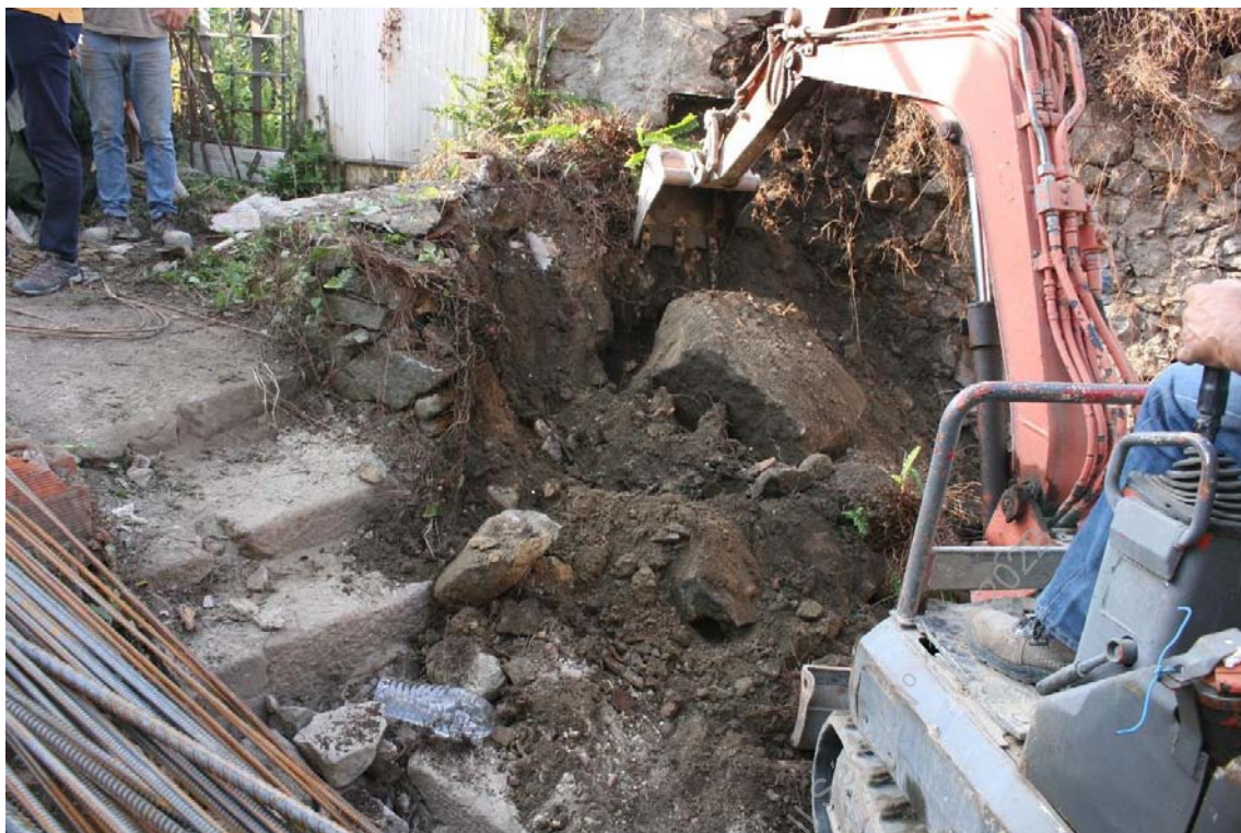
Foto 44 - (IMG_5488) – Aspetto de escavação em zona de quintal.
