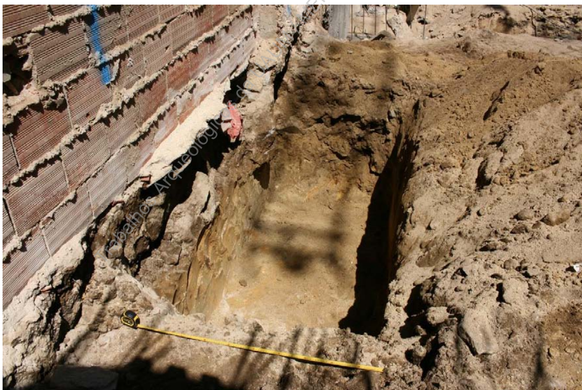
Foto 26 - (IMG_5632) – Aspeto de segunda vala (E/O) para implantação de sapata zona norte, sendo visível vala para implantação de tubo de saneamento.
