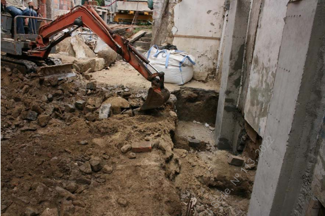
Foto 40 - (IMG_5298) – Aspetto de remoção de piso com preparação de paralelo.
