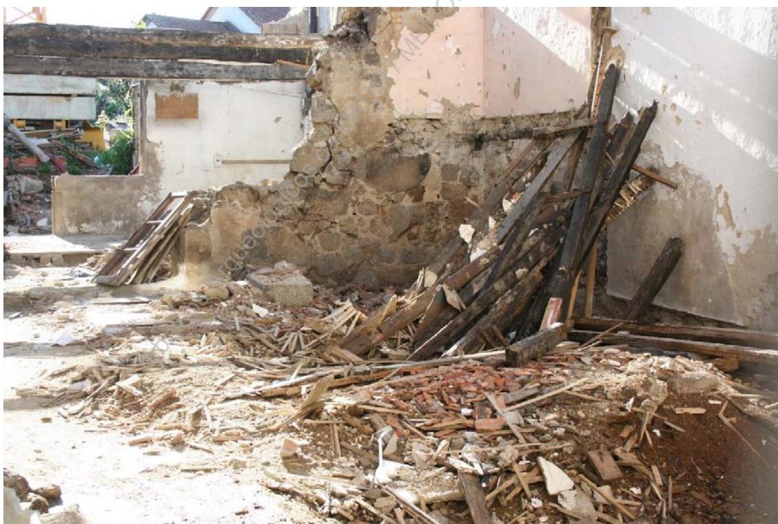
Foto 17 - (IMG_6044) – Aspeto de demolição de piso inferior (NO/SE).
