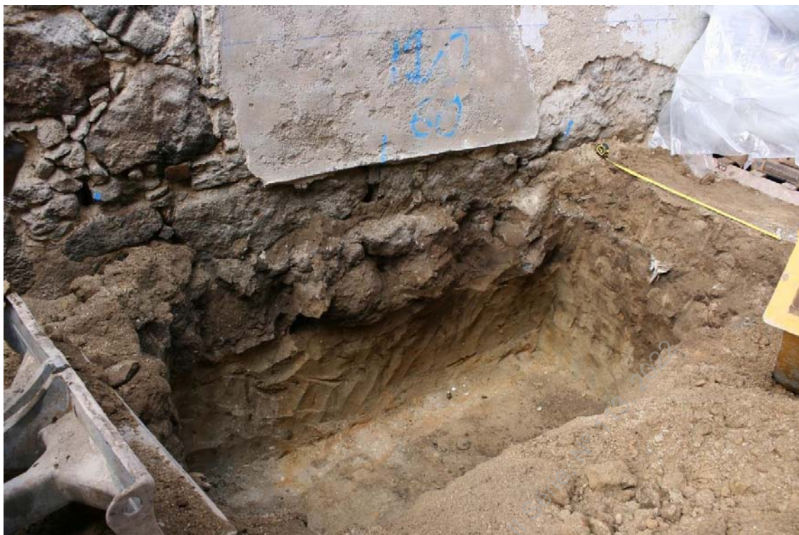
Foto 25 - (IMG_5110) – Aspeto de segunda vala (E/O) para implantação de sapata zona sul.
