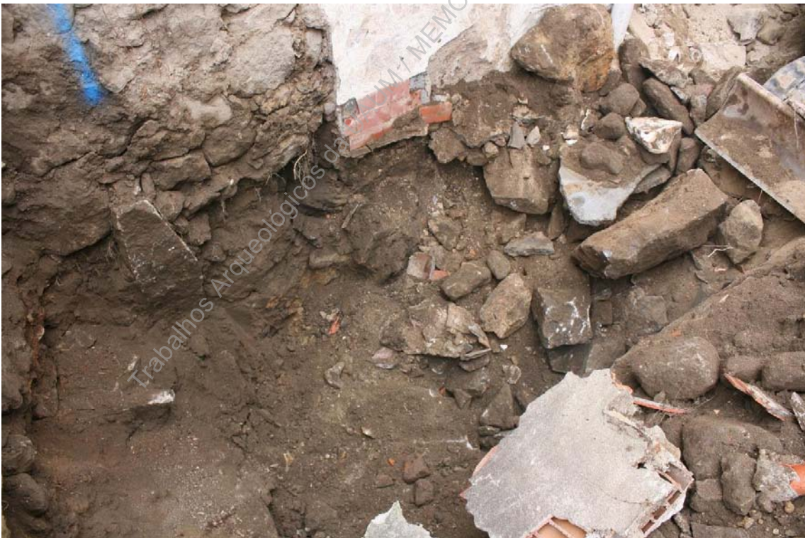
Foto 41 - (IMG_5434) – Aspetto de abertura de vala na zona das antigas casas de banho.
