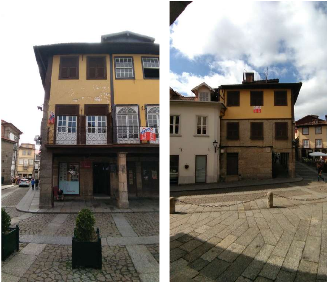
Figura 3 Fachadas edifício Largo da Oliveira e Rua Alfredo Guimarães
