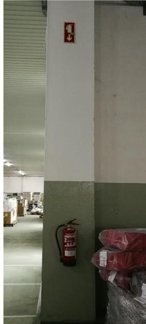
*Figura 56 - Placas de identificação: extintores*
