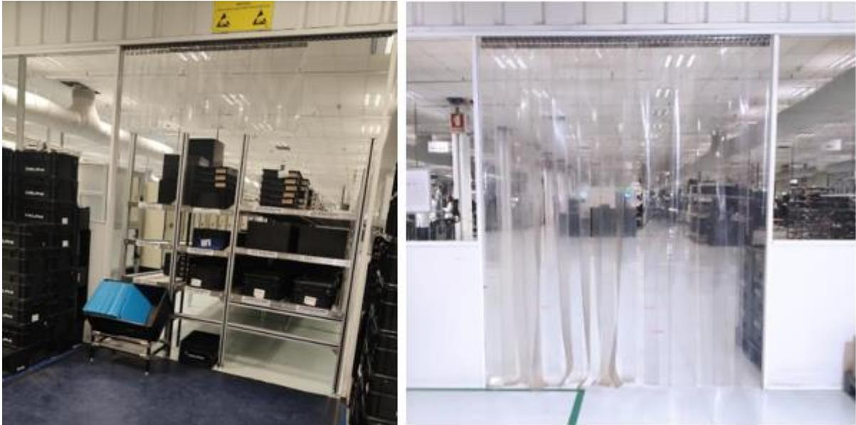
Figura 47 - Exemplos de erros na separação entre a CG1 e a CG2 do edifício 1
