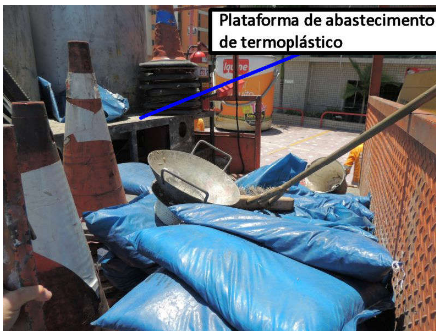
Figura 34 - Obstrução da circulação no caminhão
