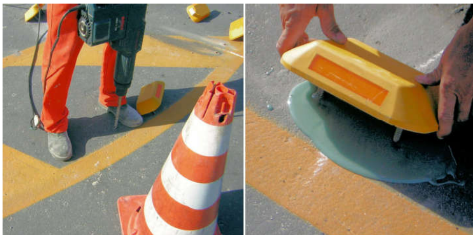
Figura 14 - Fixação de tachão ao pavimento
