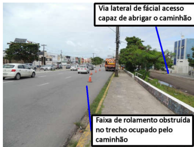
Figura 43 - Posicionamento inadequado antes da execução do serviço
