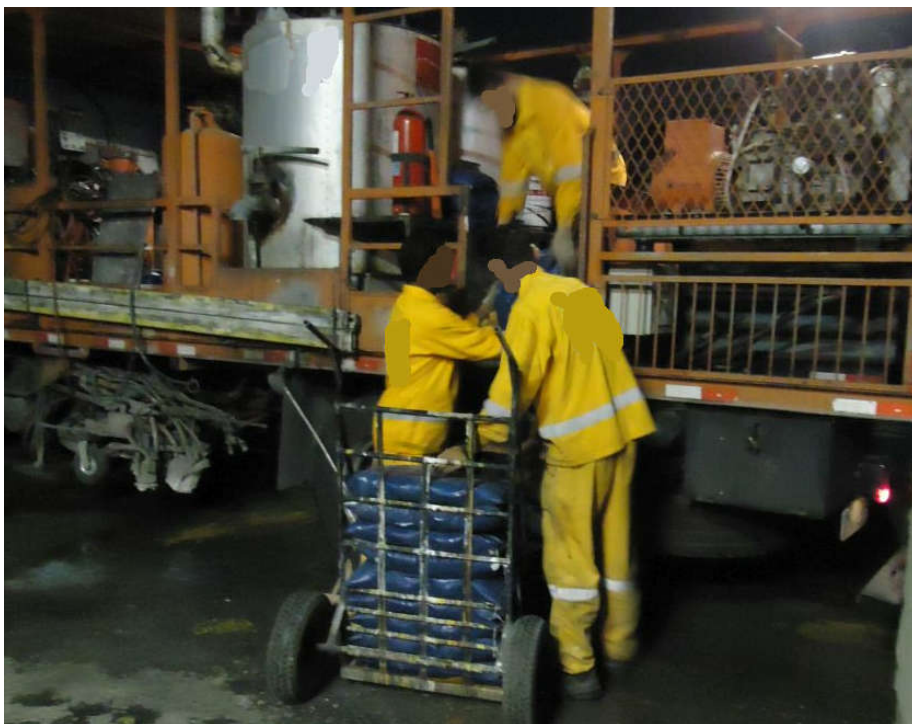
Figura 30 - Transporte de insumos e material de apoio no caminhão de pintura
