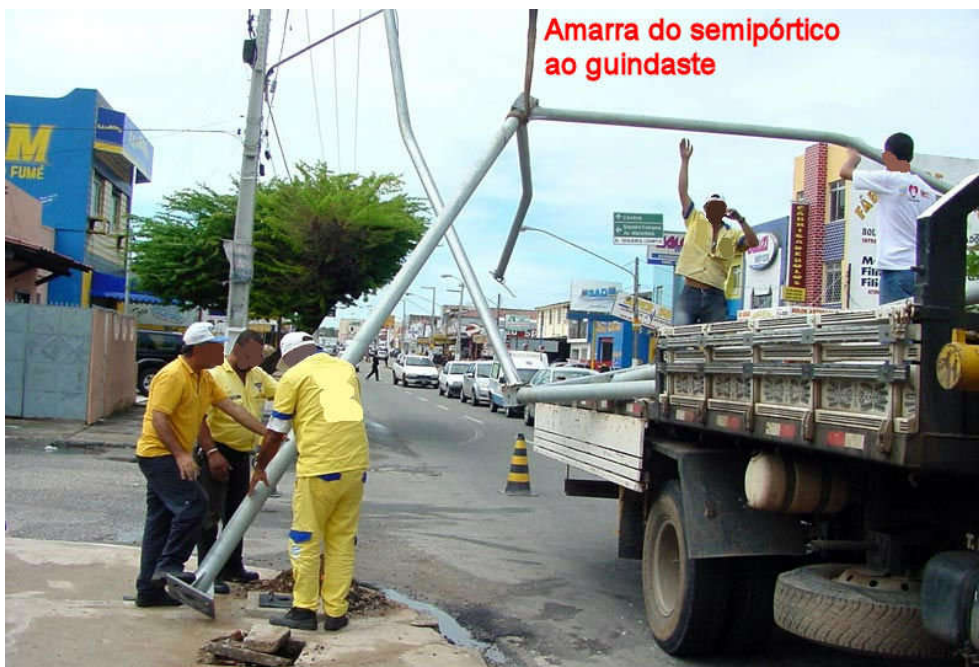
Figura 17 - Implantação de semipórtico de placas (Fonte: IMD, 2005)
