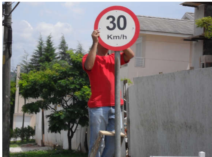
Figura 19 - Colocação de placa em baliza (Fonte: CONSTRUSINAL, 2019)
