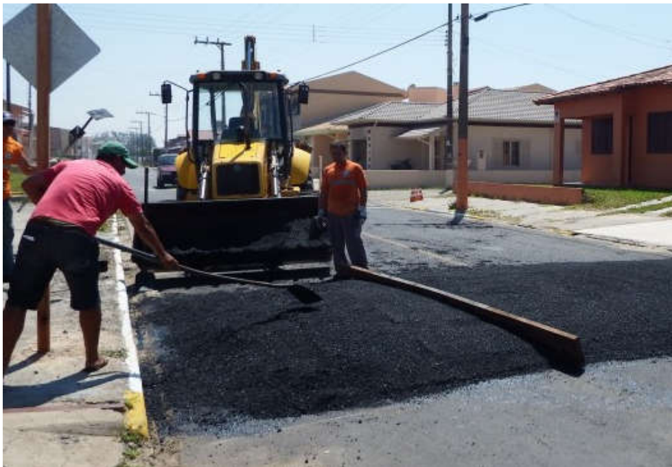
Figura 2 - Construção de lombada asfáltica em PMF (Fonte: ENGEPLUS, 2014)
