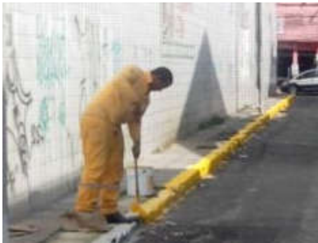
Figura 9 - Pintura de meio-fio com rolo
