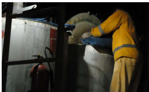
Figura 42 - Início do aquecimento do termoplástico no pátio de empresa
