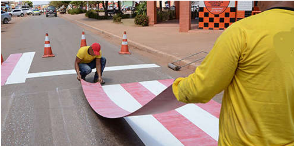
Figura 7 - Aplicação de laminado elastoplástico (Fonte: Canaã dos Carajás, 2014)
