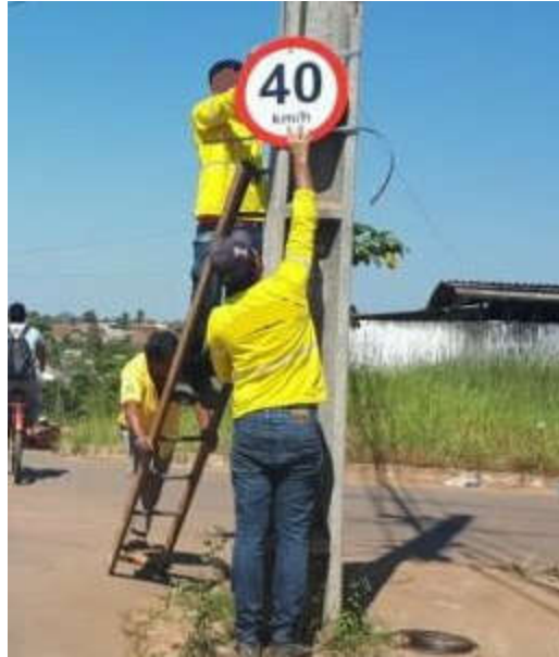
Figura 18 - Implantação de placa em poste de iluminação pública (Rio Branco, 2018)
