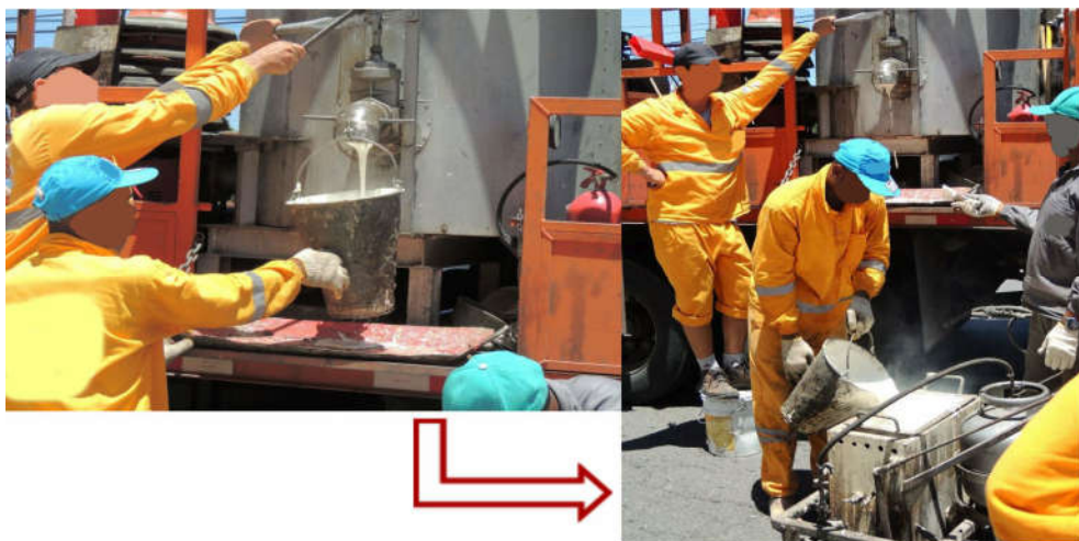
Figura 6 - Aplicação de termoplástico por extrusão
