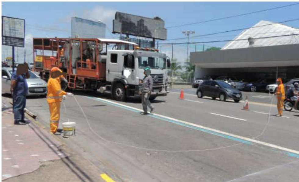
Figura 31 - Área segura de trabalho com o veículo servindo de proteção
