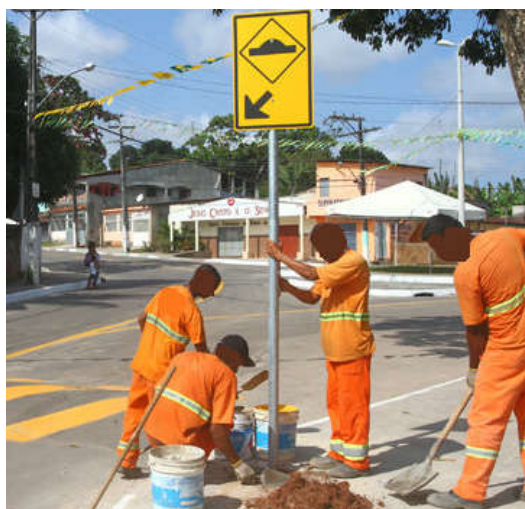
Figura 16 - Implantação de placa de trânsito (Fonte: Maceió, 2014)
