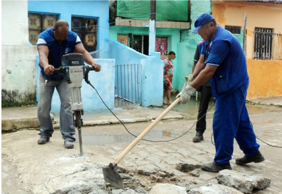
Figura 3 - Remoção de lombada com martelo rompedor manual (Fonte: Maceió, 2014b)
