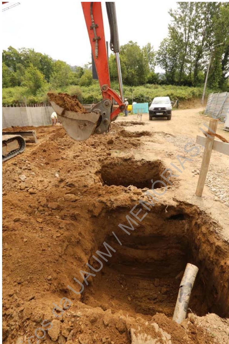
Foto 47 (IMG_2729) – Pormenor da abertura de valas para colocação de pilares.
