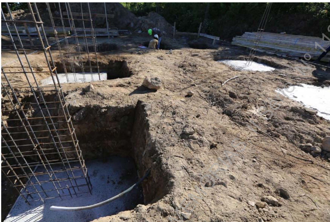
Foto 68 (Z45A8075) – Perspetiva geral da betonagem das valas nas traseiras do lote de construção.
