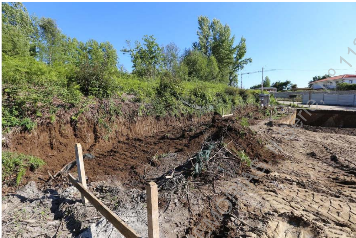
Foto 13 (IMG_0699) – Perspetiva geral do trabalho de decapagem do terreno.
