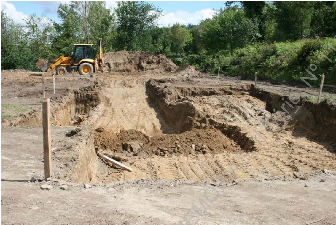
Foto 5 (IMG_1308) – Perspetiva geral do desaterro da área intervenionada.
