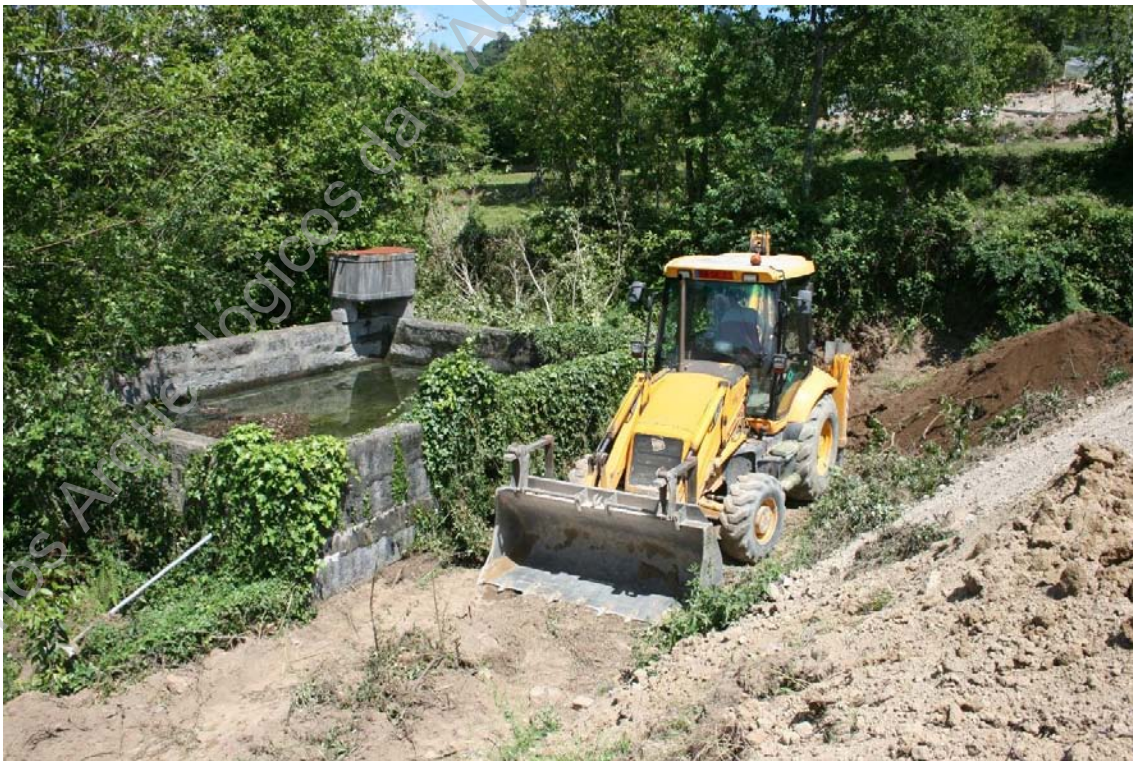
Foto 26 (IMG_1432) – Início do trabalho de abertura de vala para construção de muro.
