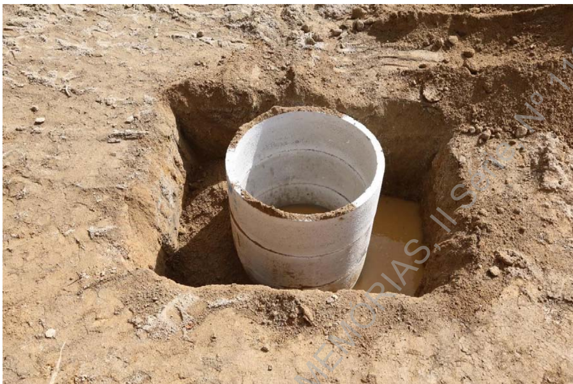
Foto 29 (IMG_1416) – Acompanhamento da colocação de manilhas em betão no poço de drenagem.
