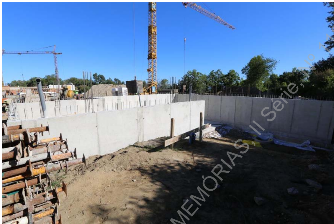
Foto 72 (Z45A8100) – Perpetiva geral do edifício em construção.
