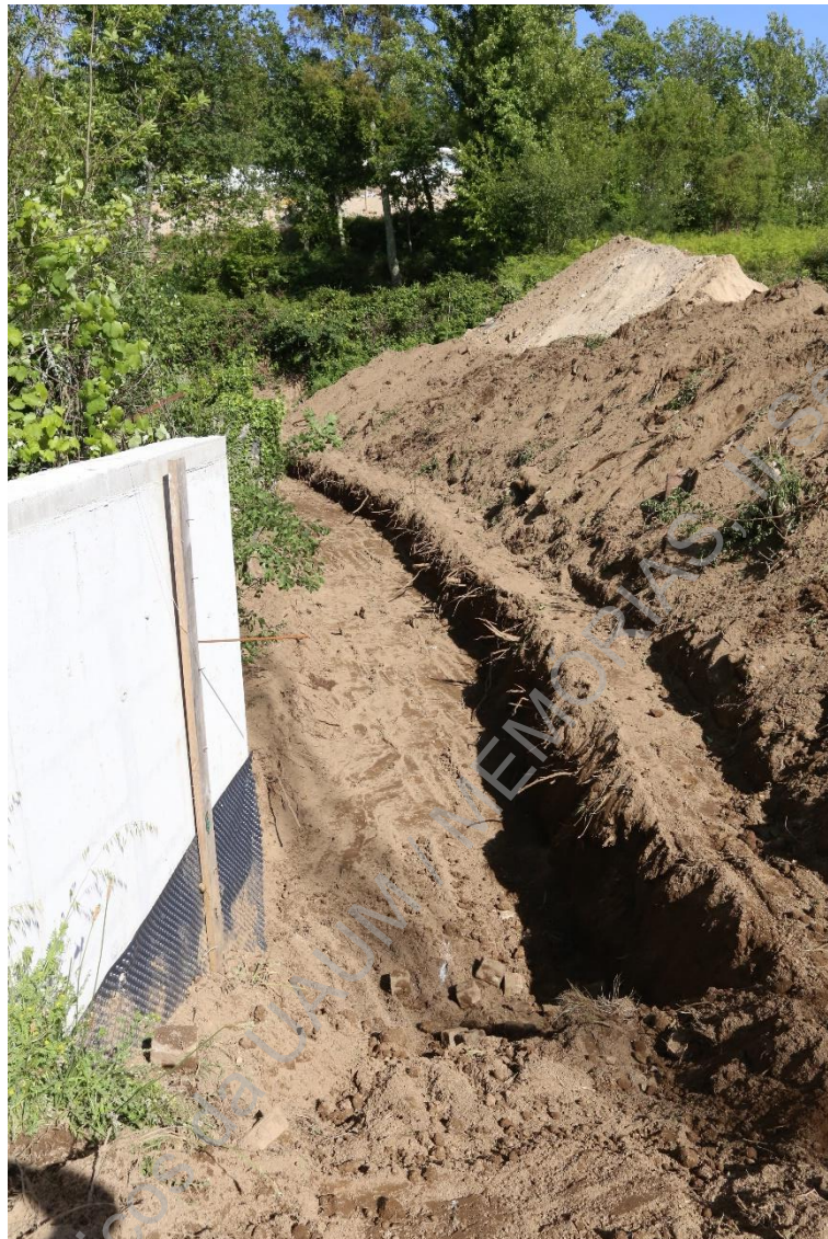
Foto 28 (IMG_1443) – Aspeto geral da vala para implantação de muro.
