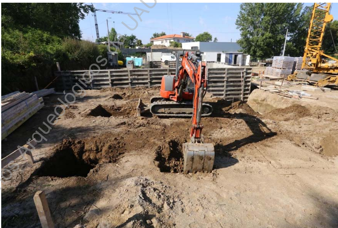
Foto 32 (IMG_2610) – Perspetiva geral da abertura de valas.
