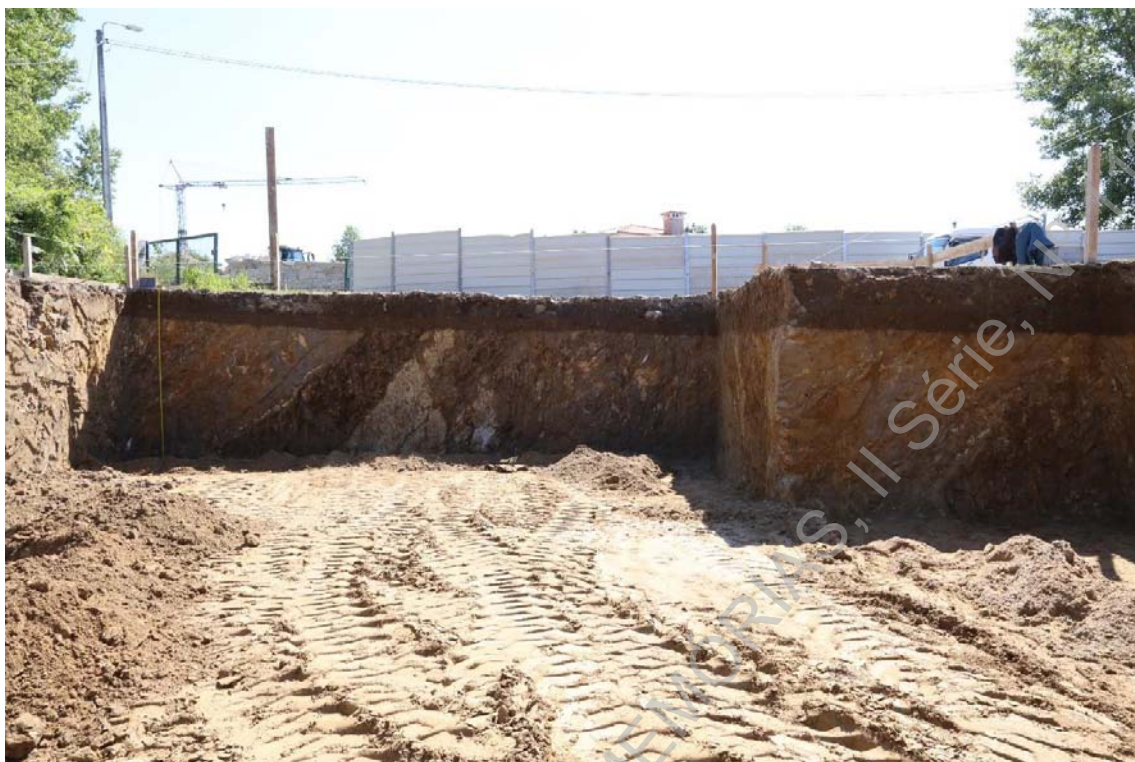
Foto 9 (IMG_0674) – Perfil oeste da área intervencionada.
