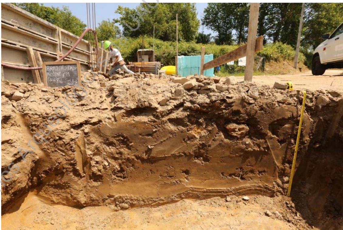
Foto 55 (IMG_2790) – Perfil sul da vala 11.
