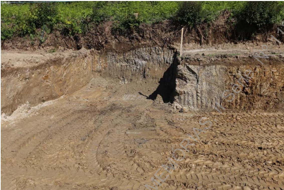
Foto 17 (IMG_1115) – Acompanhamento da abertura de rampa.
