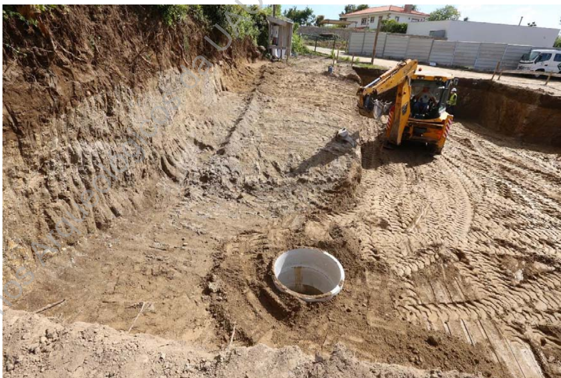
Foto 30 (IMG_1426) – Perspetiva geral da área intervencionada com entulhamento do poço de drenagem.
