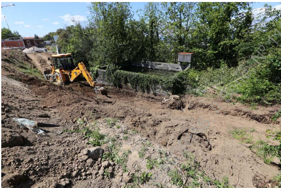
Foto 27 (IMG_1385) – Acompanhamento da abertura da vala para implantação de muro.
