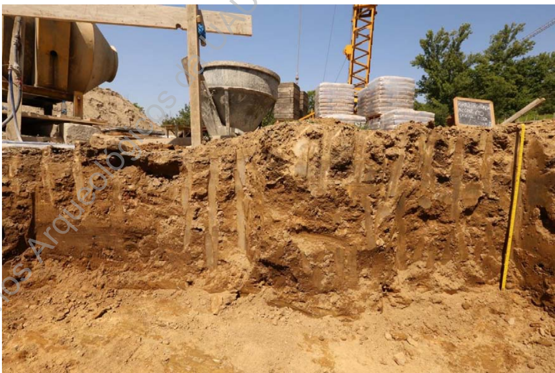
Foto 63 (IMG_2838) – Perfil este da vala 15.
