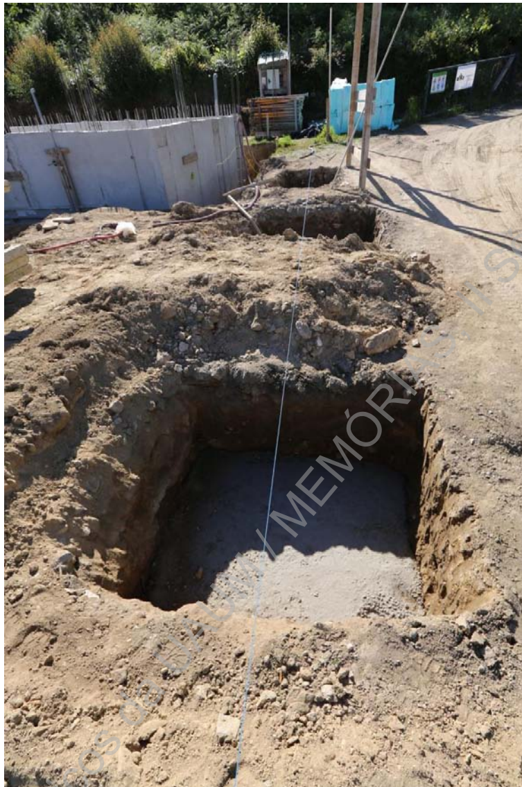
Foto 70 (Z45A8086) – Acompanhamento da colocação de betão de limpeza nas valas.
