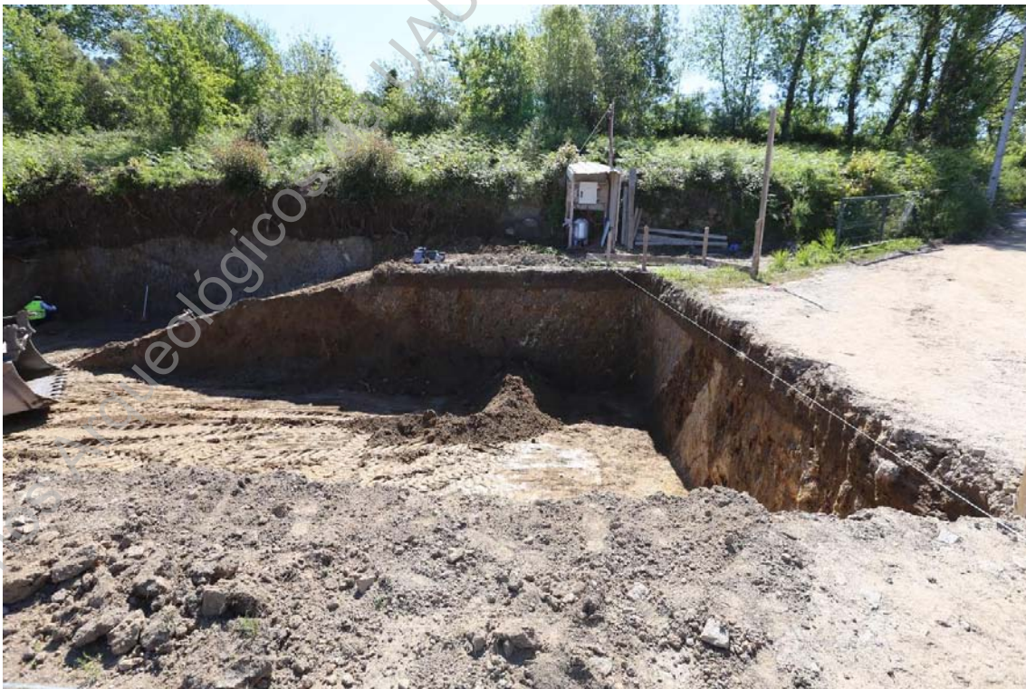
Foto 18 (IMG_1155) – Perpetiva geral da rampa de acesso.
