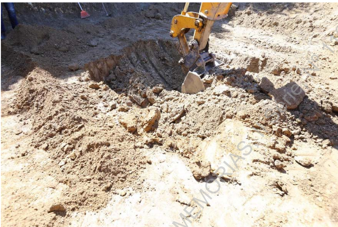
Foto 19 (IMG_1171) – Acompanhamento da abertura de poço de drenagem.
