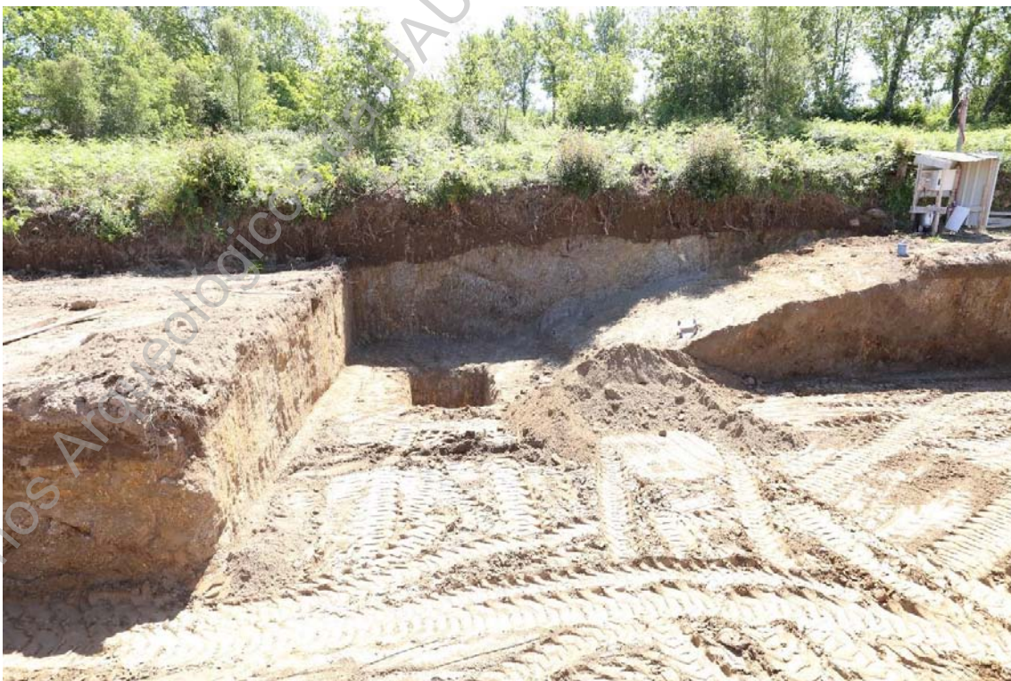
Foto 20 (IMG_1192) – Perspetiva geral da localização do poço de drenagem.
