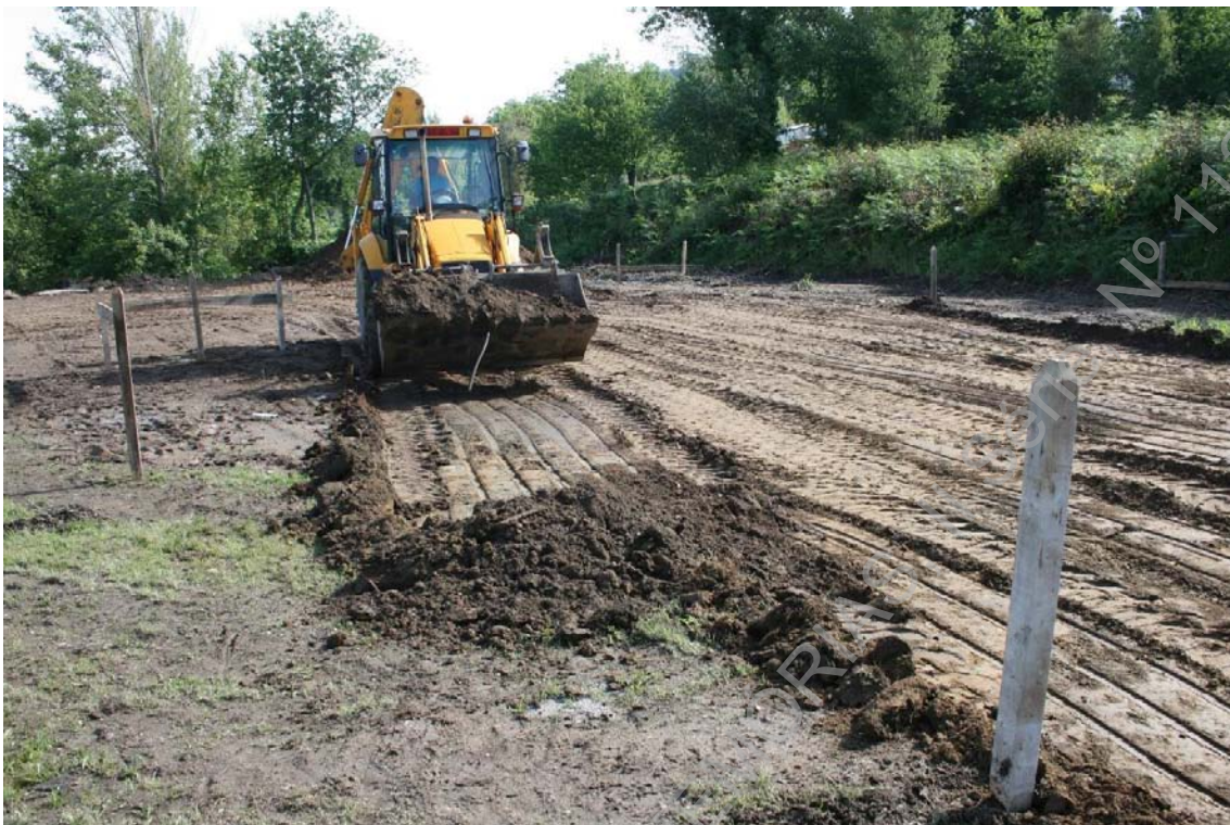
Foto 3 (IMG_1214) – Início dos trabalhos de decapagem do terreno.
