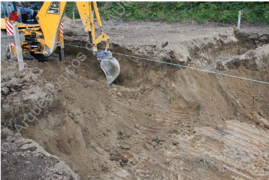
Foto 6 (IMG_1314) – Abertura de rampa de acesso.
