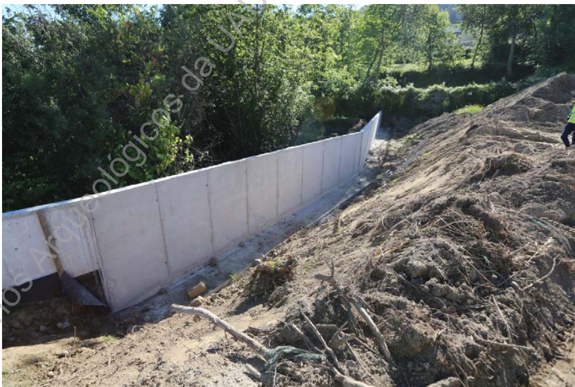
Foto 69 (Z45A8082) – Perspetiva geral do muro de delimitação do lote de construção.
