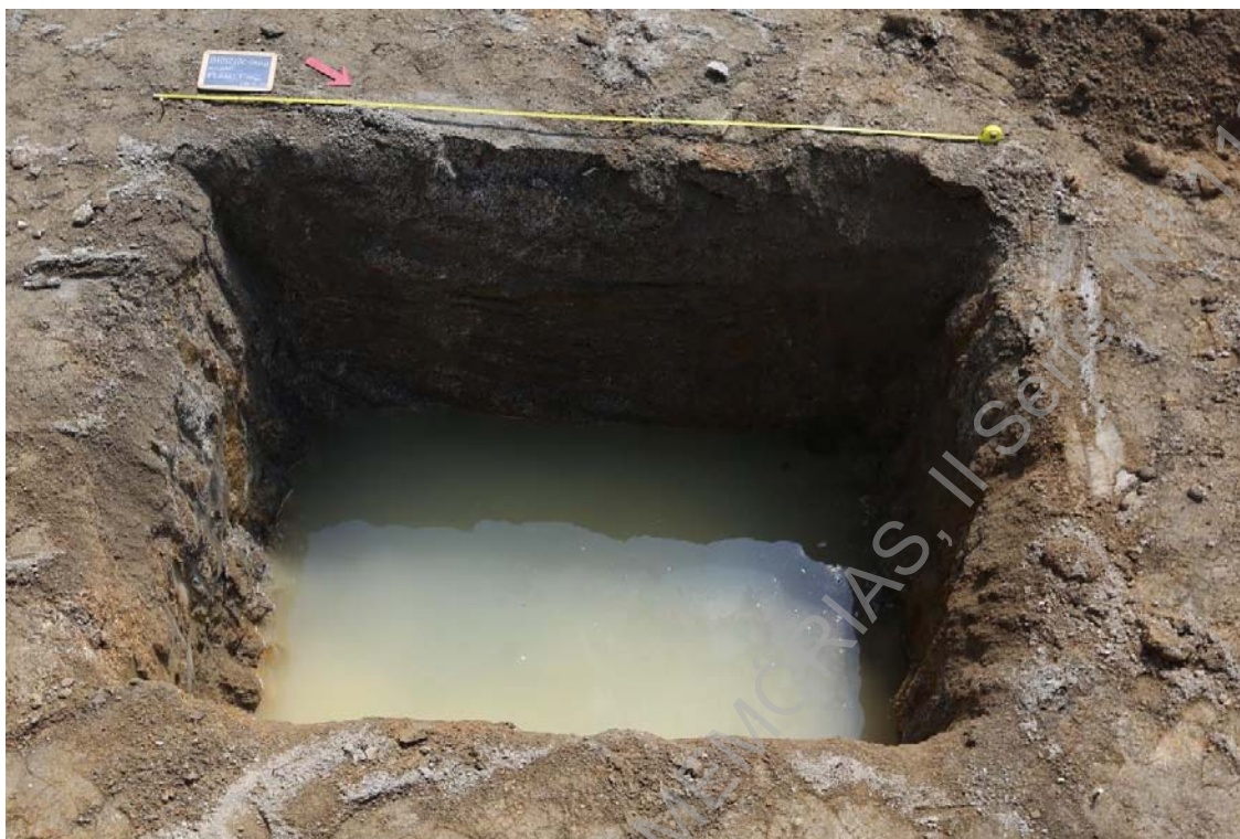
Foto 21 (IMG_1382) – Plano final do poço de dreganem.
