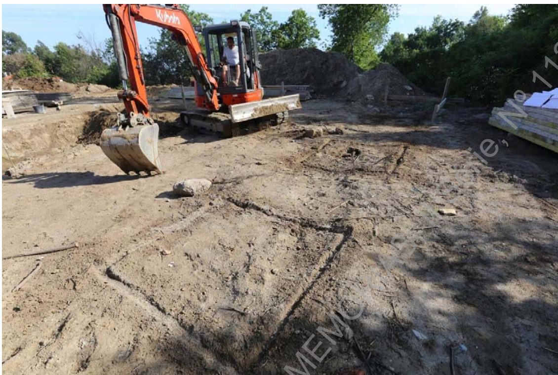
Foto 31 (IMG_2596) – Início do trabalho de abertura de valas para colocação de pilares nas traseiras do lote de construção.
