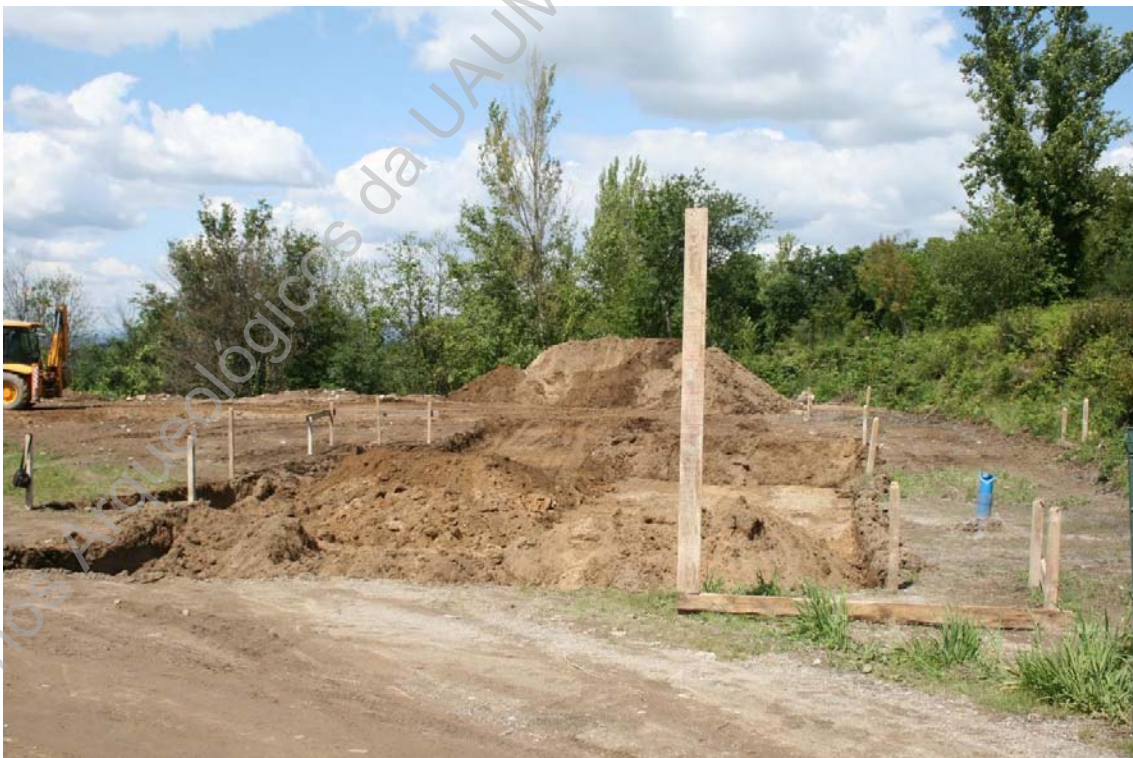
Foto 4 (IMG_1278) – Acompanhamento do trabalho de decapagem do terreno.
