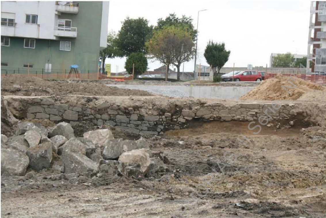
Foto 13 (IMG_9479) - Perspetiva geral do muro UE032 - Acompanhamento (E/O).
