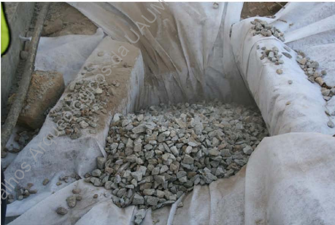
Foto 12 (IMG_9384) - Proteção da mina com geotêxtil e brita (S/N).
