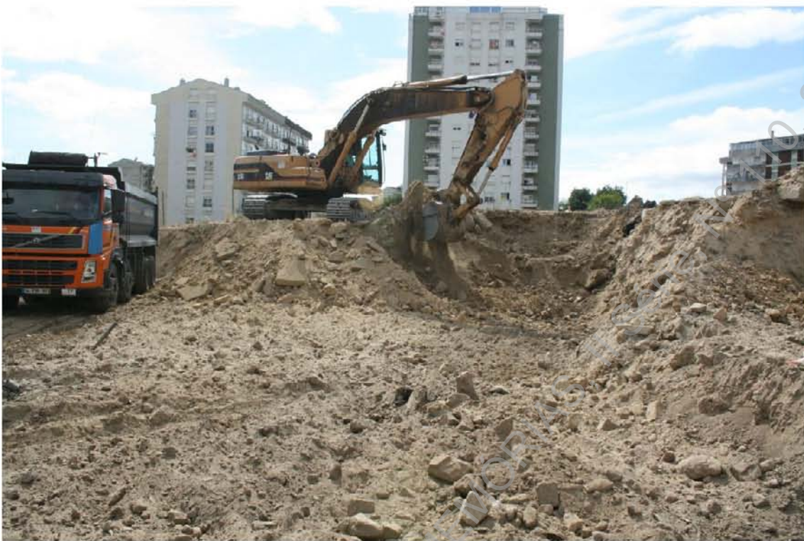
Foto 7 (IMG_8854) - Continuação dos trabalhos de decapagem (E/O).
