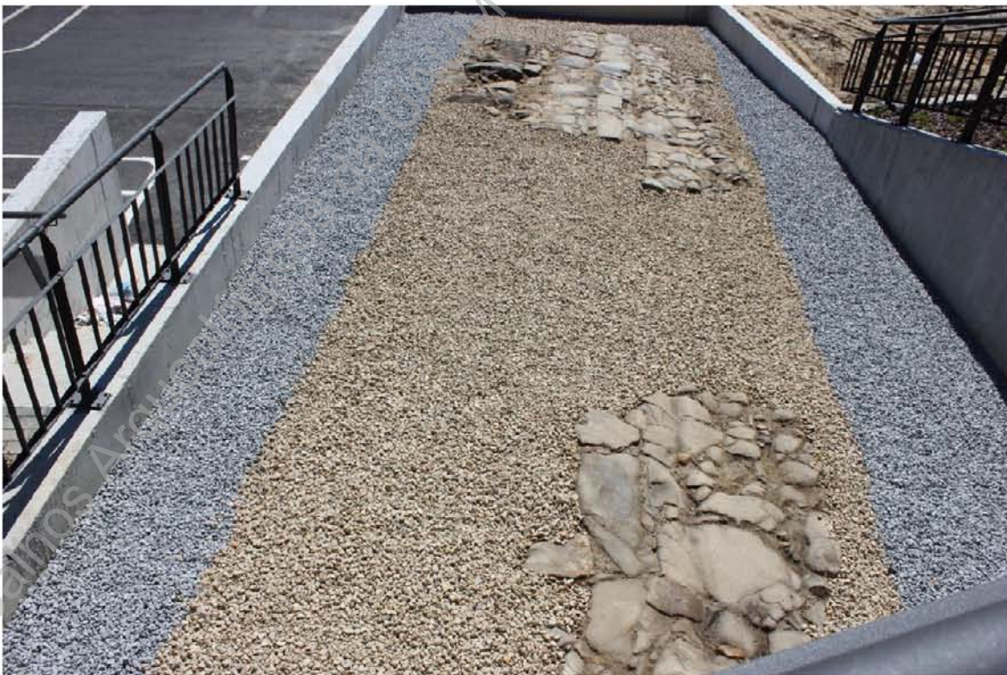
Foto 61 (IMG_4692) – Registo da calçada após os trabalhos de musealização.
