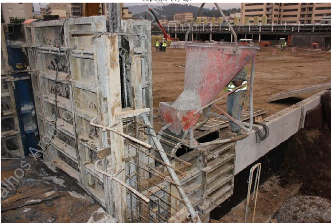
Foto 59 (IMG_2556) – Acompanhamento da betonagem das sapatas.
