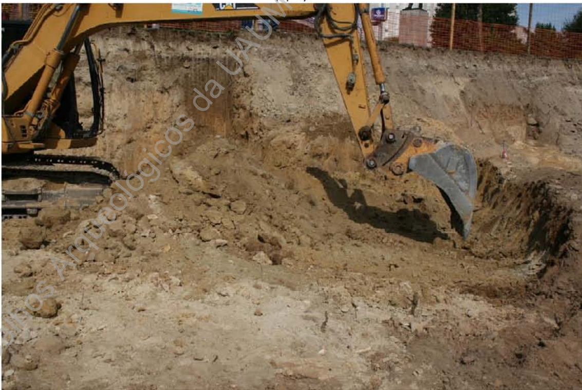
Foto 52 (IMG_9351) – Acompanhamentos de trabalhos de decapagem (S/N).
