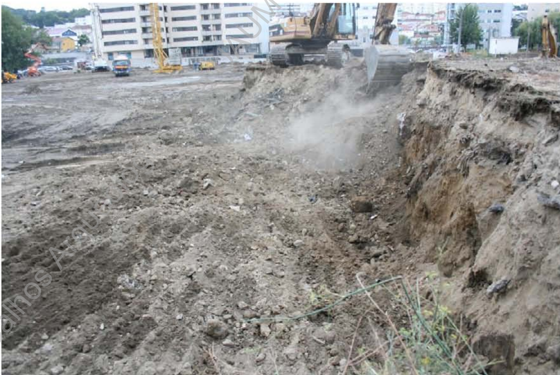
Foto 8 (IMG_9062) - Continuação dos trabalhos de decapagem (N/S).
