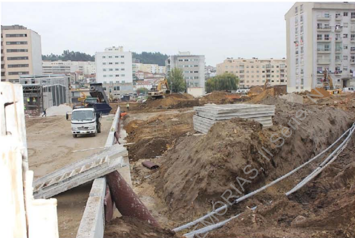
Foto 60 (IMG_2539) – Perspetiva geral dos trabalhos de construção na área intervencionada.
