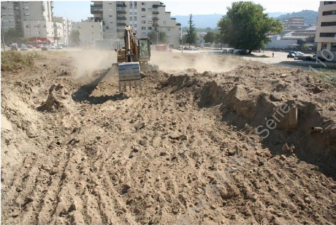
Foto 3 (IMG_8561) – Acompanhamento dos trabalhos de decapagem (O/E).
