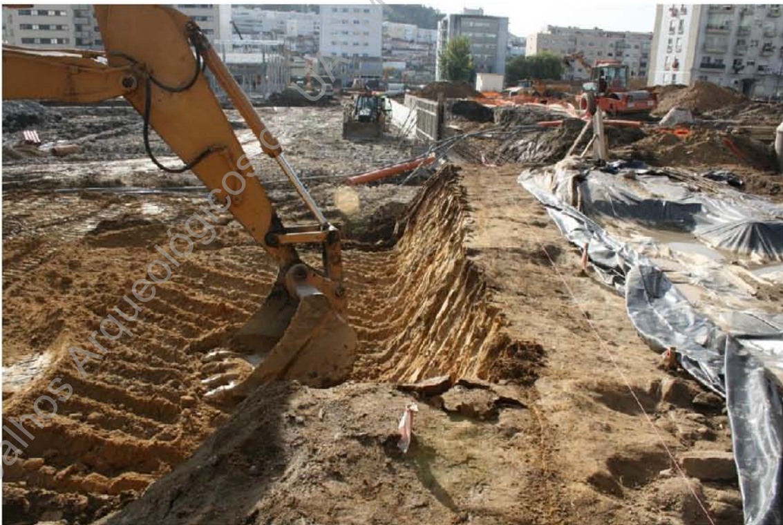
Foto 57 (IMG_9724) – Acompanhamento da continuação dos trabalhos de decapagem (N/S).
