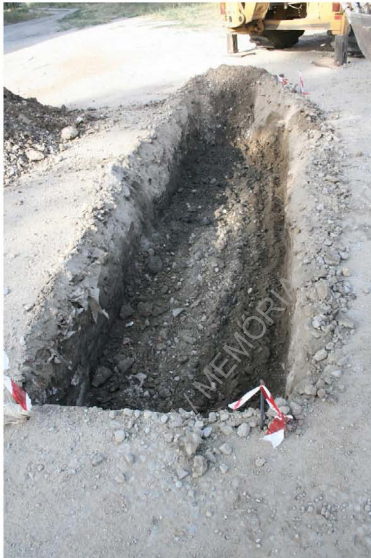
Foto 50 (IMG_8685) – Acompanhamento de abertura de vala para implantação de muro (E/O).
