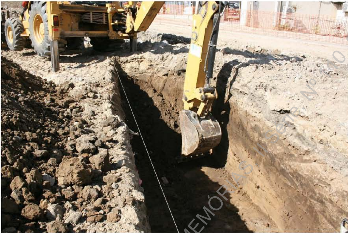
Foto 51 (IMG_9260) – Acompanhamento de abertura de vala para implantação de muro (S/N).
