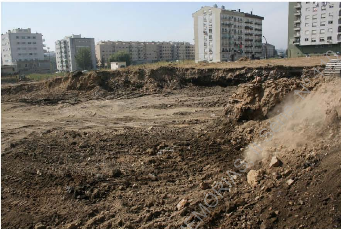
Foto 5 (IMG_8738) - Continuação dos trabalhos de decapagem (E/O).
