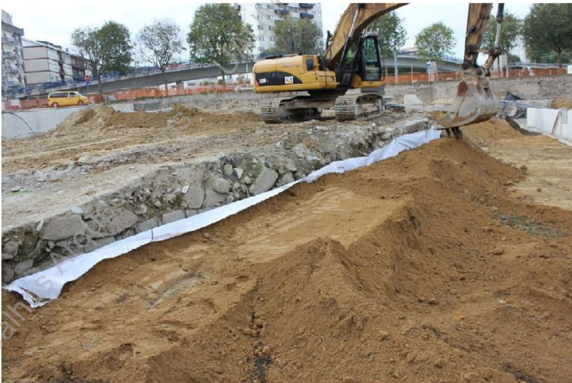
Foto 14 (IMG_2445) - Proteção do muro com geotêxtil e brita UE032 (S/N).
