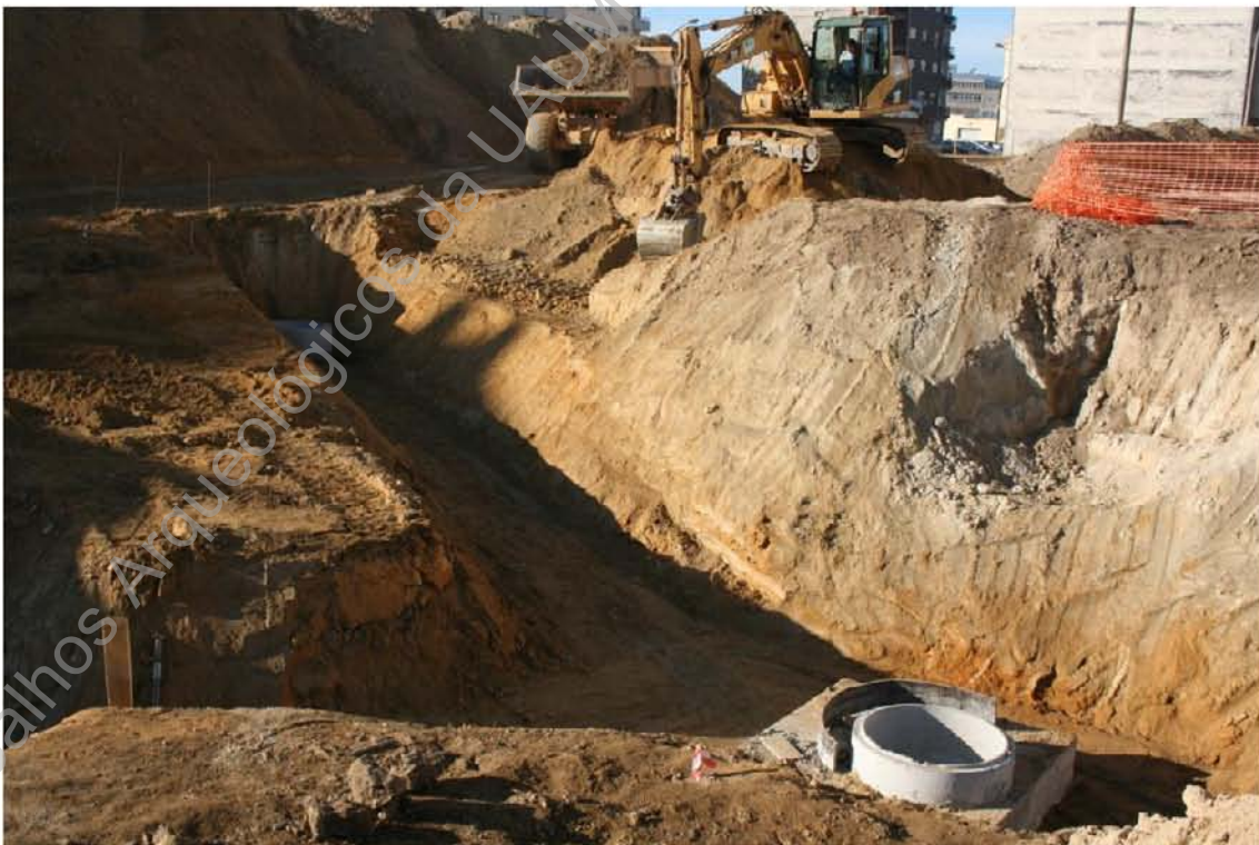
Foto 54 (IMG_9387) – Acompanhamento da abertura de valas para saneamento (N/S).
