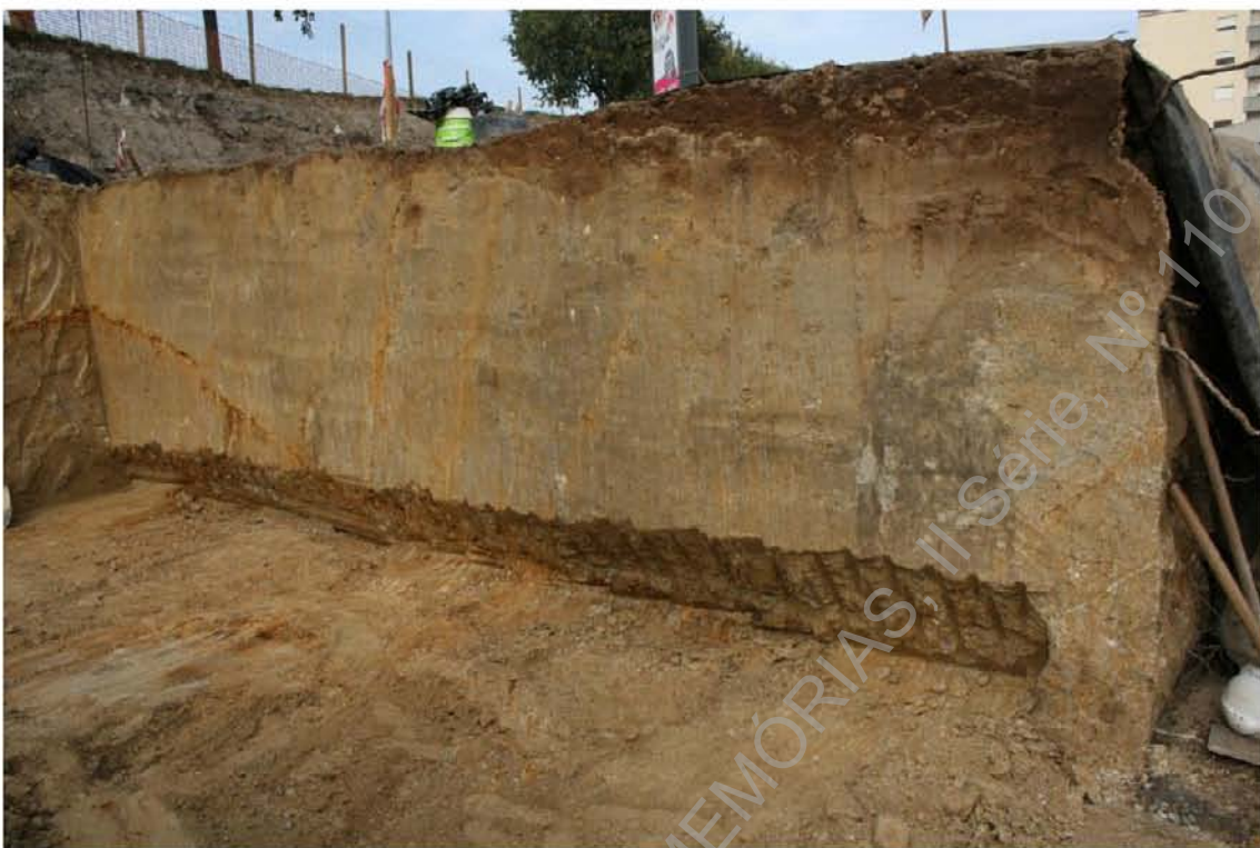
Foto 58 (IMG_9769) – Perspetiva final da decapagem das valas para a implantação das sapatas (O/E).
