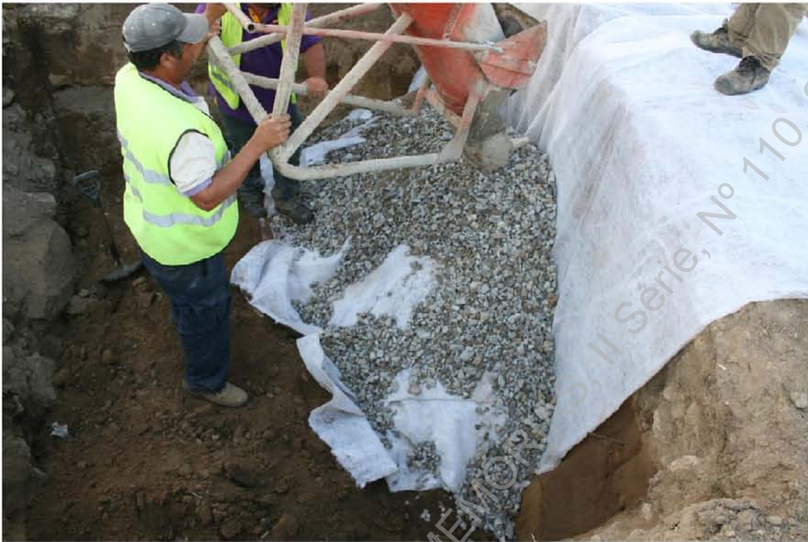
Foto 39 (IMG_9374) - Proteção das ruínas com geotêxtil e brita, Sondagem 3 (S/N).
