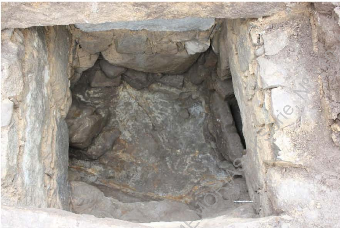
Foto 11 (IMG_1159) - Pormenor do interior da mina (O/E).
