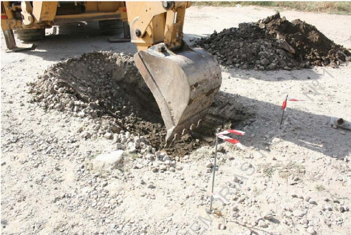
Foto 49 (IMG_8664) – Acompanhamento de abertura de vala para implantação de muro (S/N).
