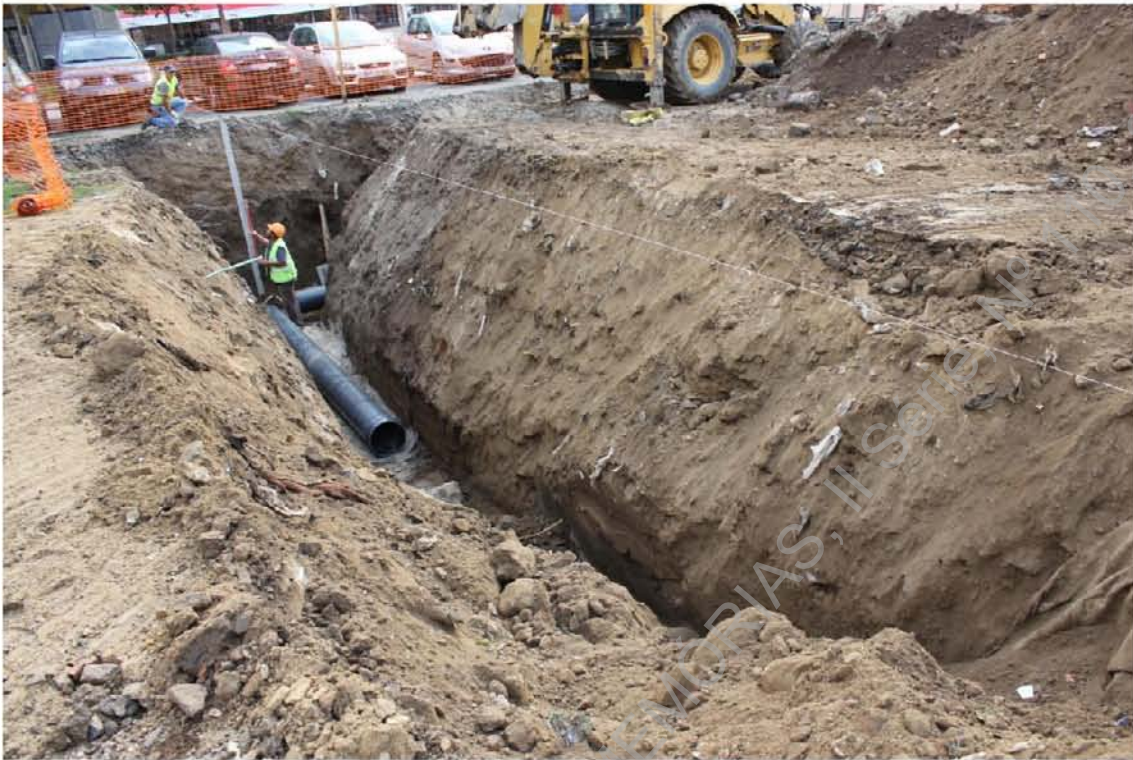
Foto 56 (IMG_2273) – Implantação de estruturas de saneamento (O/E).
