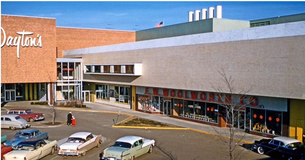
Figura 17 | Perspetiva do exterior do Southdale Center em Minneapolis, anos 70
