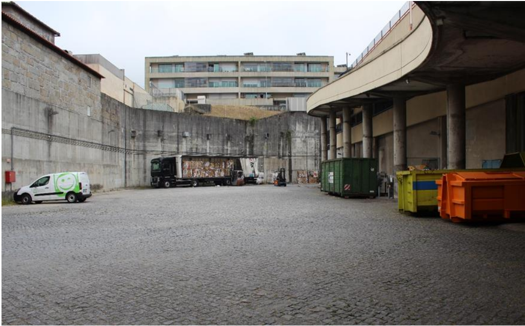
Figura 54 | Bastidores - zona de cargas e descargas
