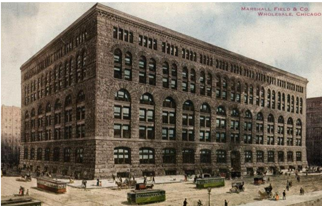
Figura 12 | Perspetiva exterior do Marshall Field's Wholesale Store em Chicago, desenhado por Henry Hobson Richardson
