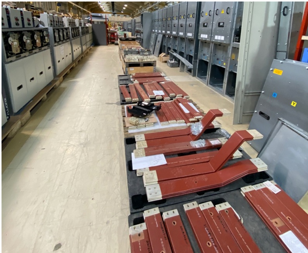
Figura 93 – Corredor de montagem apenas com material necessário para um projeto específico
