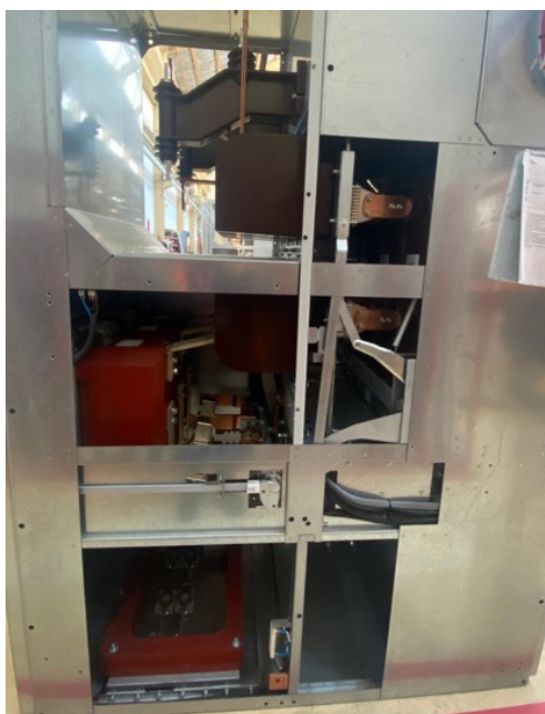
Figura 17 - Vista lateral do interior da cela
