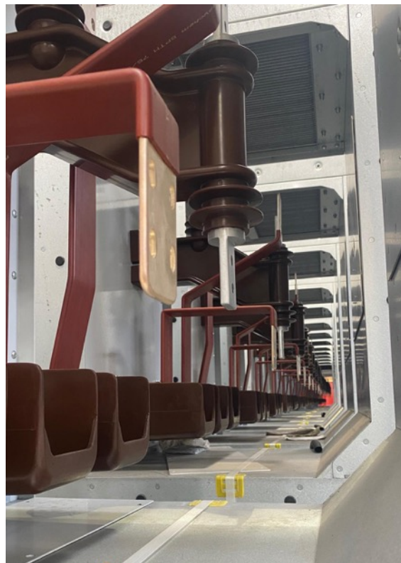
Figura 18 - Compartimentos de fases para a ligação do arame
