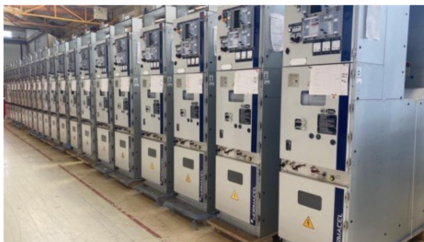
Figura 14 – Montagem em estaleiro
