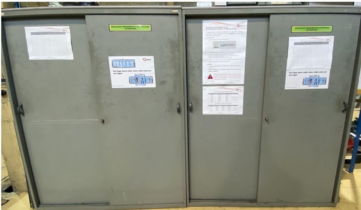
Figura 38 - Armários de máquinas / ferramentas com normas implementadas
