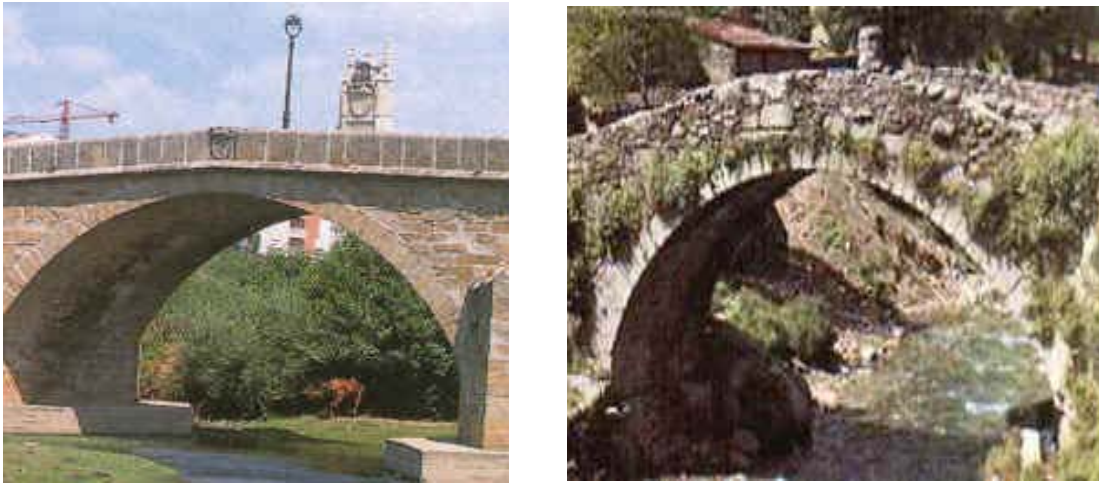
Figura 4.4 – Pontes de Pedra em Arco
