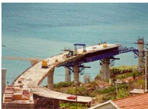
Figura 6.3 – Viga de lançamento inferior
