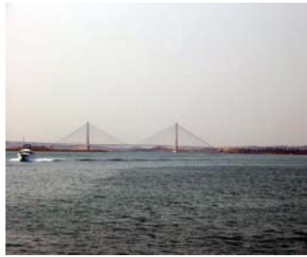
Figura 5.11 – Ponte do Guadiana
