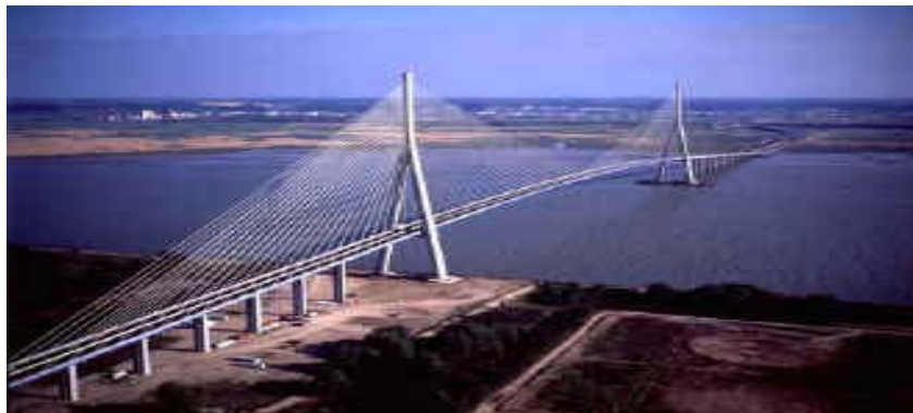
Figura 3.12 – Ponte da Normandie
