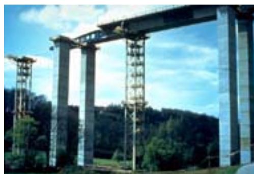
Figura 6.2 – Construção por incrementos
