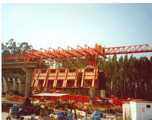
Figura 6.5 – Viga de lançamento superior
