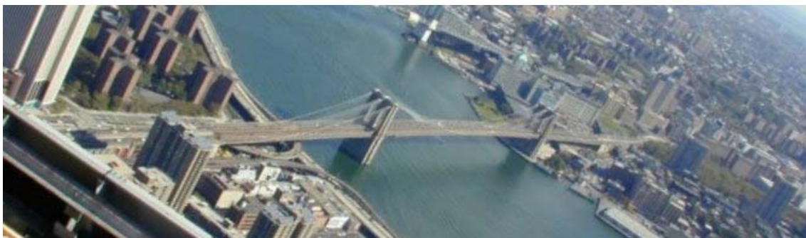
Figura 5.16 – Ponte de Brooklyn
