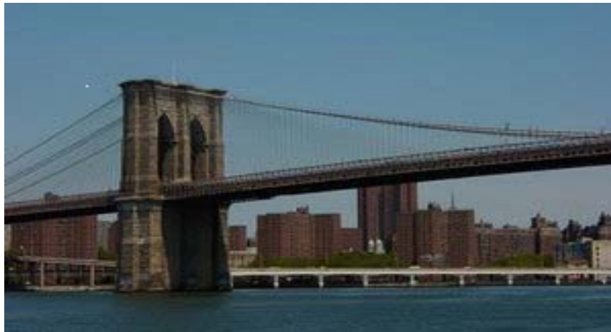
Figura 3.9 – Ponte de Brooklyn
