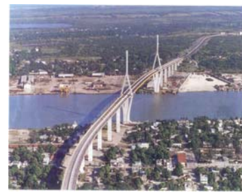
Figura 5.12 – Ponte do Tampico
