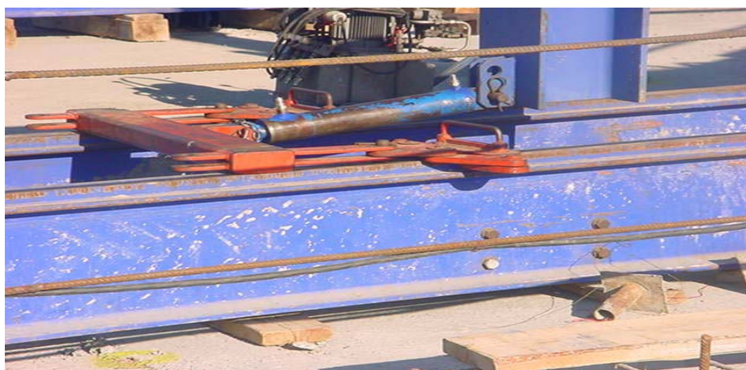
Figura 6.9 – Mecanismo de deslocamento do Carro de Avanço
