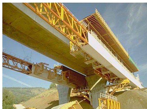
Figura 6.4 – Viga de lançamento em movimento
