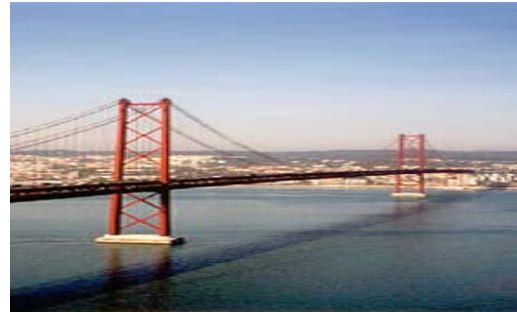
Figura 5.15 – Ponte 25 de Abril
