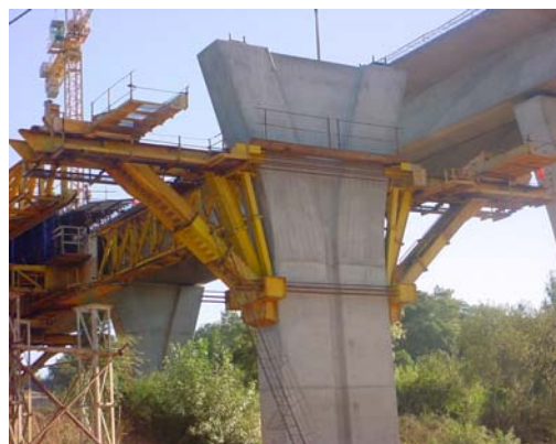
Figura 6.6 – Consolas de apoio das vigas
