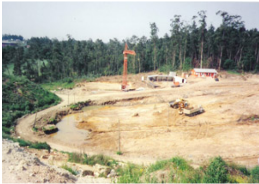
Figura 5.10 - Aspecto dos trabalhos de saneamento do local e impermeabilização de um alvéolo
