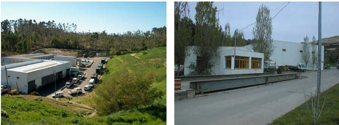
Figura 5.16 – Instalações do aterro: armazém e oficinas à esquerda e portaria com a balança
