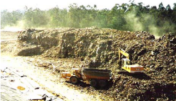
Figura 5.3 – Vistas da célula velha da lixeira antes da recuperação e na fase de reperfilamento
