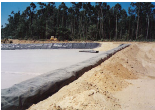
Figura 5.11 – Aspecto da impermeabilização dos alvéolos
