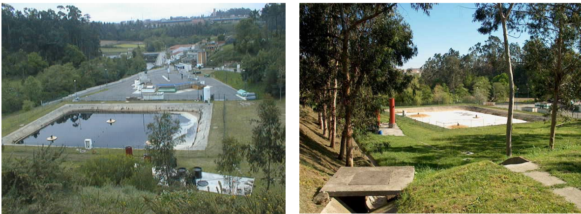
Figura 5.15 – Vistas da lagoa arejada para tratamento de lixiviados
