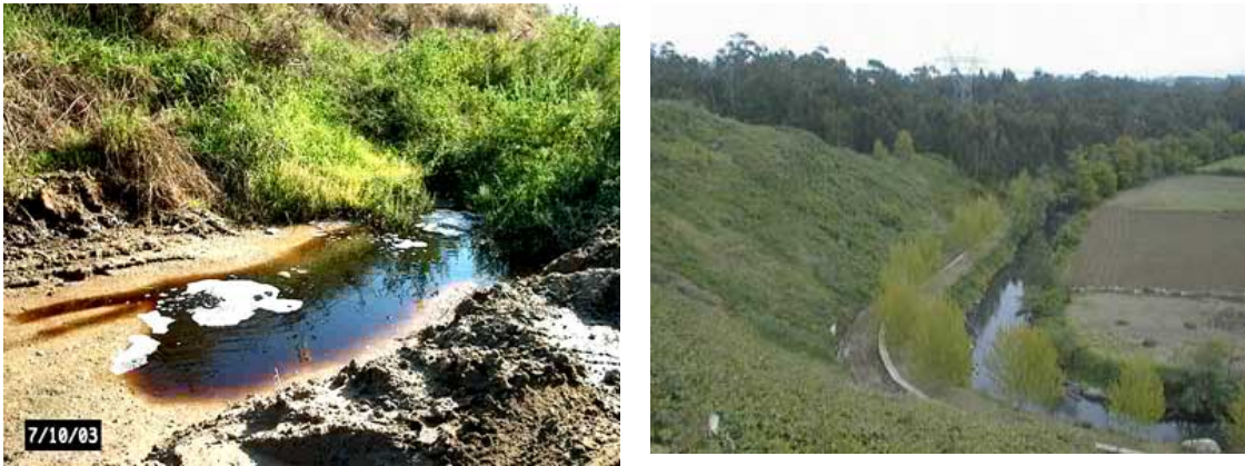
Figura 5.5 – Pé-de talude da lixeira antes e depois já com as paredes moldadas marginando o rio Leça
