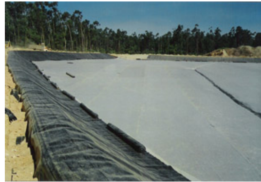
Figura 5.10 - Aspecto dos trabalhos de saneamento do local e impermeabilização de um alvéolo
