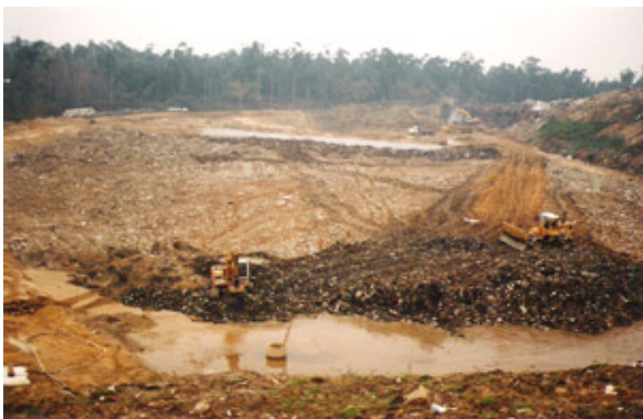
Figura 5.4 – Transferência de resíduos velhos para alvéolos novos
