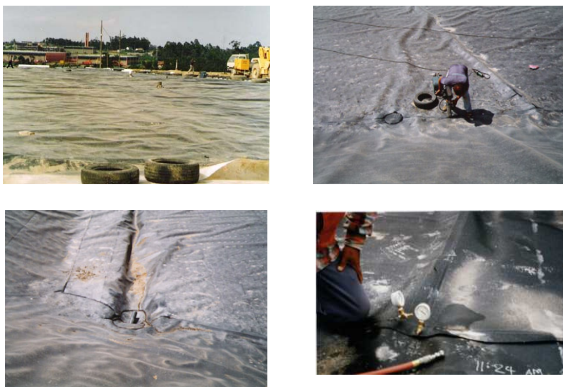
Figura 5.7 Impermeabilização do topo da célula velha e pormenor da termofusão das telas de PEAD e ensaios de estanqueidade dos cordões de soldadura.
