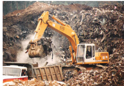
Figura 5.3 – Vistas da célula velha da lixeira antes da recuperação e na fase de reperfilamento
