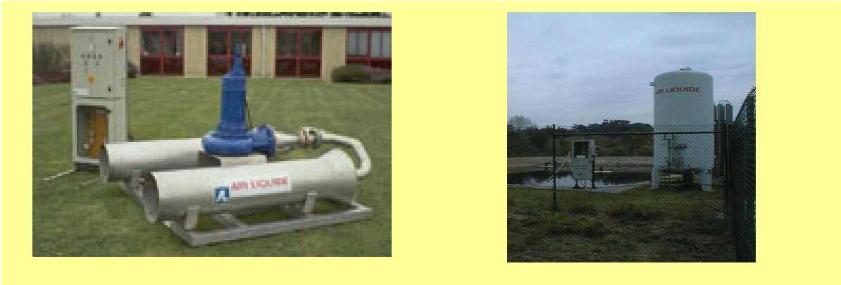
Figura 6.13 – Fotos do Ventoxal 300 e do depósito do oxigénio puro no AS de Matosinhos
