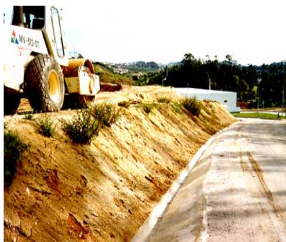
Figura 5.13 - Valeta de banquetta para drenagem de A.P. no Aterro de Matosinhos
