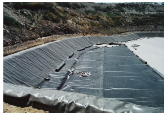
Figura 5.11 – Aspecto da impermeabilização dos alvéolos
