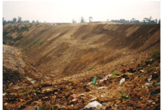
Figura 5.3 – Vistas da célula velha da lixeira antes da recuperação e na fase de reperfilamento
