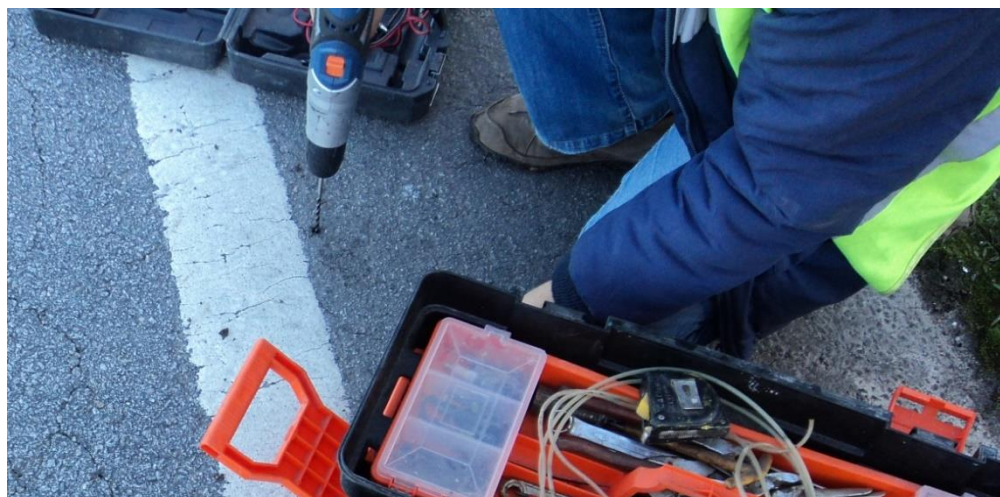
Figura 34 - Perfuração no pavimento para medição da temperatura a meio da camada betuminosa
