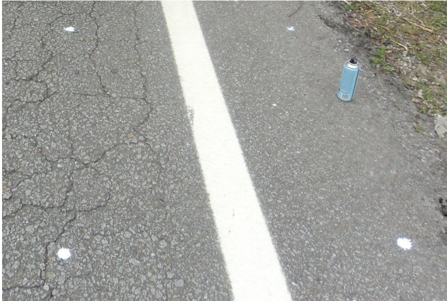
Figura 29 - Marcação de pontos de ensaio de deflexão
