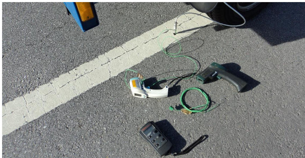
Figura 36 - Medição da temperatura em orifício a meio da camada betuminosa
