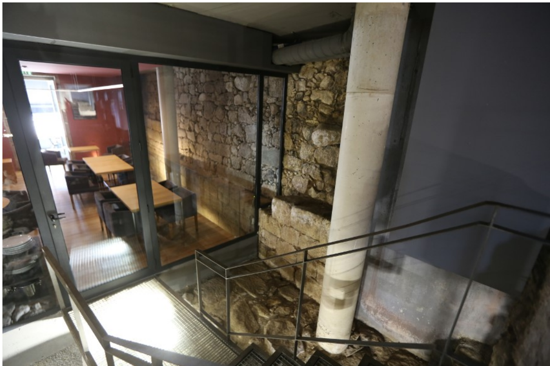
Figura 12 – Perspetiva geral do edifício n.º 1 da rua Afonso Henriques e pormenores das ruínas arqueológicas conservadas no piso térreo interior
