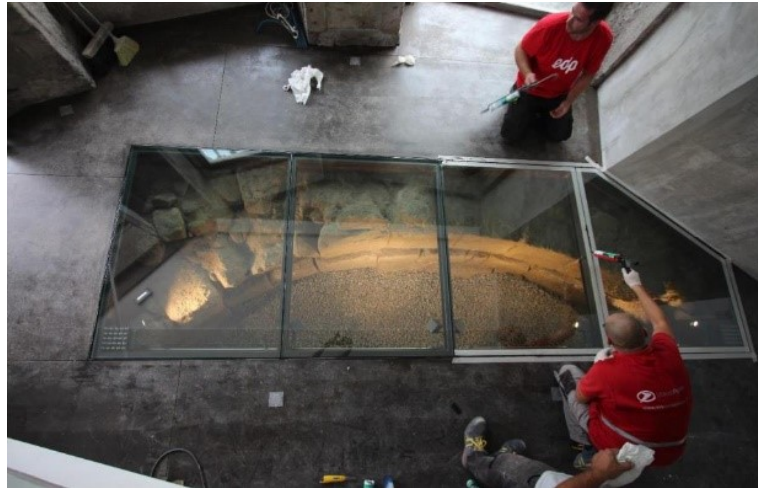
Figura 32 – Pormenores da integração dos alicerces do torreão manuelino.
