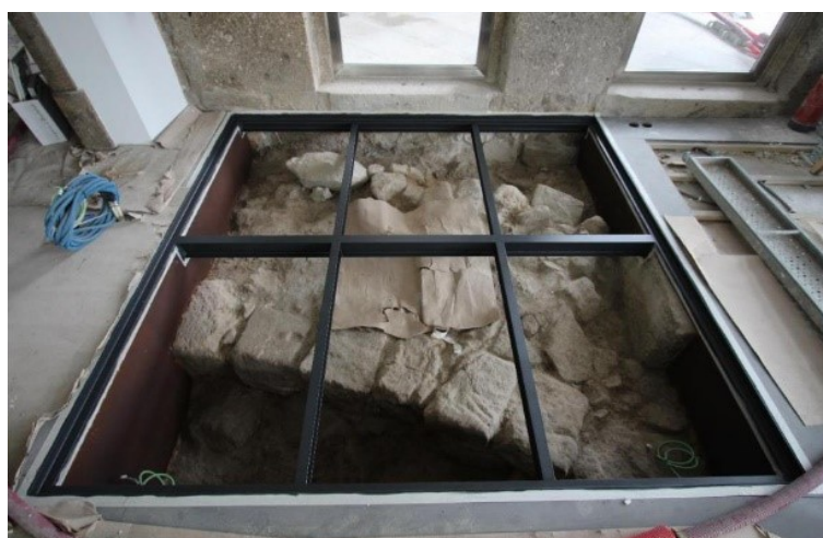
Figura 31 – Pormenores da solução de preservação dos vestígios do poço/cisterna.
