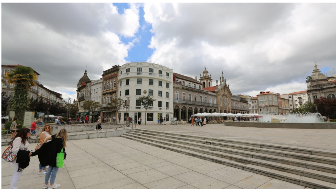
Figura 25 – Perspetiva geral da Arcada. Ao centro, de cor branca, o edifício nº 1 da Praça da República.
