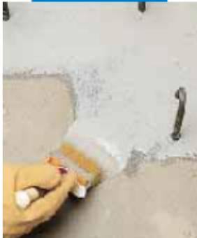
Aplicação do Eporip com pincel para represa de lançamento
