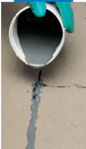
Reparação de fissura em massa de cimento com Eporip
