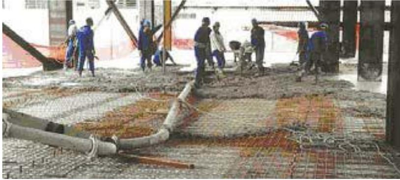
Figura 2.8 - Betonagem acima da laje mista. Fonte: (Vasconcellos, 2003)
