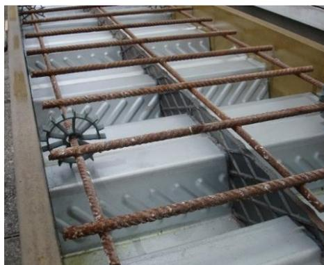
Figura 3.12 - Armadura introduzida na viga
