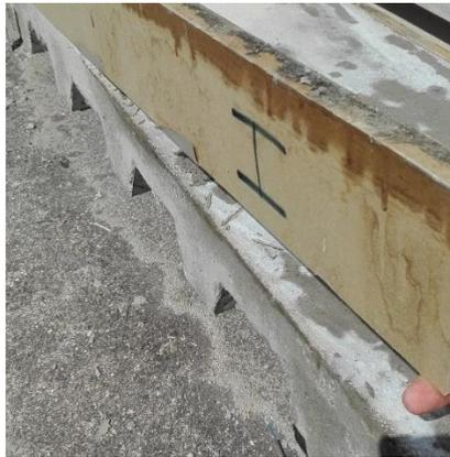
Figura 3.20 - Descofragem das vigas
