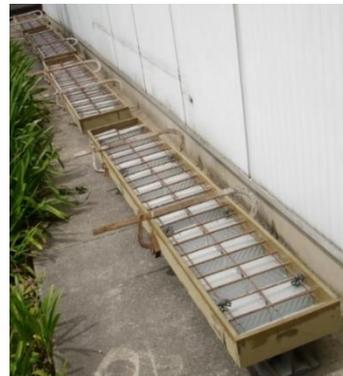
d) Componentes metálicas + cofragem + armadura + elementos de travamento
