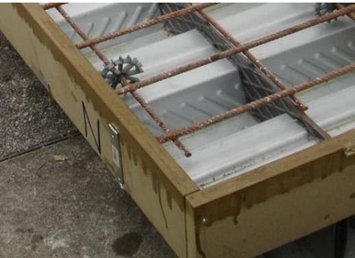
c) Componentes metálicas + cofragem + armadura
