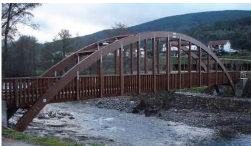
Figura 2.21 - Ponte Pedonal de Góis (Salgado, Branco, Cruz, & Ayala, 2014).
