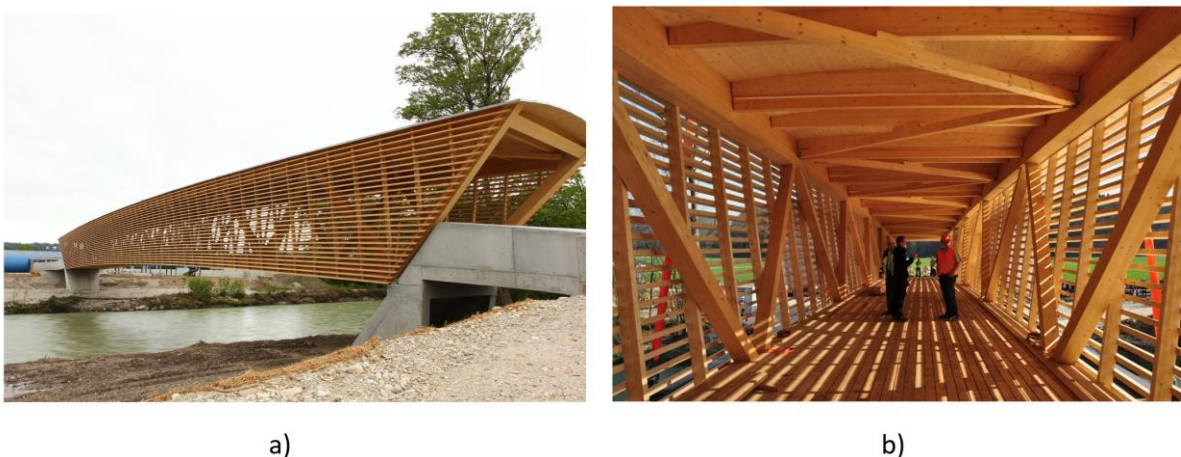
Figura 2.18 - Ponte de Neumatt em Burgdorf, Suíça a) vista exterior b) vista interior (Ingenta, 2017).
