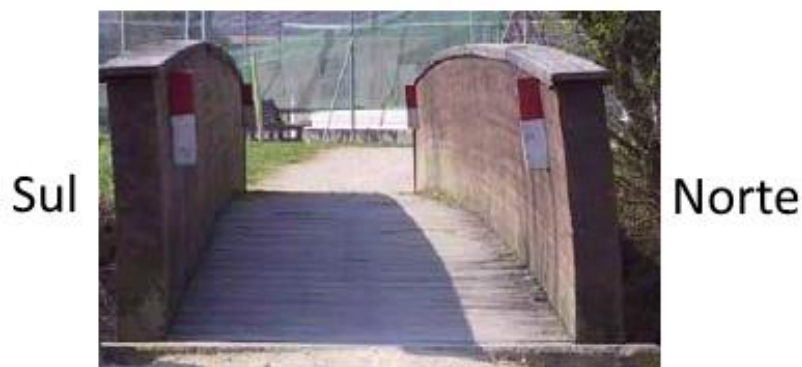
Figura 2.36 - Fenómeno de secagem rápida numa face da viga (Cost FP 1101, 2017).
