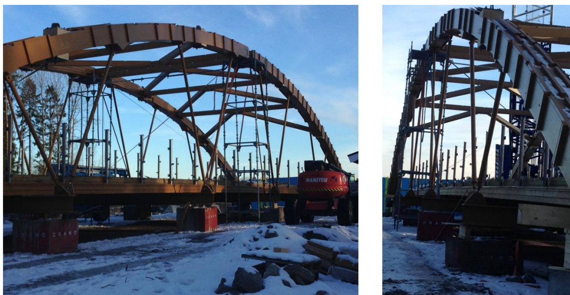
Figura 3.7 - Construção do passadiço de Haninge.
