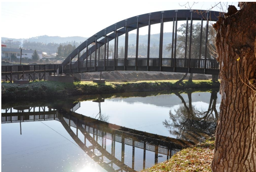
Figura 2.22 - Ponte Pedonal sobre a Ribeira da Sertã (O nosso rasto, 2017).
