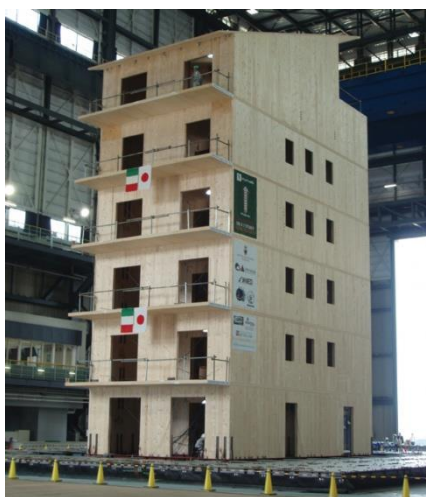
Fig. 12 – Edifício de sete andares em CLT testado na maior mesa sísmica do mundo, Japão (Karacabeyli e Douglas, 2013).
