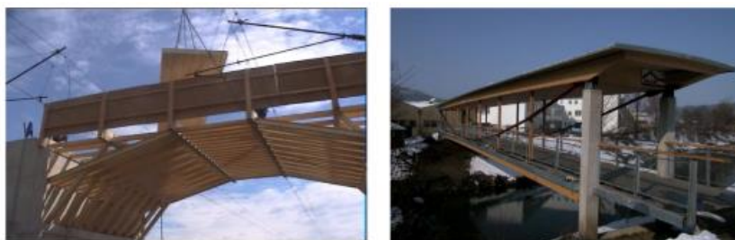
Fig. 124 – Ponte CLT Spielberg (esquerda) e ponte Raabsteg Feldbach (direita) (Mandegarian e Milev, 2010).
