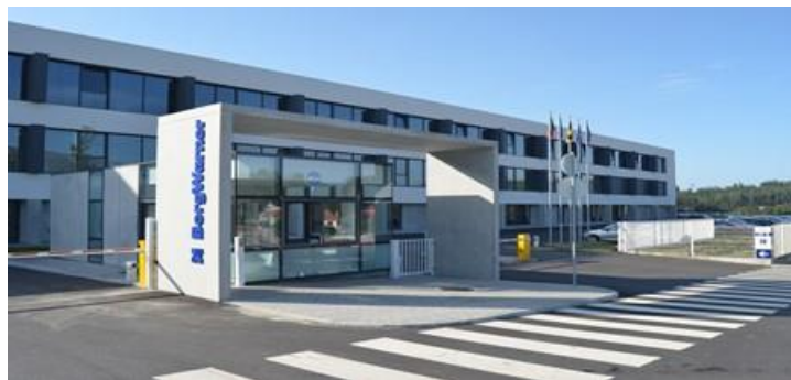
Figura 6 – Instalações da BorgWarner Emissions, Thermal and Turbo Systems Portugal
