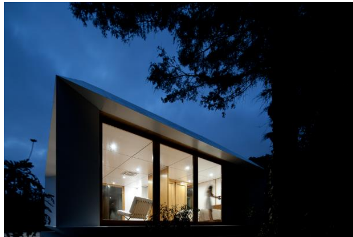
Figura 15 - Mima House em funcionamento. (Mima Architects, 2012)
