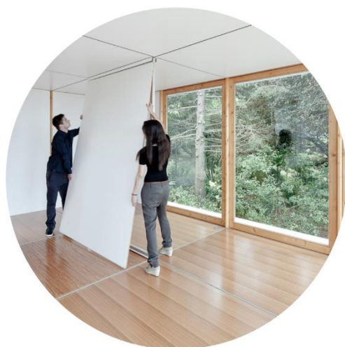
Figura 16 - Fases de colocação do sistema de compartimentação interior na Mima House ( Mima Architects, 2012 )
