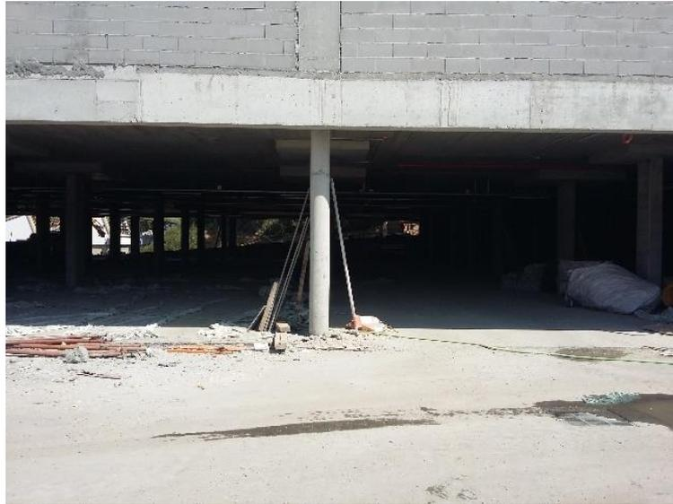
Figura 77. Piso 0 sem escoras - Segundo Levantamento.
