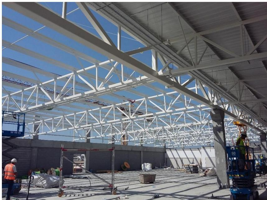
Figura 76. Metade da cobertura metálica com chapa.
