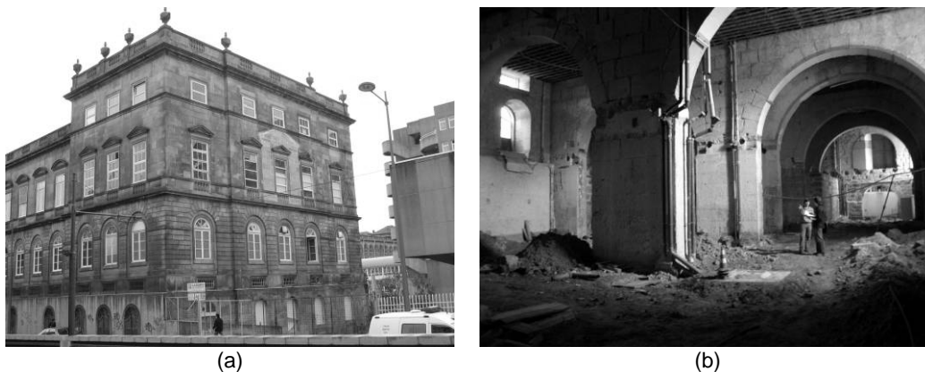
Figura 2 – Pormenores da constituição geométrica do HGSA: (a) Fachada Oeste da Ala Norte do HGSA; (b) Pisos 0 e +1 (actualmente em remodelação).
