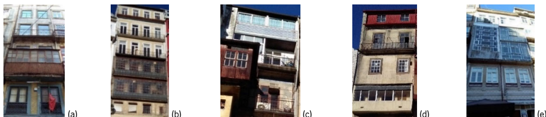
Figura 6.14. Exemplos de estufas correntemente utilizadas, exemplos recolhidos em edifícios localizados na cidade do Porto: (a) e (b) estufas tradicionais; (c), (d), (e) estufas convencionais.
