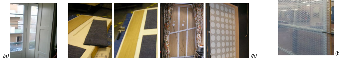
Figura 6.21. (a) Portadas de vidro que atuam como vidros duplos. (b) Membrana de ETFE tensada e com padrão refletor que pode ser utilizada para execução de portadas alternativas às de vidro.
