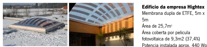
Figura 4.16. Vista exterior e interior do protótipo de integração de células fotovoltaicas em membranas (Detail, 2016).
