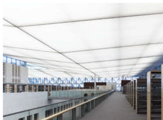
01_Teto interior em membrana
