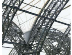
Pormenor de ligação entecadeira e estrutura existente.
