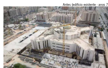
Antes (edifício existente - anos 70)
