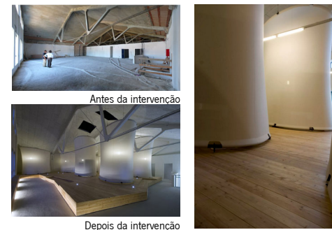
Figura 93. Vistas do interior do edifício existente com as paredes interiores em membrana – projeto da autoria do arquiteto Antonio Ravalli (RAVALLI, 2016).
