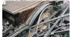
Fase de construção: ligação da nova treliça secundária com o arco de suporte existente.
