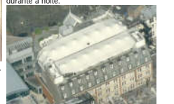
07_ Vista exterior da cobertura em membrana durante o dia (ano 2016).
