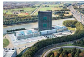
02_Vista geral do edifício após renovação
