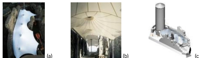
Figura 8.4. Ruínas do castelo de Thierstein (Suíça) - contraste entre a nova estrutura temporária entre as ruínas: (a) vista panorâmica da cobertura inserida na ruína; (b) vista interior do espaço coberto com estrutura em membrana; (c) vista axonométrica (Kugel, 2013).
