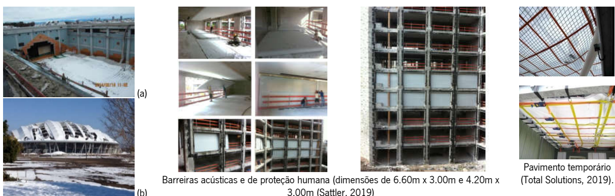
Figura 4.44. Colapso de cobertura devido a queda de neve intensa em 2014 (Fujimi, Japão): (a) Cobertura leve convencional com revestimento metálico e (b) cobertura alternativa com membrana (Kumagaya Sports Park) (Kawaguchi, 2017). (c) Meios auxiliares de proteção.
