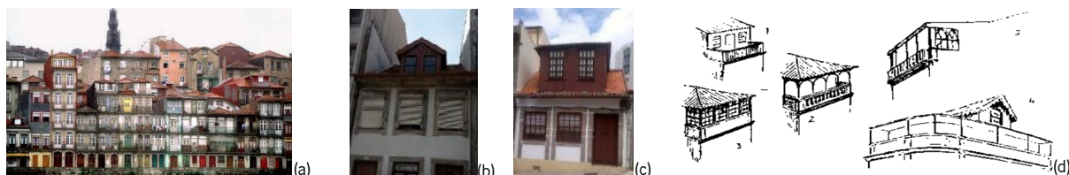
Figura 7.16. (a) Exemplo nacional de intervenções de ampliação vertical, cidade do Porto. (b) Exemplo de trapeira e (c) de mirante.
