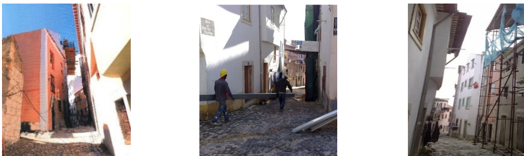
Figura 7.41. Exemplos de intervenções de reabilitação em que foi necessário adotar soluções leves para viabilizar a execução de operações de manutenção e ampliação vertical.
