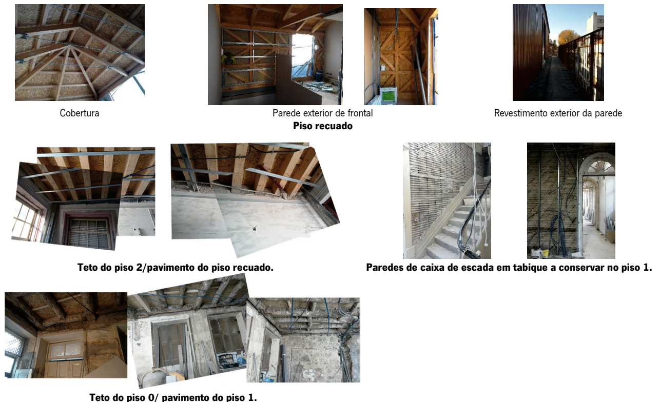
Figura 7.30. Fotos dos elementos a manter, reforçar e construir (créditos: autora).
