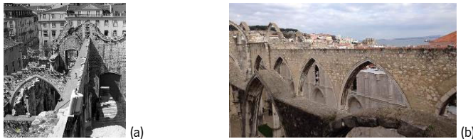
Figura 8.25. (a) Operação de consolidação/regularização do espaço entre arcos com o enchimento dos mesmos - vista do terraço da cabeceira; 1954 (Fonte: http://www.monumentos.pt/Site/APP_PagesUser/SIPA.aspx?id=6521 ). (b) Espaço entre arcos a regularizar (proposta).
