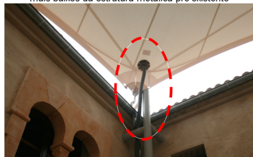
Drenagem pontual através de tubos flexíveis. Bocal soldado à membrana.
