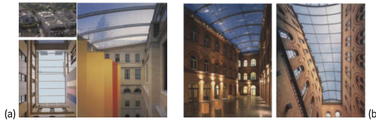
Figura 4.42. (a) Cobertura dos desvãos do edifício "Her Majesty's Treasury", Londres, 2002. (b) Kapuzinercarrée, Aachen, 2002. O uso da cobertura pneumática em membrana de ETFE em vez de vidro permitiu a redução de cargas impostas a este edifício histórico e melhorou o seu desempenho energético.
