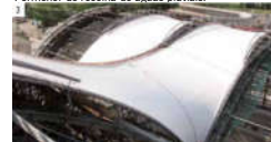
Fase de construção com membrana de 10 m de largura
