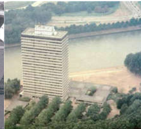
01_Edifício existente antes da renovação.
