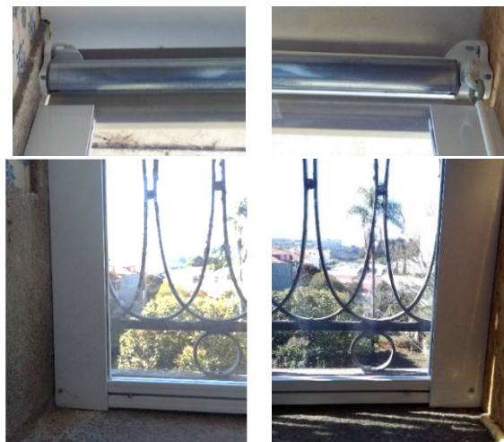
Figura 6.26. Cortina vertical em PVC cristal tensada para encerramento da varanda do edifício selecionado como caso de estudo.
