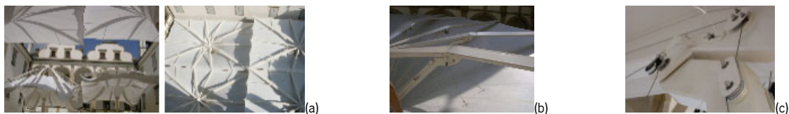
Figura 8.9. Castelo de Weitra, 2006 (fotos de Markisen): (a) quatro guarda-chuvas retangulares protegem 750 m 2 de pátio da chuva; (a) vista de baixo, durante o fecho dos guarda-chuvas e vista de cima, configuração totalmente aberta. Pormenores construtivos: (b) e (c) cada braço principal é equipado com um perfil metálico que forma uma das seções do guarda-chuva na configuração fechada.
