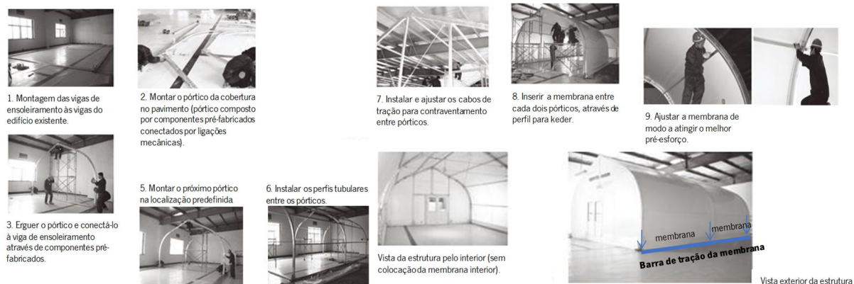
Figura 7.40. Ilustração do processo de montagem de uma estrutura com membrana (adaptado de Sprung, 2017).
