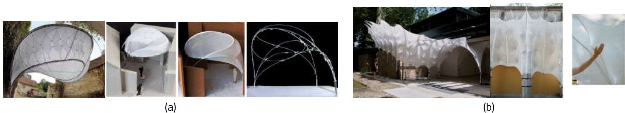
Varões de GFRP são embebidos numa membrana têxtil, atados em feixes e que conduzem aos postes de fundação em GFRP.
