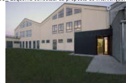
03_ vista exterior do edifício após renovação. 02_ Antes
