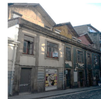
Figura 7.19. Exemplo de piso recuado em edifícios localizados na cidade do Porto.
