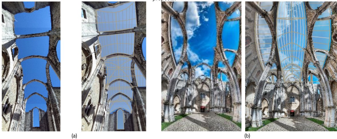
Figura 8.47. Ilustração do antes e após implementação da solução alternativa com membrana: (a) vista do transepto (b) vista da nave.
