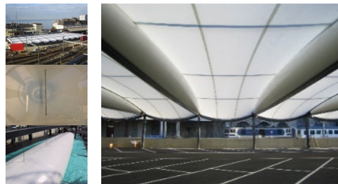
Figura 29. Cobertura do parque de estacionamento de Montreal com as vigas “tensairity” (AIRLIGHT Ltd, 2016).
