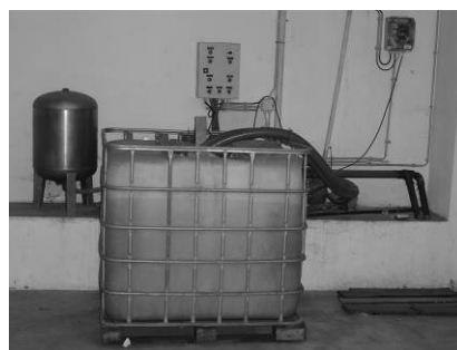
Figura 19: Sistema provisório de abastecimento.
