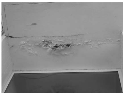
Figura 12: Anomalias na pala exterior.
