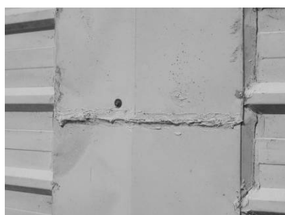
Figura 24: Remate da cumeeira com ligação topo a topo e silicone na junta.
