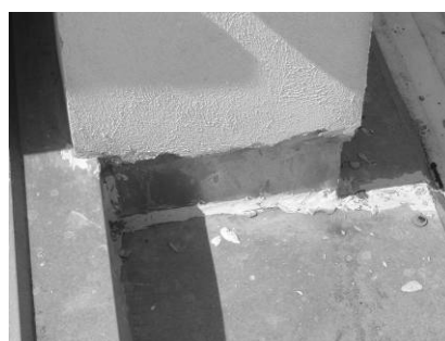
Figura 25: Rufo da chaminé com ligação topo a topo e silicone nas juntas.
