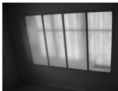
Figura 15: Topo superior da caixa de escadas.
