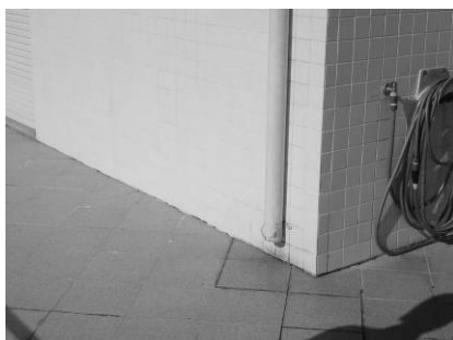
Figura 8: Tubo de queda com descarga em terraço.
