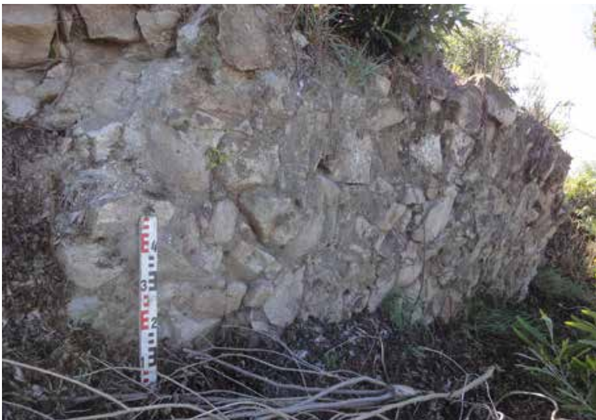
Fig. 6 - Vestígios de pano da muralha ou de muro de contenção de terras, existente na vertente norte do Monte de Santo António (Fotografia dos autores).
