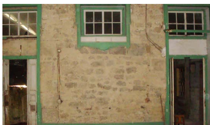
Figura 2: Parede caracterizada no edifício do Orfeão de Viseu.
