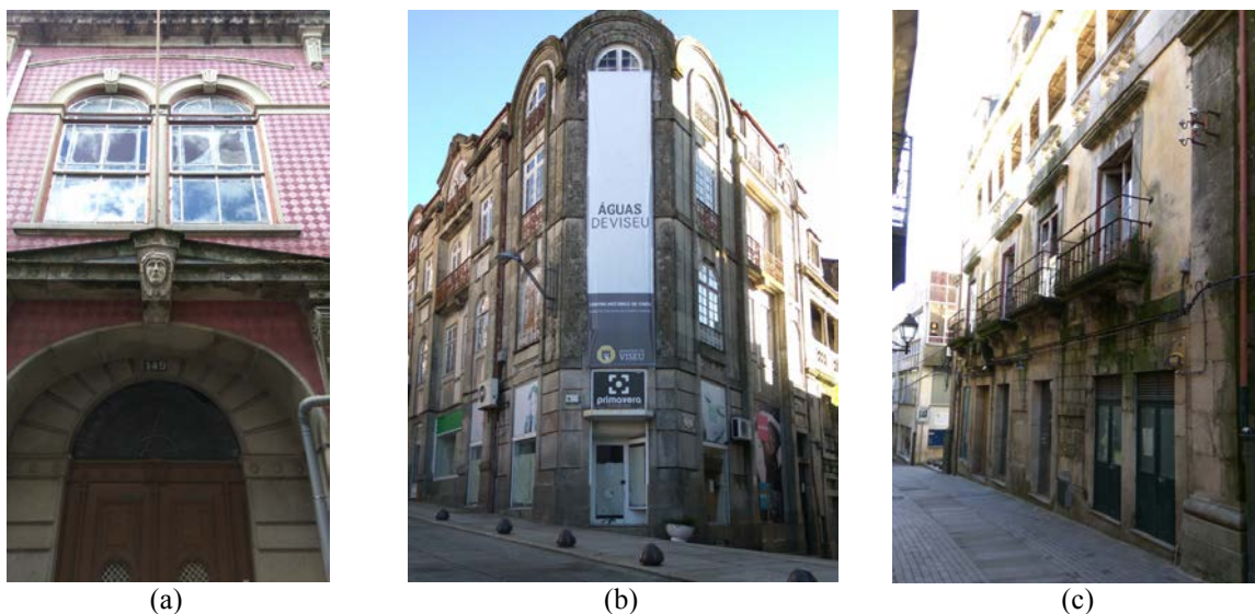
Figura 1: Fachadas dos edifícios estudados: (a) edifício do Orfeão de Viseu; e (b) edifício das Águas de Viseu, visto da Rua do Comércio, e (c) visto da Rua D. Duarte.
