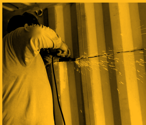
Corte das chapa de aço com rebarbadora. [FIG. 2]
