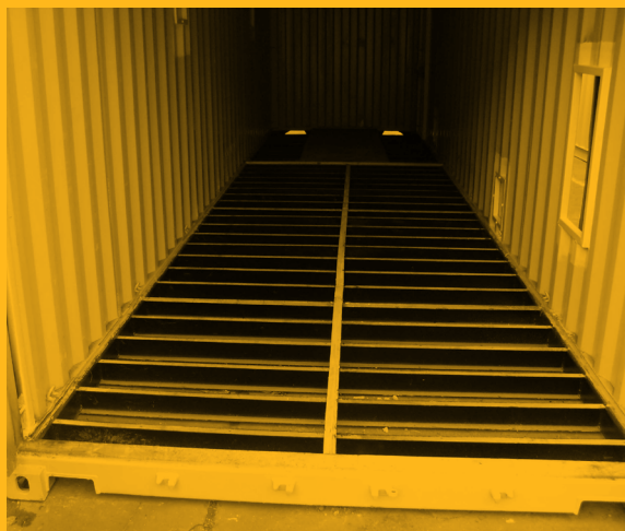
Imagem da estrutura inferior de um contentor sem as placas de bambu. [FIG. 1]
