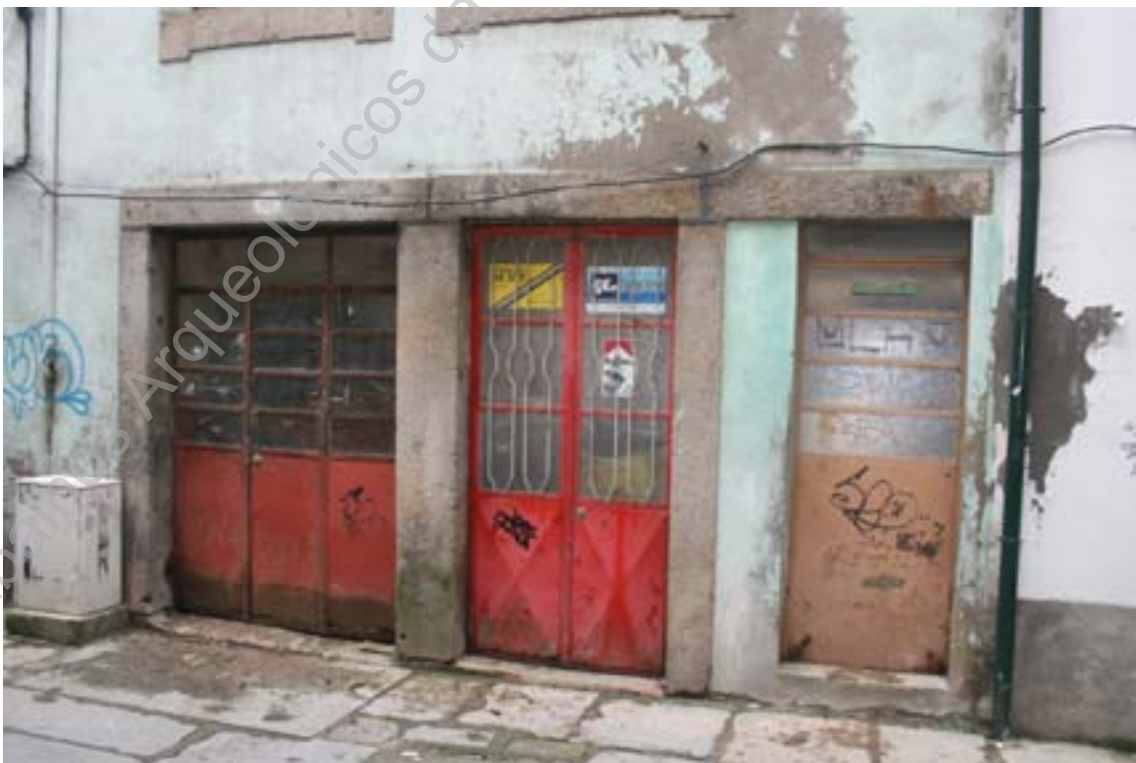
Foto 3 (IMG_7388) – Vista da fachada principal ao nível do rés-do-chão - entrada do prédio. (NO/SE).
