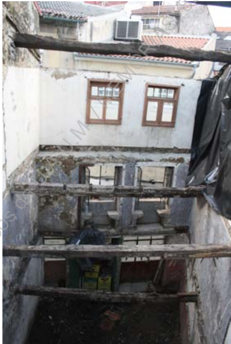
Foto 39 (IMG_7517) – Face interna da fachada principal após as demolições (S/N).
