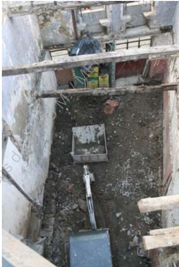
Foto 24 (IMG_7518) – Aspeto da obra após desaterro para ensoleiramento geral (S/N).
