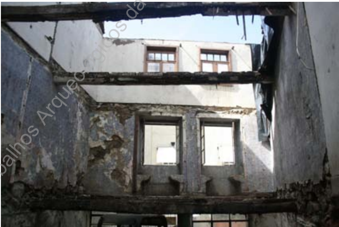
Foto 34 (IMG_7402) – Face interna da fachada principal durante as demolições (S/N).
