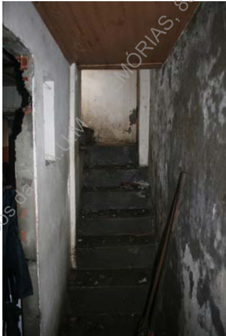
Foto 7 (IMG_7293) – Escada de acesso aos níveis superiores – rés-do-chão (N/S).
