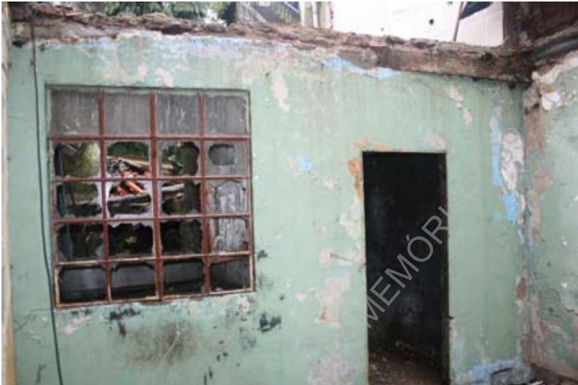
Foto 25 (IMG_7255) – Entrada de compartimento no piso 1 (NE/SO).
