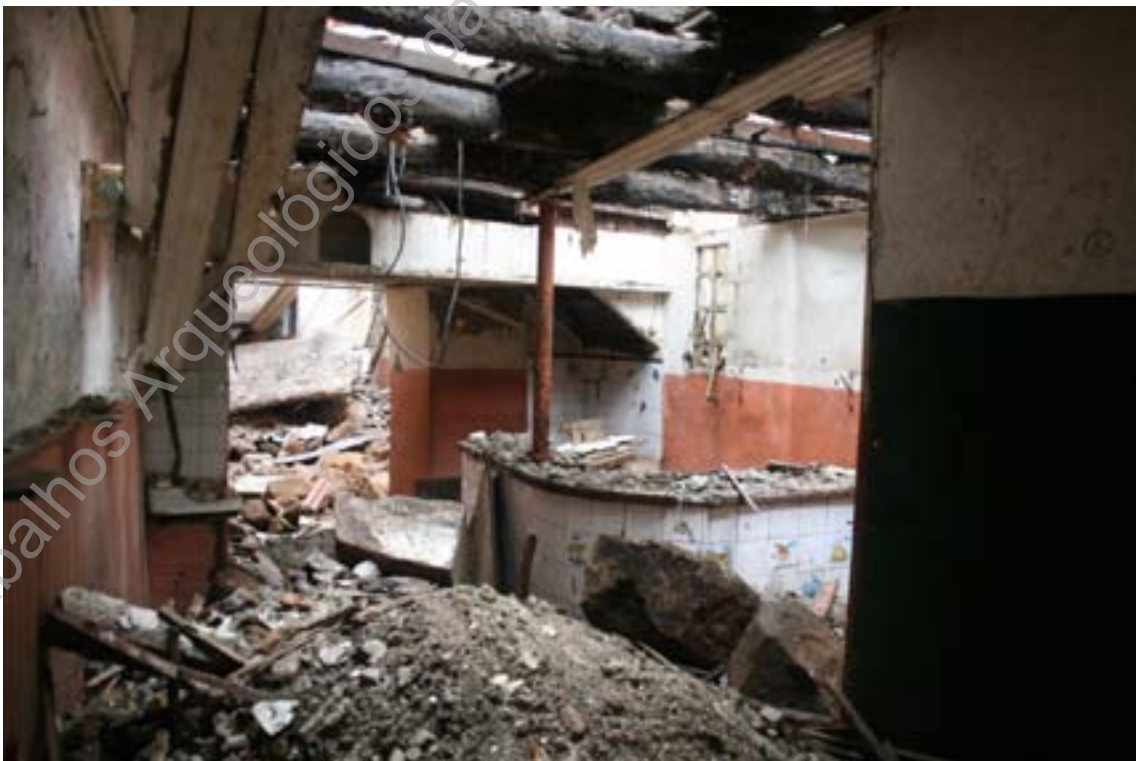
Foto 13 (IMG_7369) – Vista parcial do rés-do-chão (NE/SO).
