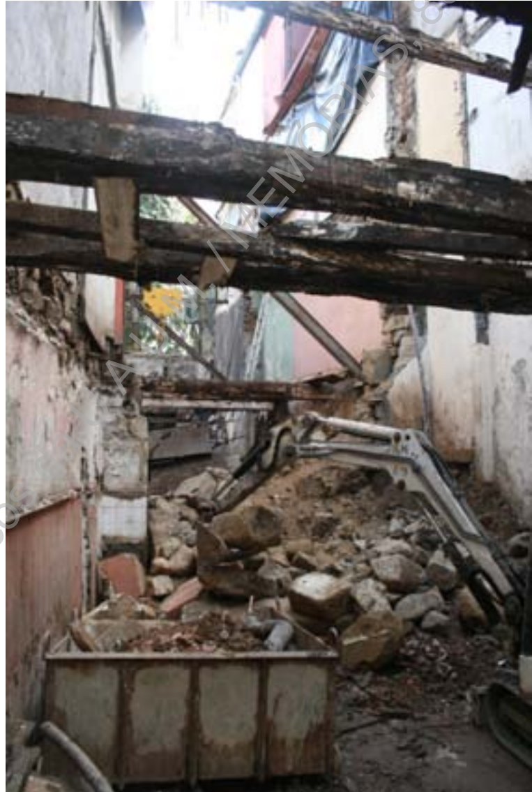
Foto 14 (IMG_7391) – Vista da obra durante a demolição de divisórias em alvenaria (NE/SO).
