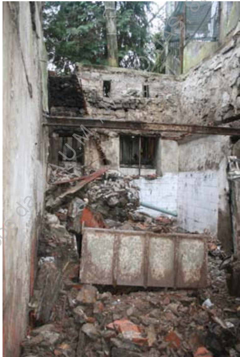
Foto 16 (IMG_7427) – Limpeza dos detritos resultantes da demolição (N/S).
