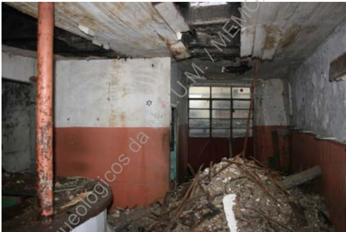
Foto 4 (IMG_7274) – Aspeto do rés-do-chão no início dos trabalhos (S/N).
