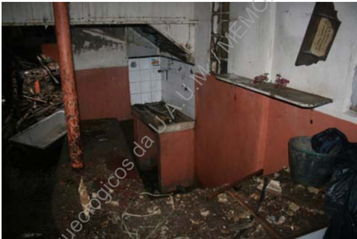
Foto 6 (IMG_7290) – Balcão do antigo estabelecimento comercial que funcionava no rés-do-chão (NE/SO).
