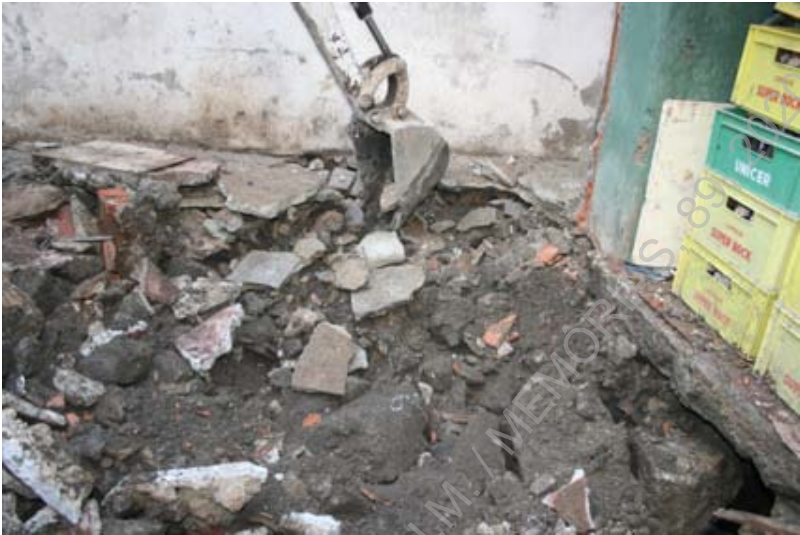
Foto 20 (IMG_7484) – Desaterro para ensoleiramento geral (E/O).
