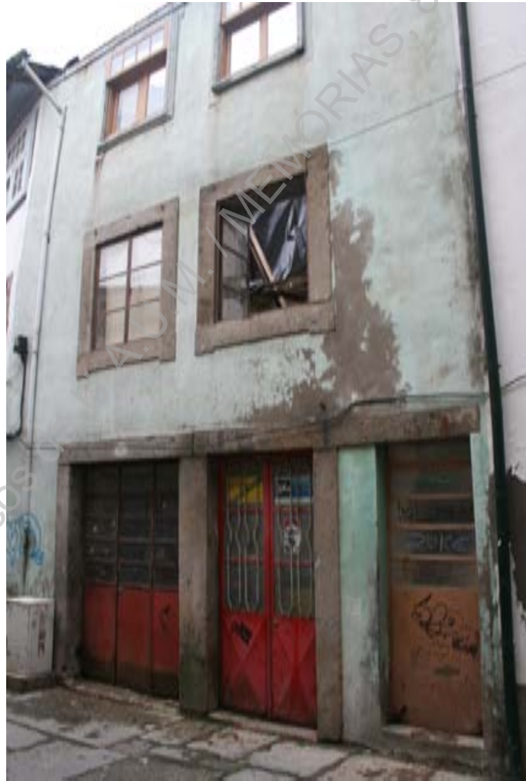
Foto 1 (IMG_7387) – Vista geral da fachada no início da obra (NO/SE).
