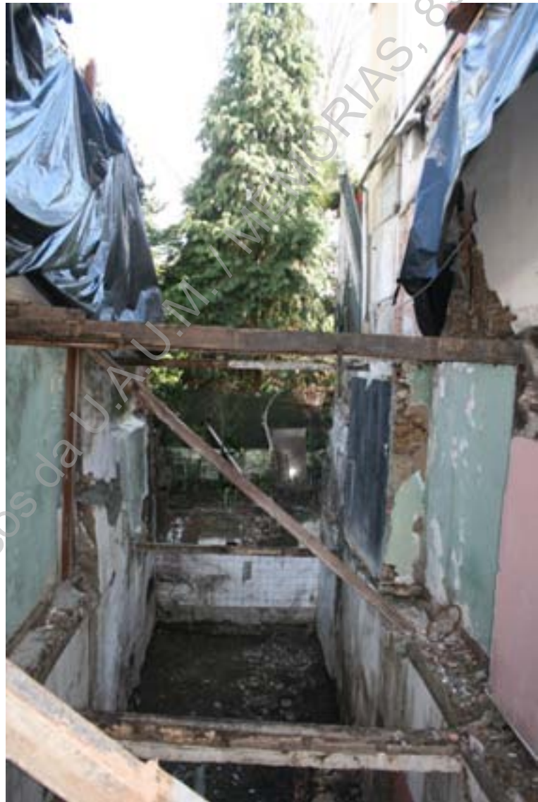
Foto 40 (IMG_7509) – Aspeto geral do prédio após os trabalhos de demolição e escavação (N/S).
