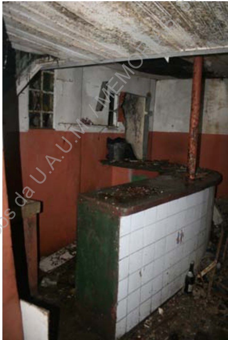
Foto 5 (IMG_7278) – Balcão do antigo estabelecimento comercial que funcionava no rés-do-chão (SE/NO).
