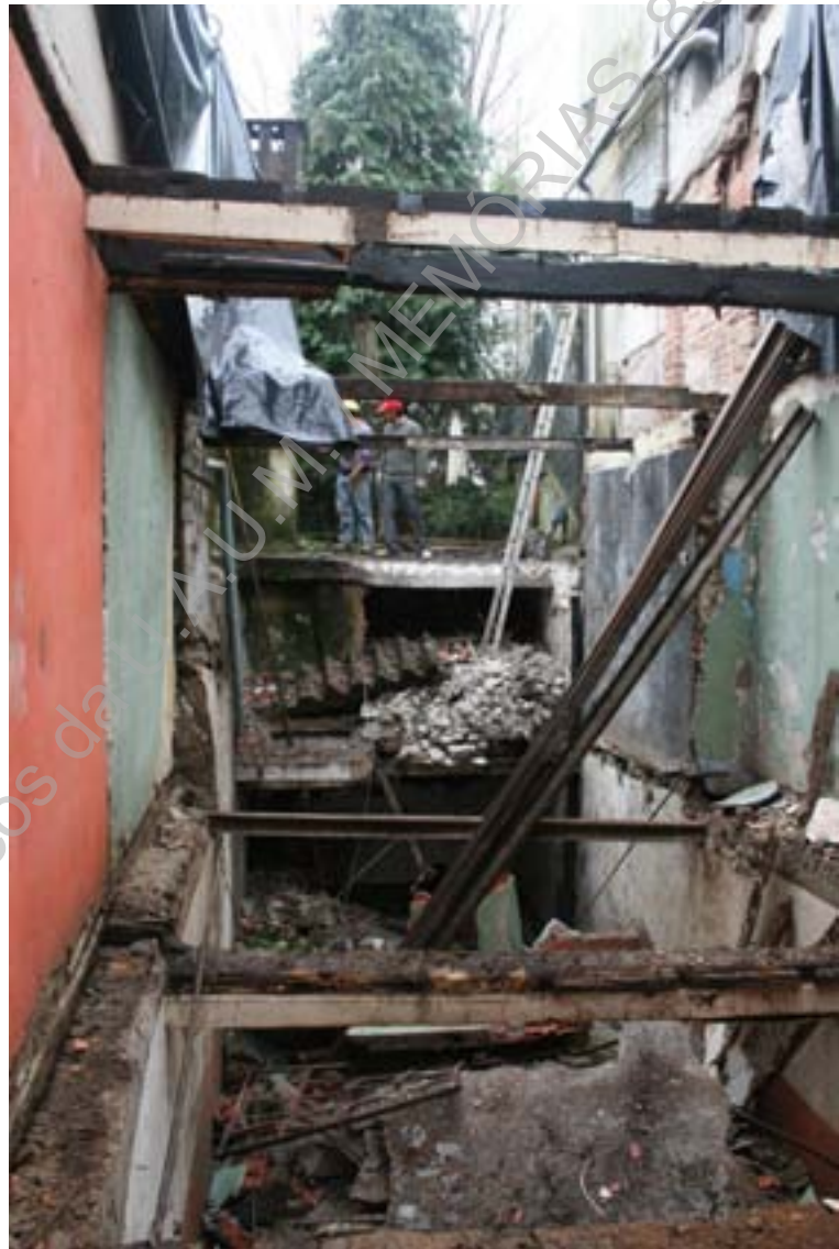
Foto 32 (IMG_7355) – Demolições no piso 1 (N/S).
