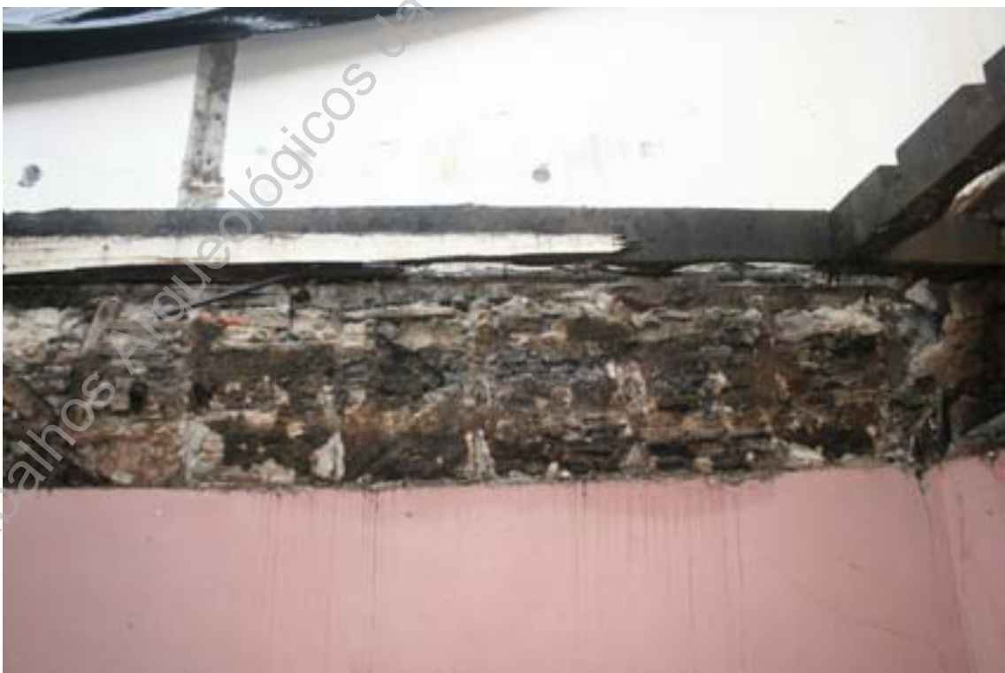
Foto 26 (IMG_7259) – Pormenor de tabique da parede oeste do prédio ao nível do piso 1 (E/O).
