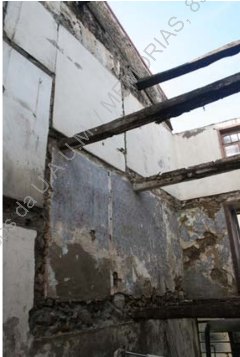
Foto 35 (IMG_7406) – Perspetiva da parede oeste durante dos trabalhos (SE/NO).
