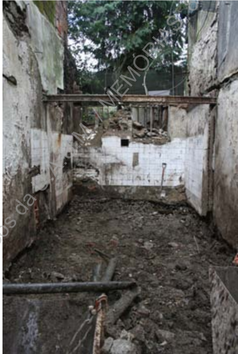
Foto 18 (IMG_7444) – Desaterro do rés-do-chão para ensoleiramento geral (N/S).
