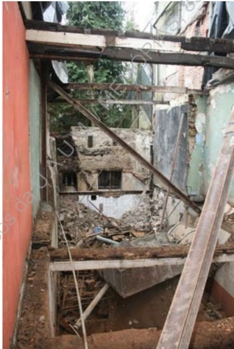
Foto 37 (IMG_7380) – Vista geral do prédio durante as demolições (NE/SO).
