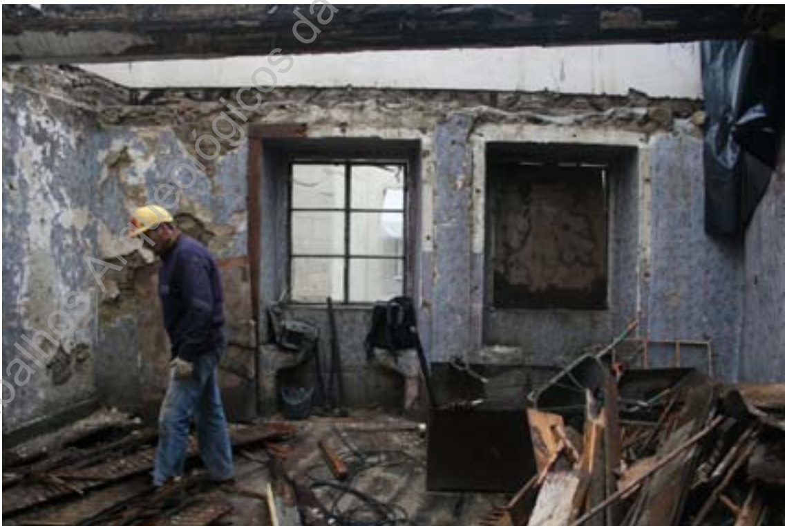
Foto 28 (IMG_7267) – Trabalhos de demolição - remoção de madeiras no piso 1 (S/N).
