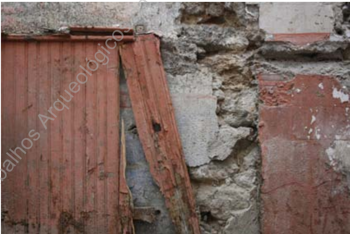
Foto 43 (IMG_7438) – Pormenor construtivo – lambri de madeira e lambri de azulejo sobre parede pintada – parede este (O/E).
