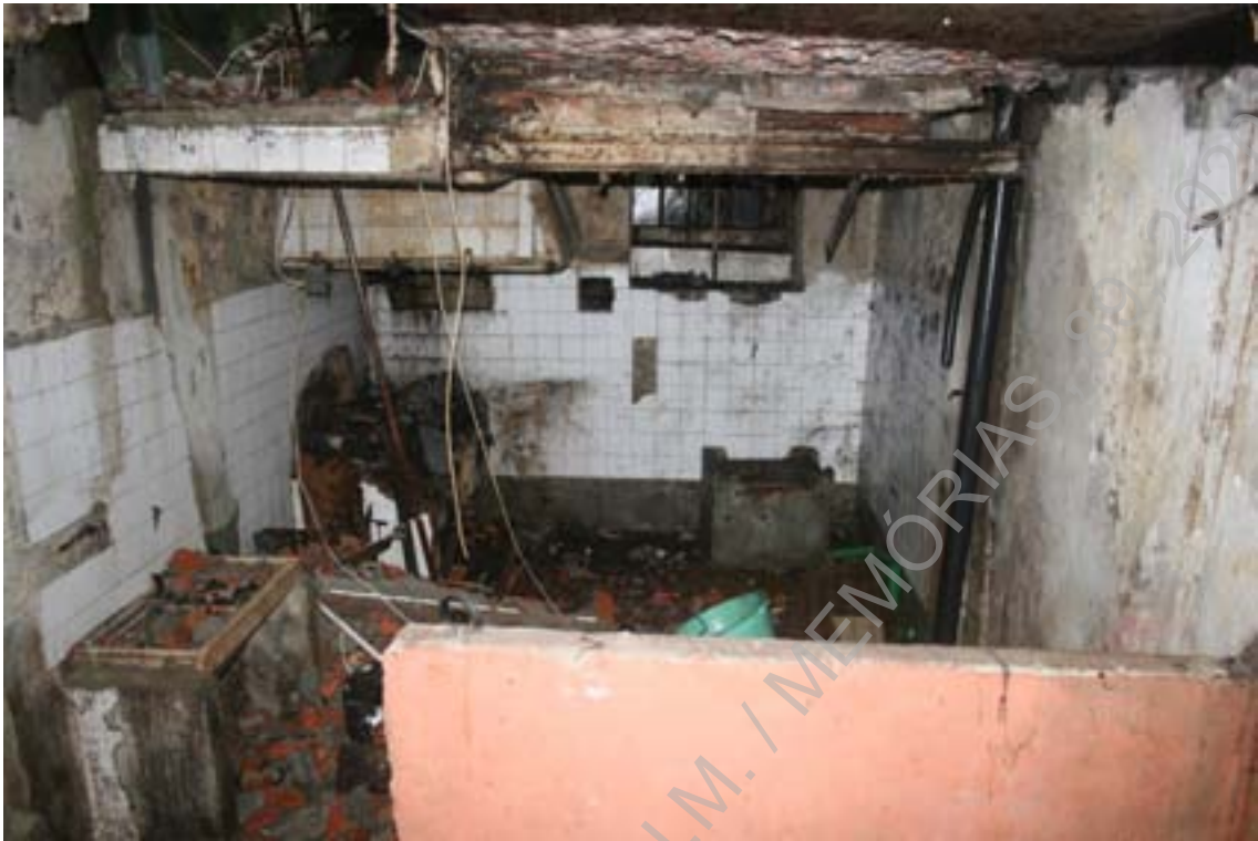
Foto 10 (IMG_7306) – Compartimento no rés-do-chão – cozinha (N/S).
