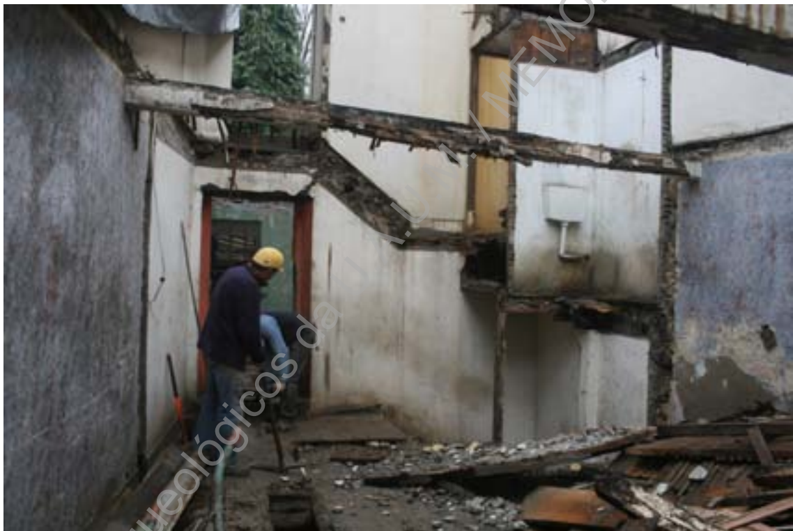
Foto 31 (IMG_7347) – Trabalhos de demolição - remoção de madeiras no piso 1 (NE/SO).
