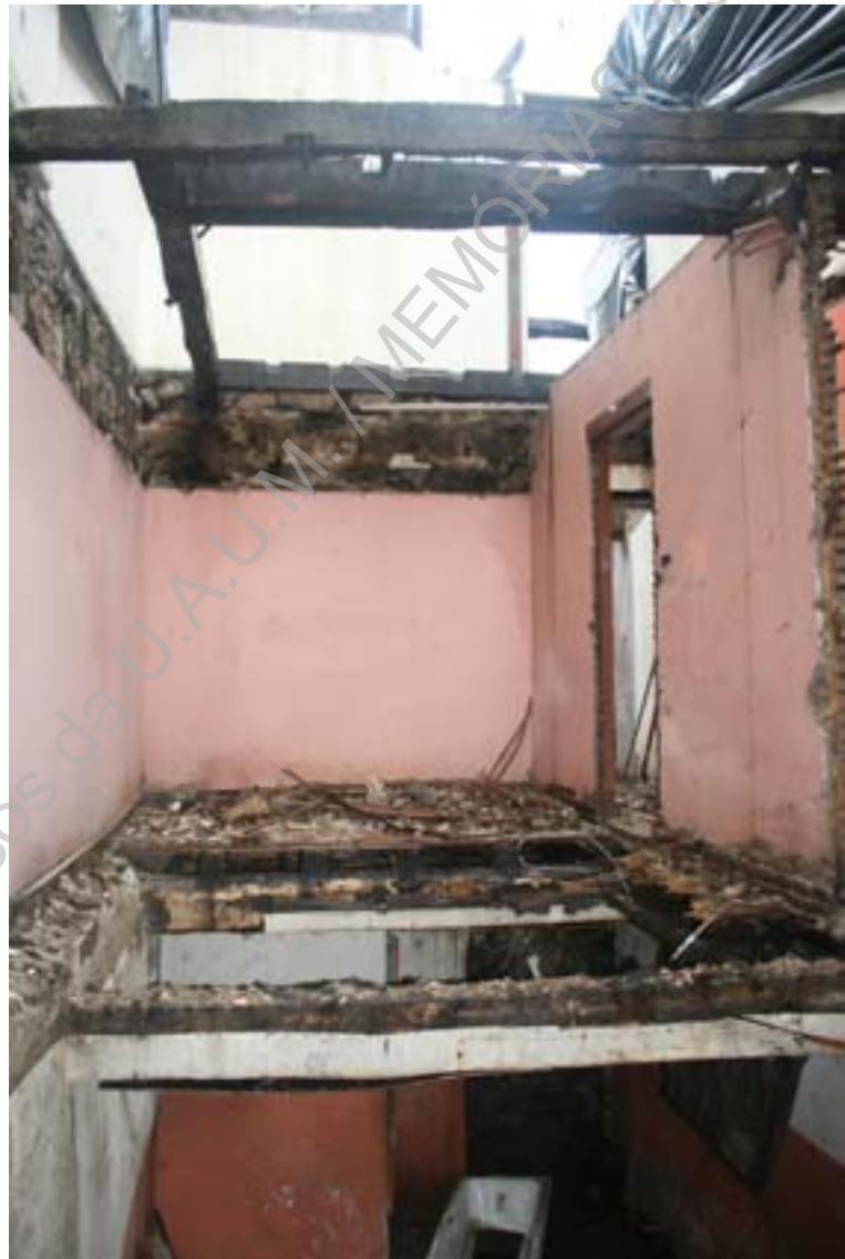
Foto 30 (IMG_7328) – Trabalhos de demolição - remoção de madeiras no piso 1 (S/N).
