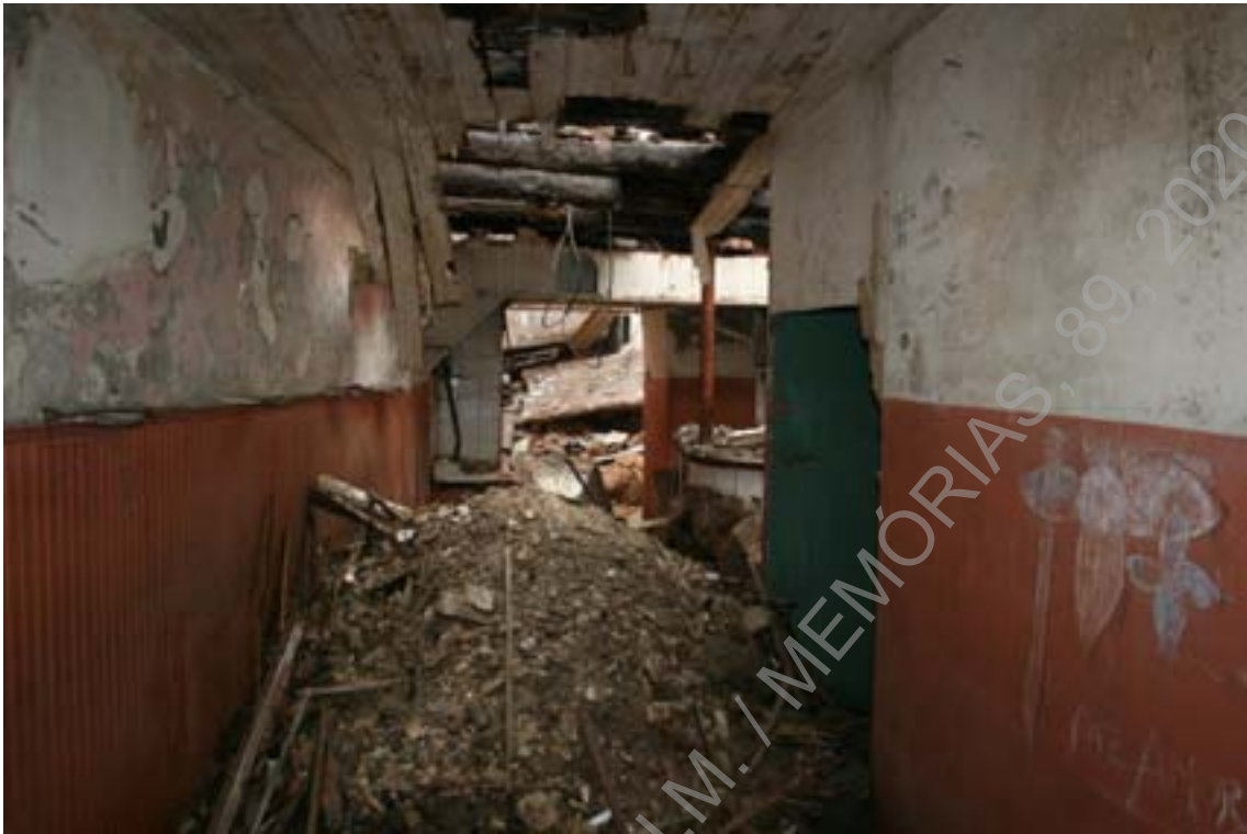
Foto 12 (IMG_7362) – Vista parcial do rés-do-chão (NE/SO).
