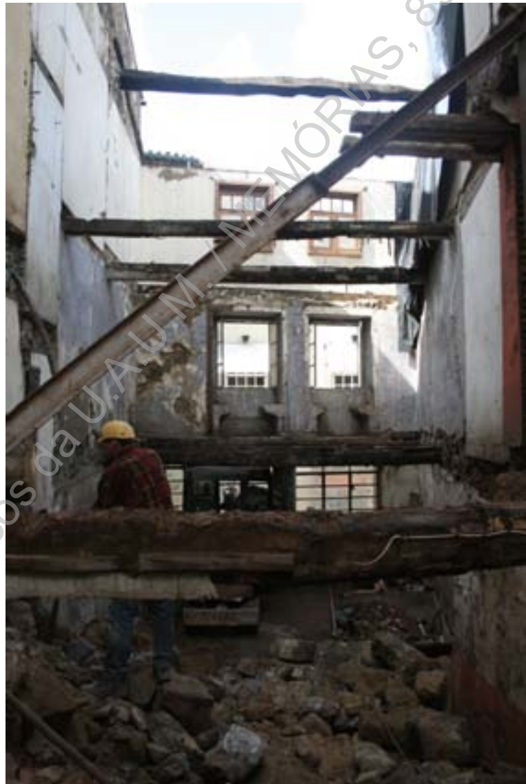
Foto 38 (IMG_7411) – Vista geral do prédio durante as demolições (S/N).
