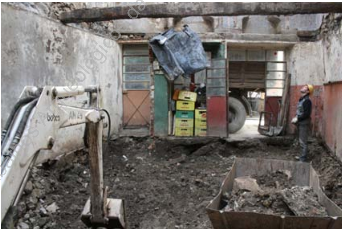
Foto 21 (IMG_7490) – Desaterro para ensoleiramento geral (E/O).
