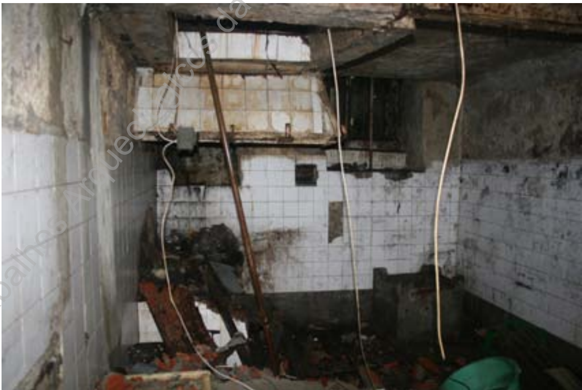
Foto 11 (IMG_7313) – Compartimento no rés-do-chão – cozinha (N/S).
