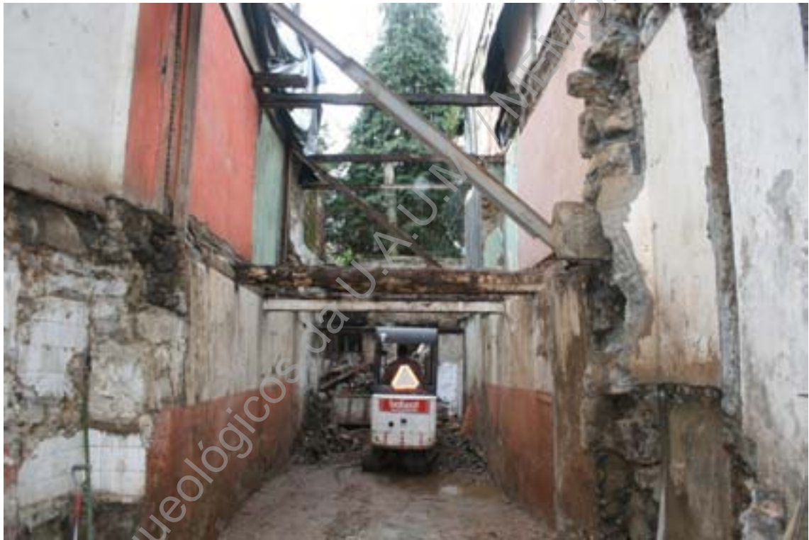
Foto 15 (IMG_7419) – Limpeza dos detritos resultantes da demolição (N/S).
