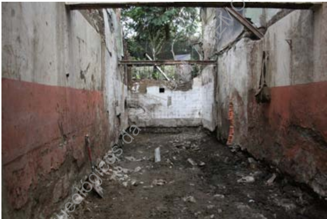
Foto 22 (IMG_7492) – Desaterro para ensoleiramento geral (N/S).
