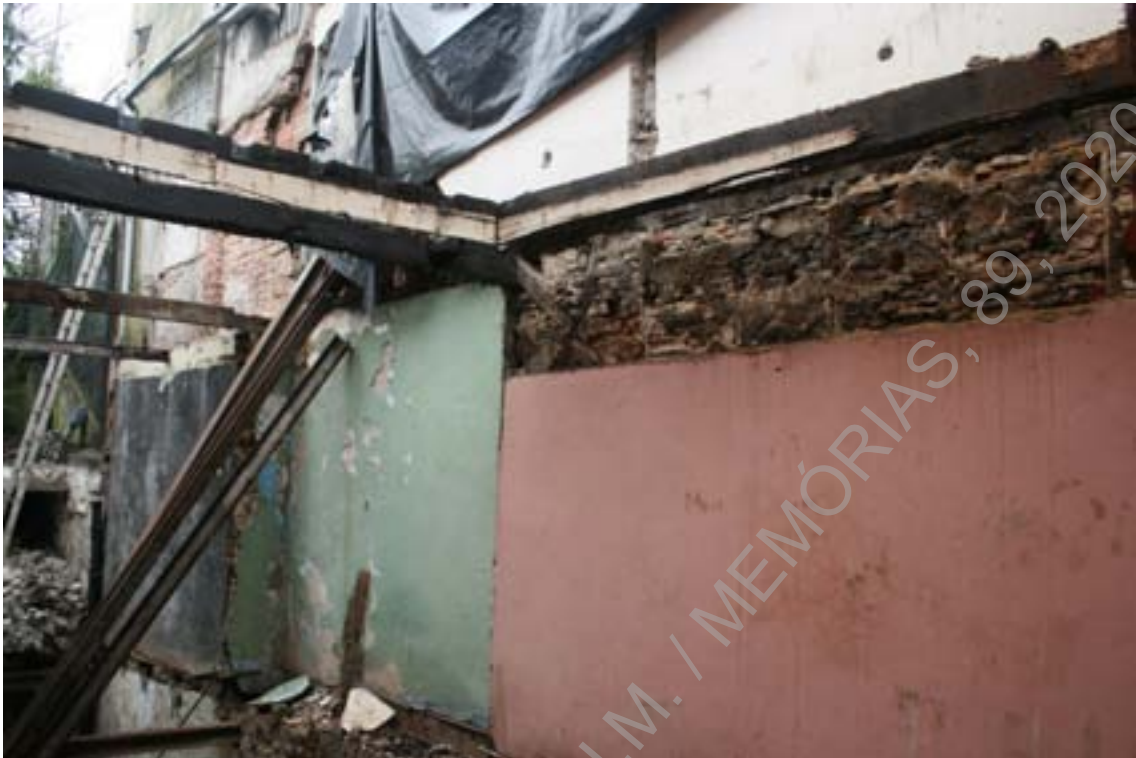
Foto 33 (IMG_7356) – Perspetiva da parede oeste durante dos trabalhos (NE/SO).
