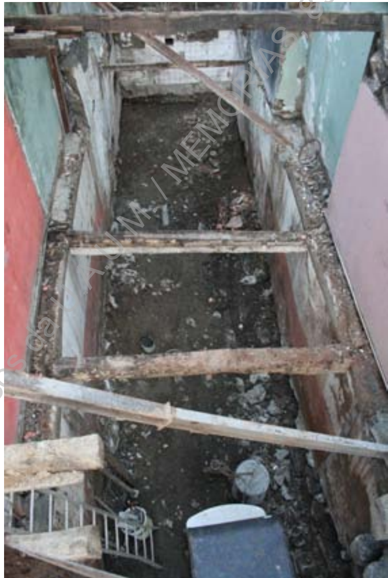
Foto 23 (IMG_7513) – Aspeto da obra após desaterro para ensoleiramento geral (N/S).
