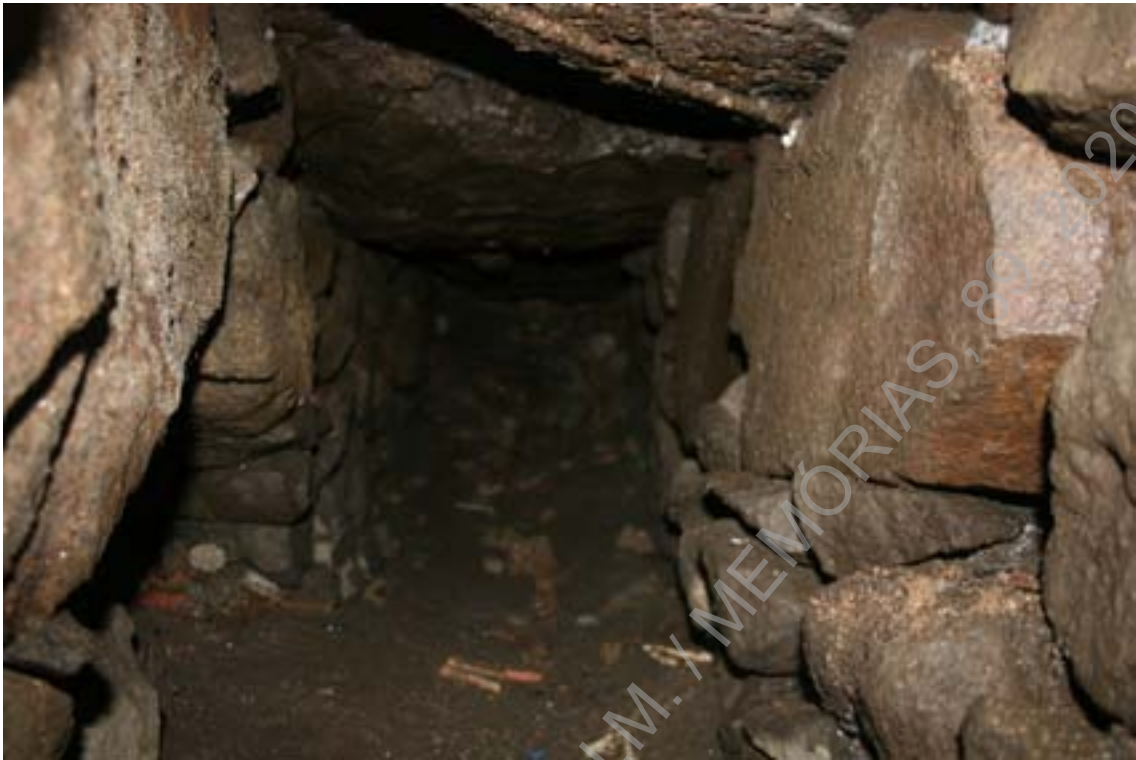
Foto 45 (IMG_7462) – Pormenor construtivo – interior de conduta (S/N).
