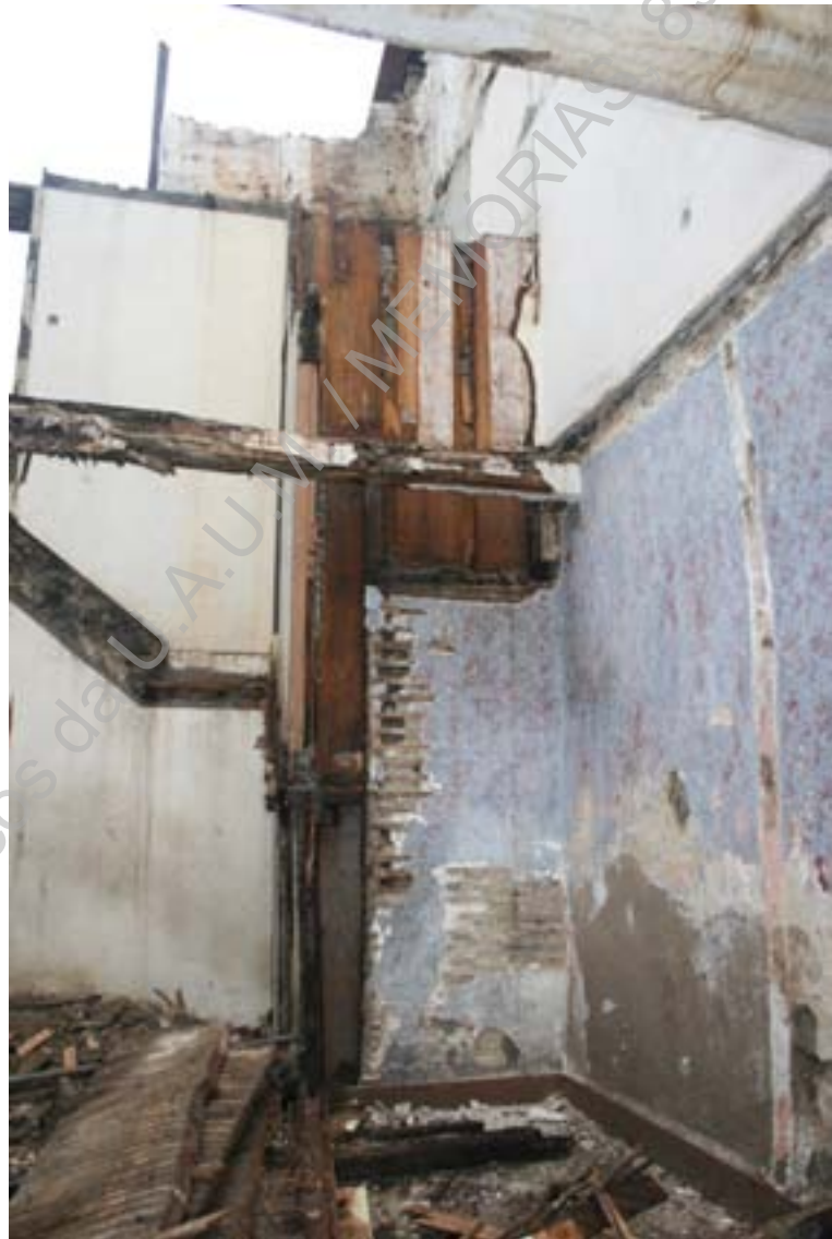
Foto 29 (IMG_7272) – Trabalhos de demolição - remoção de madeiras no piso 1 (NE/SO).
