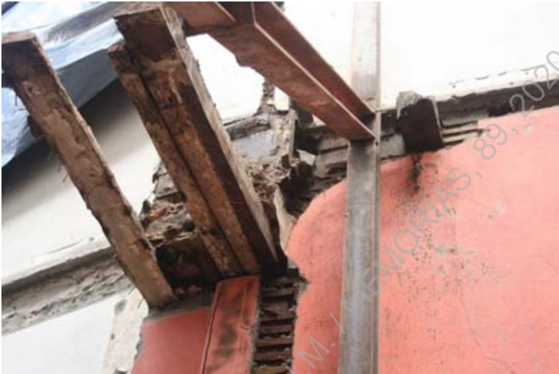
Foto 42 (IMG_7410) – Pormenor de construtivo – restos de vigamento de madeira e escora de contenção (NE/SO).
