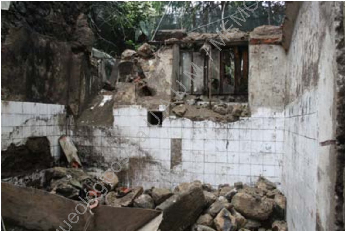
Foto 17 (IMG_7439) – Demolição do muro sul do prédio (NO/SE).
