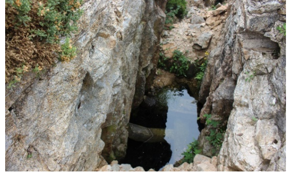
Figura 4.47: Aspeto de fosso associado a uma das entradas das minas dos Carris.
