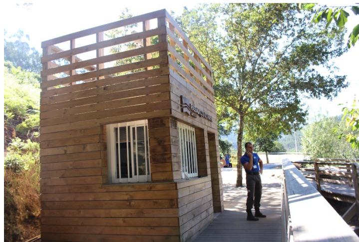
Figura 5.10: Cabine de controlo de visitantes localizada na extremidade norte (Espunca) dos Passadiços do Paiva.
