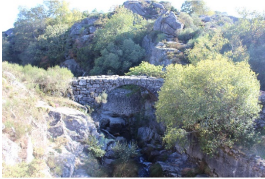
Figura 4.19: Ponte Velha, situada ligeiramente a jusante da cascata do rio Laboreiro.
