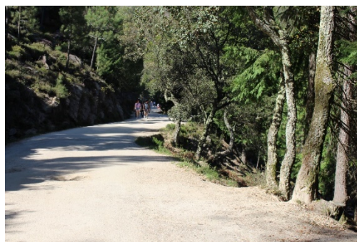
Figura 4.4: Estrada em terra batida de acesso à cascata do Arado.
