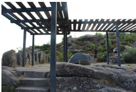
Figura 4.42: Estrutura existente no miradouro da Junceda.
