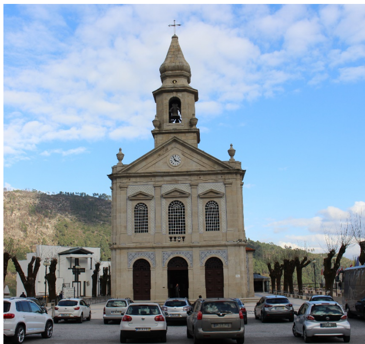
Figura 2.24: Basílica de São Bento da Porta Aberta.
