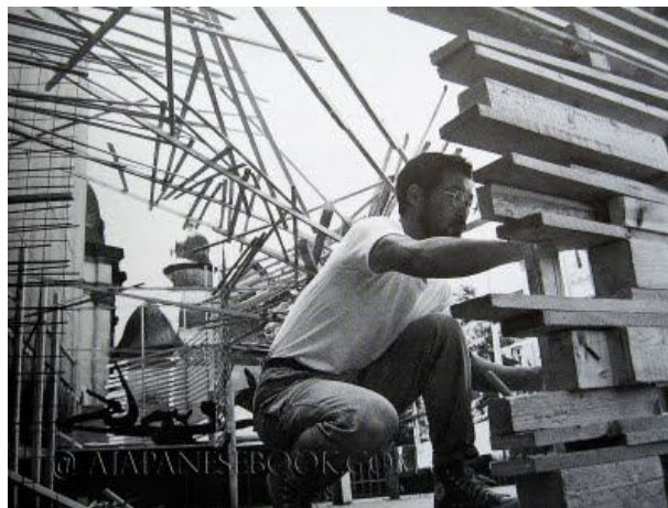
12. Tadashi Kawamata na construção
