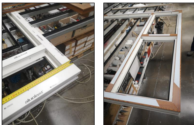
Figura 43 - Inspeção do posicionamento das travessas no caixilho.
