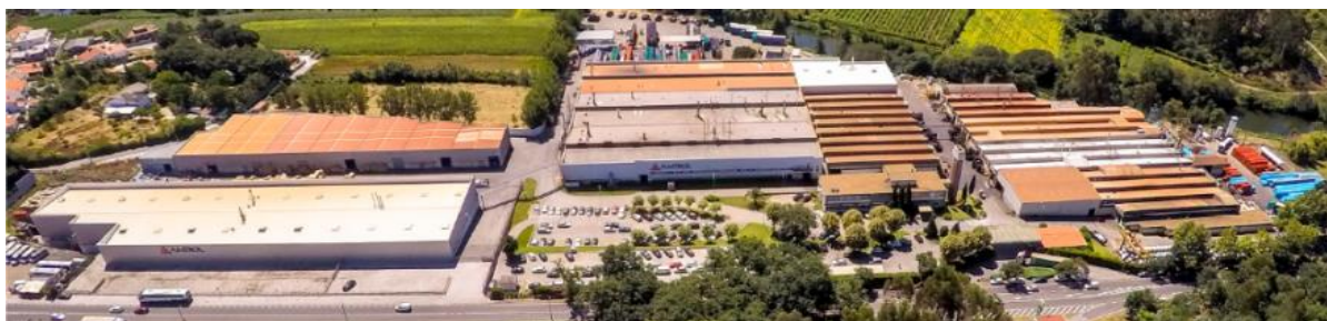
Figura 11: Instalações da Amtrol-Alfa, S.A., Brito, Portugal. Retirado da plataforma interna da Amtrol-Alfa, S.A.
