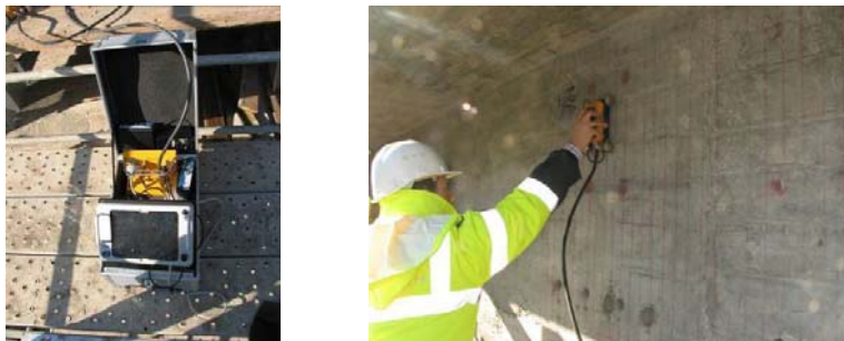
Figura 6 – Unidade de controlo e medição com a antena de 1.6 GHz no painel da viga 1
