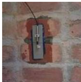
b) Paredes de alvenaria.
