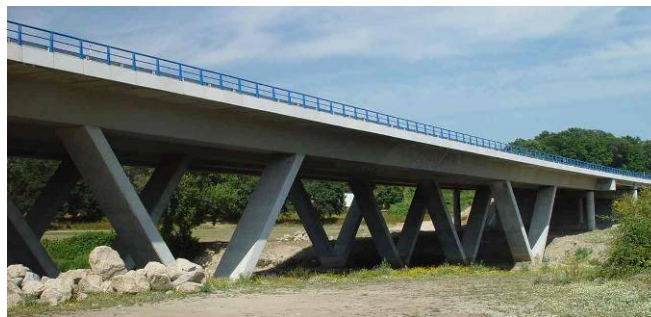
Figura 1 – Ponte sobre o Rio Ave na A11
