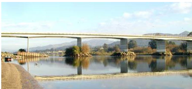
Figura 4 – Ponte de Lanheses
